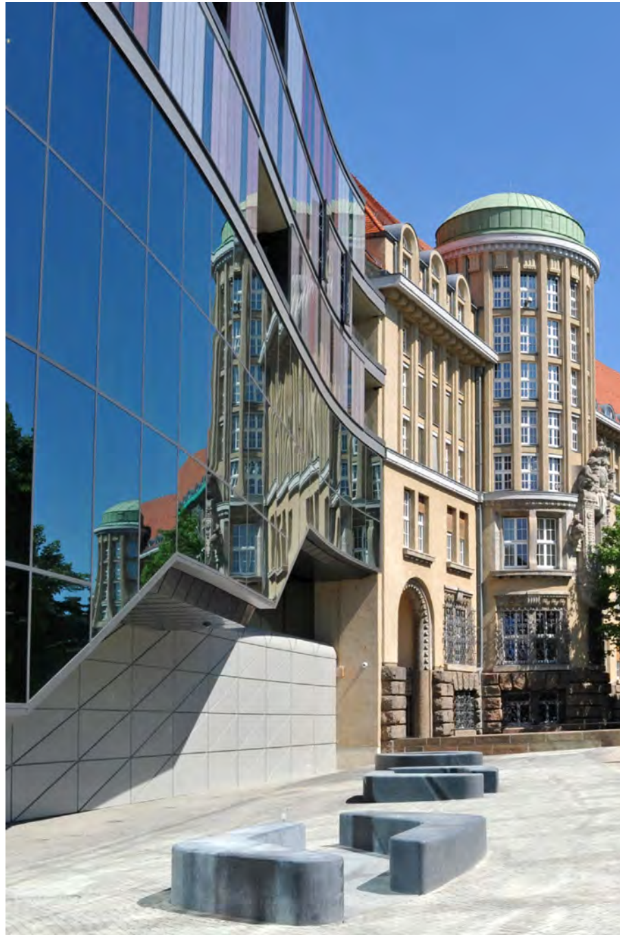
Abb. 6: Fassadenausschnitt Erweiterungsbau und historisches Hauptgebäude 2011
