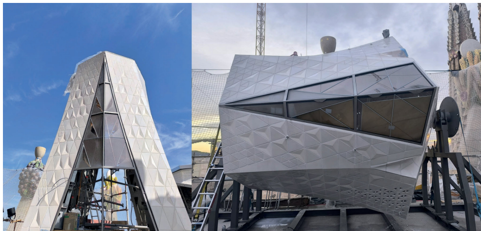
Bild 13. Pyramidenförmige Erhöhungen auf den Fliesen und Glas-scheiben am Fust (links) und am Arm (rechts).
