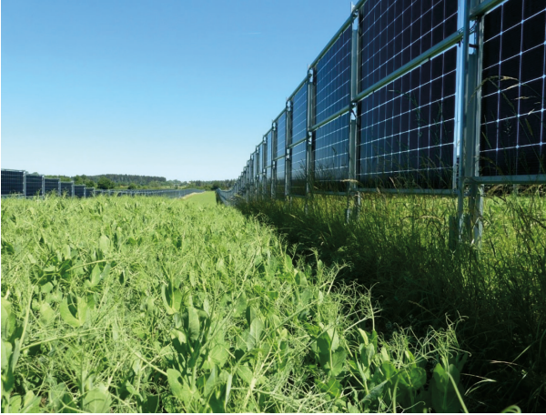
Abbildung 16: Ansicht Erbsenanbau in Agri-PV Anlage (Modulabstand 10 m; Anbaugasse 8 m) in Donaueschingen-Aasen am 14.06.2022 (Blick von Süd nach Nord um 12:00 Uhr).
