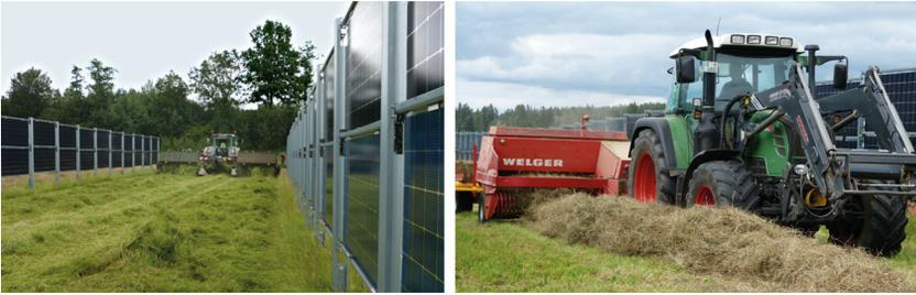
Abbildung 5a und 5b: Voll mechanisierter Grünlandschnitt mit Heubergung in der Anlage mit senkrecht stehenden bifazialen Solarmodulen in Donaueschingen Aasen, 2021 (Foto Müller-Sämman).
