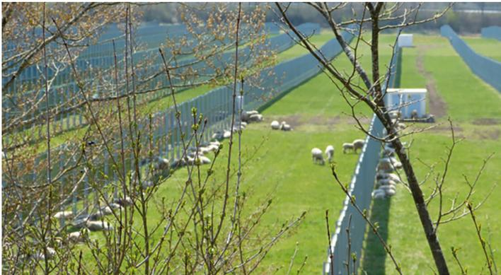
*Abbildung 1: Beispiel einer Agri-Fotovoltaikanlage, die eine „reguläre“ ackerbauliche Nutzung auf der Fläche erlaubt. Kommerzielle Anlage mit senkrecht stehenden bifazialen Modulen in Donaueschingen-Aasen (Foto Müller-Sämman).*
