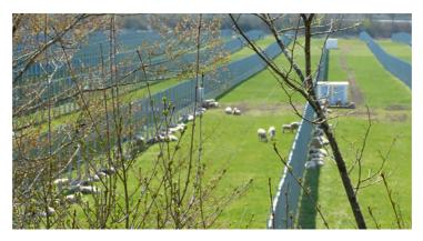
Abbildung 1: Beispiel einer Agri-Fotovoltaikanlage, die eine "reguläre" ackerbauliche Nutzung auf der Fläche erlaubt. Kommerzielle Anlage mit senkrecht stehenden bifazialen Modulen in Donaueschingen-Aasen (Foto Müller-Sämann).
