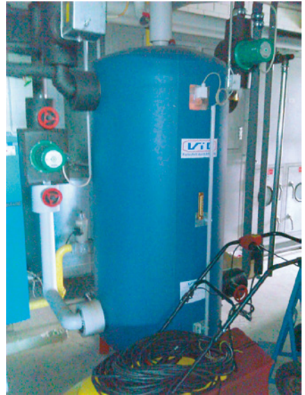
Abbildung A15: Pufferspeicher, links Sekundärpumpe mit Umlenkenventil, rechts Primärpumpe
