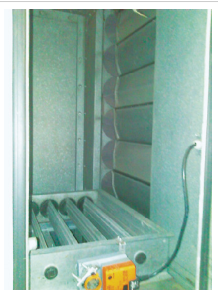
Abbildung A4: Fortluftklappe, geschlossen. Umluftklappe, 100 % offen
