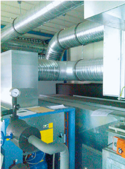
Abbildung A14: Außenluftansaugung durch zwei Wickelfalzrohre
