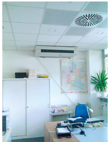
Abbildung A17: Umluftkühlgerät (Anschluss an VL Sekundärpumpe)
