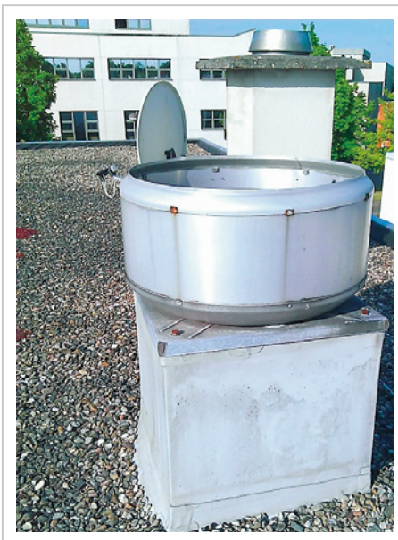
Abbildung A11: Abluftventilator WC, Duschen und Küche
