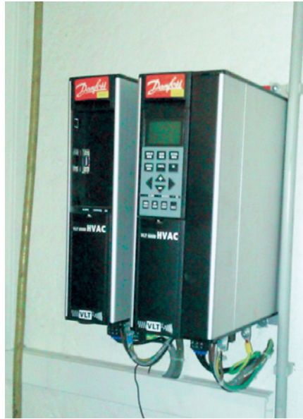
Abbildung A6: FU-Steuerung der Abluft und Zuluft, nachgerüstet
