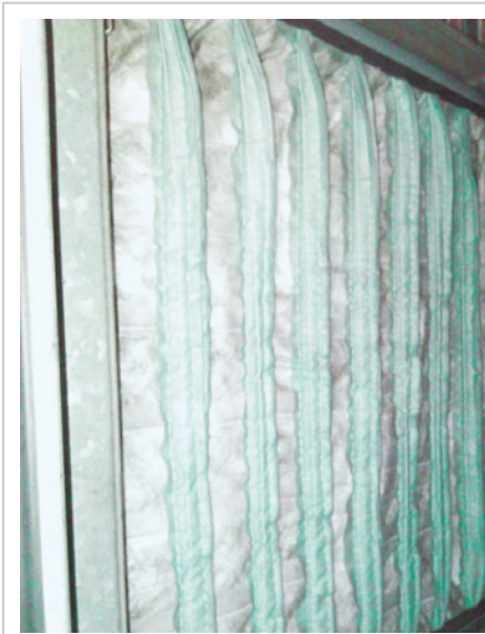
Abbildung A9: Außenluftfilter, Wartungszustand gut
