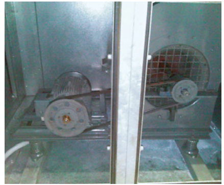
Abbildung A2: Abluftventilator mit Antrieb, guter Reinigungszustand
