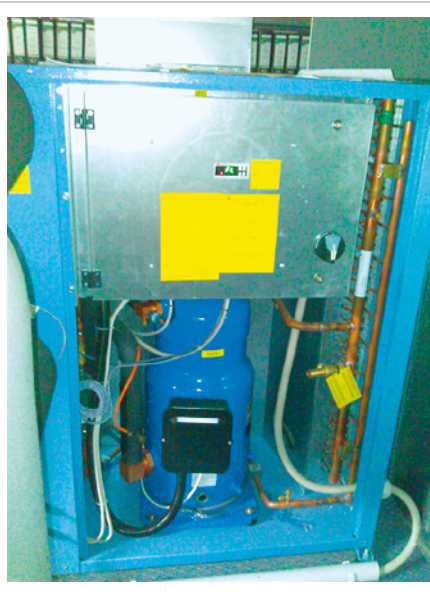
Abbildung A13: Detailansicht des Scrollverdichters
