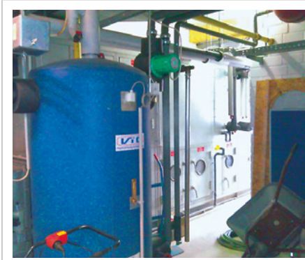
Abbildung A1: Bedienseite RLT-Gerät
