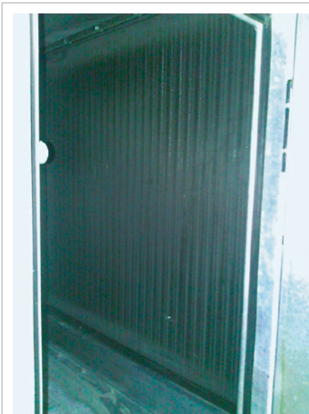
Abbildung A3: Heizregister, Abströmseite im guten Reinigungszustand
