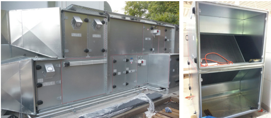
Abbildung 44: Außenaufgestellte Lüftungsanlage mit Wärmerückgewinnung und Kreuzstromwärmetauscher bei der Montage [Fotos: Achim Hamann]
