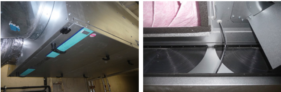
Abbildung 47: Kompaktlüftungsgerät mit Doppel-Rotationswärmetauscher [Fotos: Achim Hamann]
