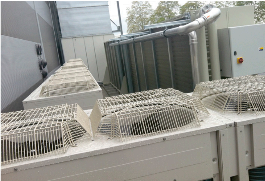
Abbildung 65: Wärmepumpenanlage und Rückkühler für Prozesskälte [Foto: Achim Hamann]
