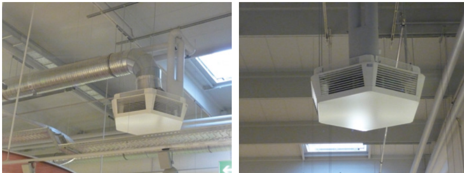
Abbildung 49: Luftheizer mit Mischluft- und Heizkreisanschluss bzw. als Umluftvariante nur mit Heizkreisanschluss [Fotos: Achim Hamann]
