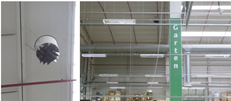
Abbildung 46: Deckenventilator bei hohen Hallen zur Rückführung des Wärmepolsters im Deckenbereich in den Aufenthaltsbereich [Fotos: Achim Hamann]
