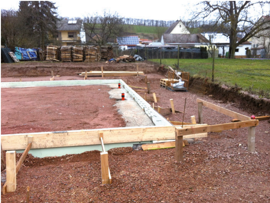
Abbildung 33: Aktuelles Negativbeispiel Wärmebrücken Bodenplatte/Wände [Foto: Achim Hamann, Aufnahmedatum 07.02.2016]
