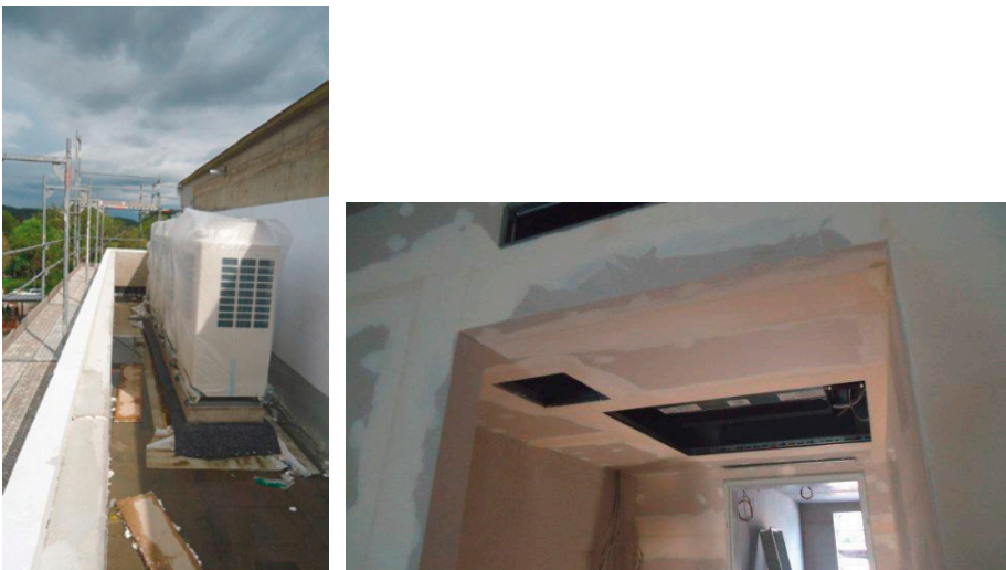
Abbildung 48: Luft-Luft-Wärmepumpe als Außeneinheit und eingebautes Deckeninnengerät mit Frischluftzufuhr zum Heizen und Kühlen (VRF-System) [Fotos: RS-Plan AG]
