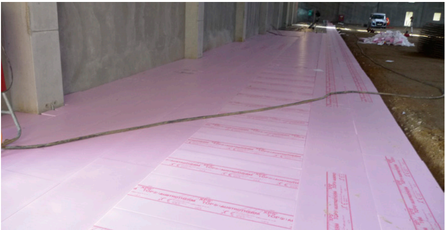
Abbildung 61: Randdämmung [Foto: Achim Hamann]
