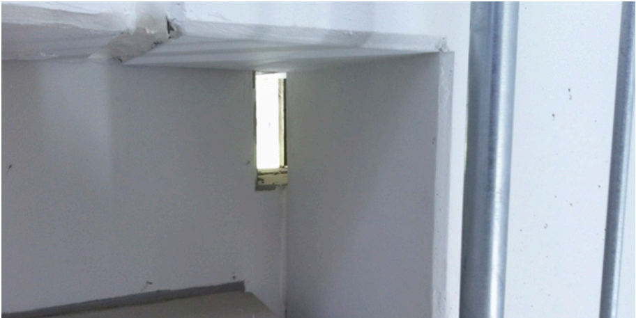
Abbildung 63: Unplanmäßige Öffnung in einer Fertigteilkonstruktion [Foto: Achim Hamann]
