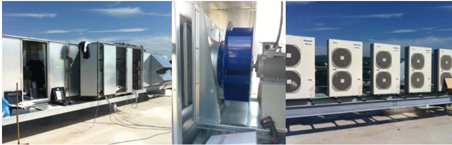
Abbildung 41: Lüftungsanlage mit Luft-Luft-Wärmepumpe (Direktverdampfung) [Fotos: Achim Hamann]
