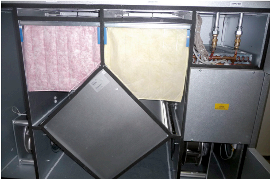
Abbildung 45: Kompaktlüftungsgerät, Wärmerückgewinnung und Heizregister [Foto: Achim Hamann]
