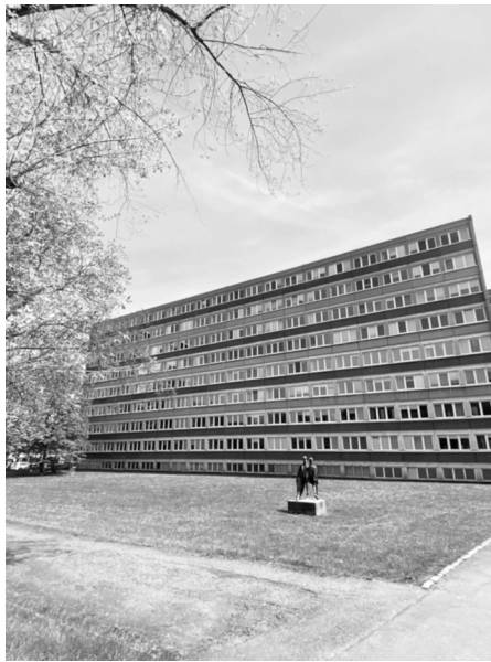
Abbildung 7: Ehemaliges Internatsgebäude in der Reichenhainer Straße 39.
