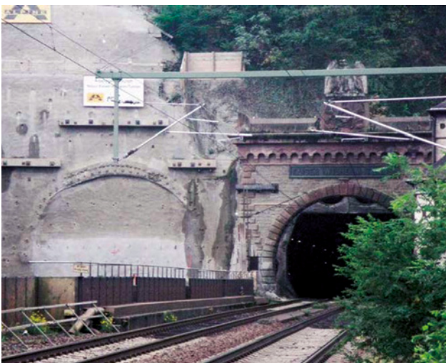
Abb. 3 Portal Kaiser-Wilhelm-Tunnel auf der Cochemer Seite mit Blick auf die Lüftungsanlage
