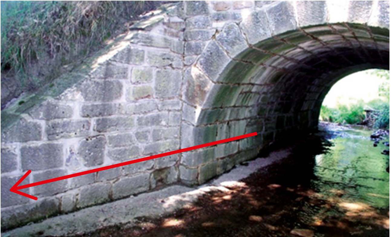
Abb. 7 Ansicht des Bogens und der Auflagerwand mit unbekanntem Aufbau der Böschung und unbekannter Wandstärke; Pfeil gibt Lage der später dargestellten Radarmessspur an.
