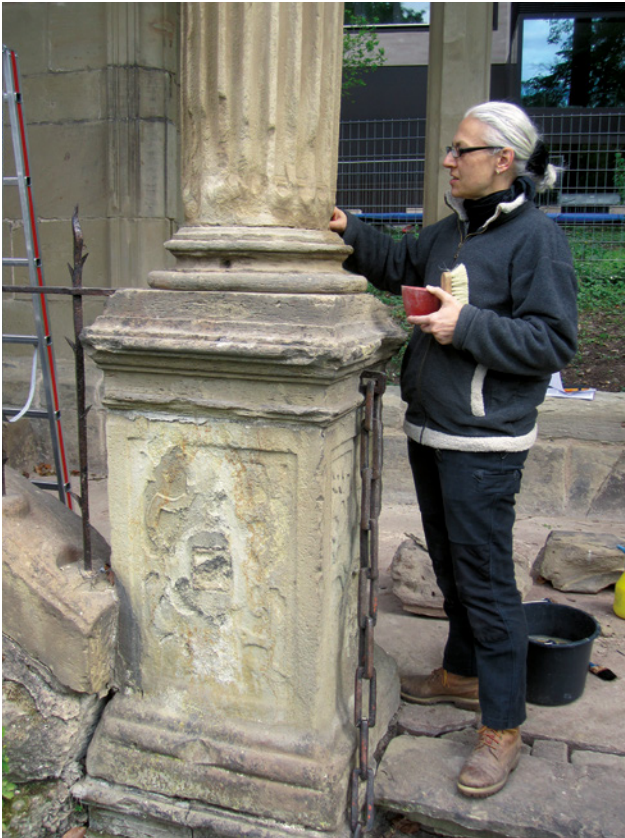
Abb. 19 Kittungsarbeiten Bauabschnitt 2, 2013
