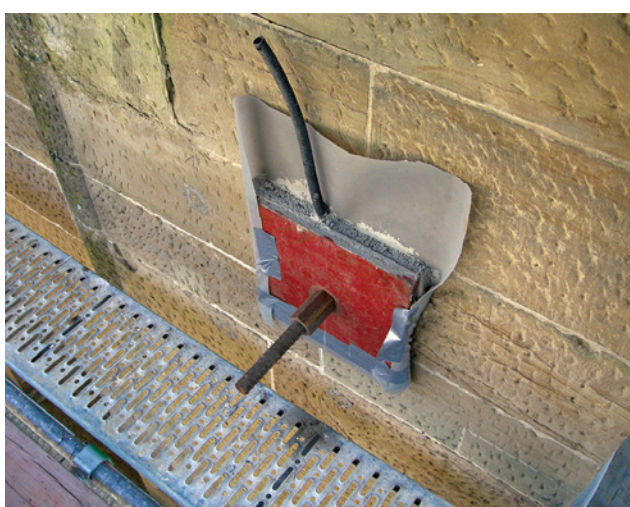
Abb. 26 Rückverankerung außen
