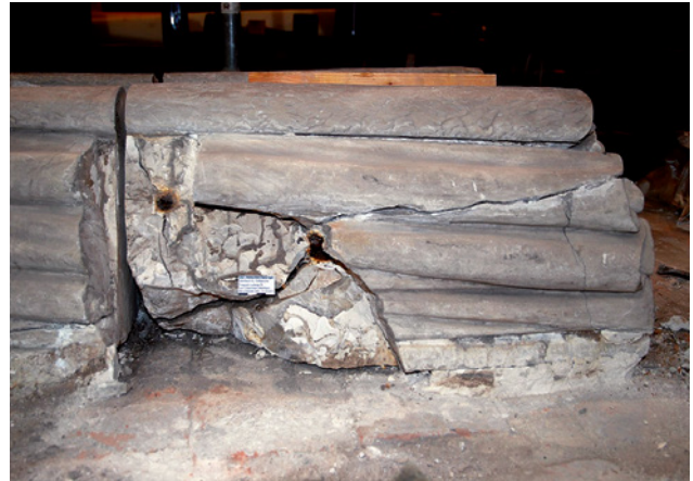
Abb. 2 Zerstörungen an Teilen des Grabmales durch stark korrodierte Metallstifte und Klammern
