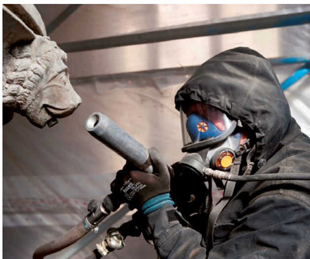
Abb. 13 Reinigung Dreischalenbrunnen
