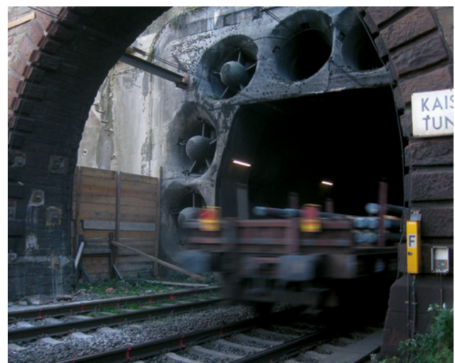
Abb. 2 Portal Kaiser-Wilhelm-Tunnel auf der Cochemer Seite mit Blick auf die Lüftungsanlage
