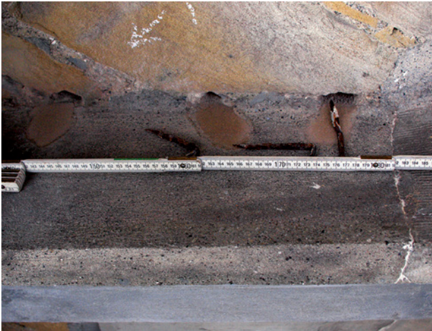
Abb. 11 Rückverankerungen von Betonteilen, die ausgebaut wurden. Nordturm Nordseite
