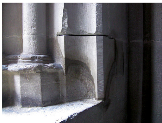
Abb. 10 Passgenaue Vierung Kreuzgang West
