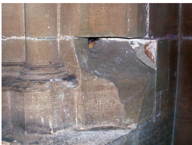
Abb. 9 Fehlstelle Kreuzgang West
