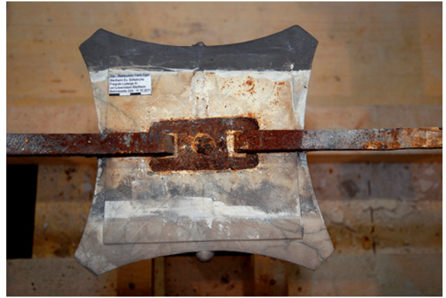
Abb. 29 Aufbau der Zugankersysteme in den Säulen
