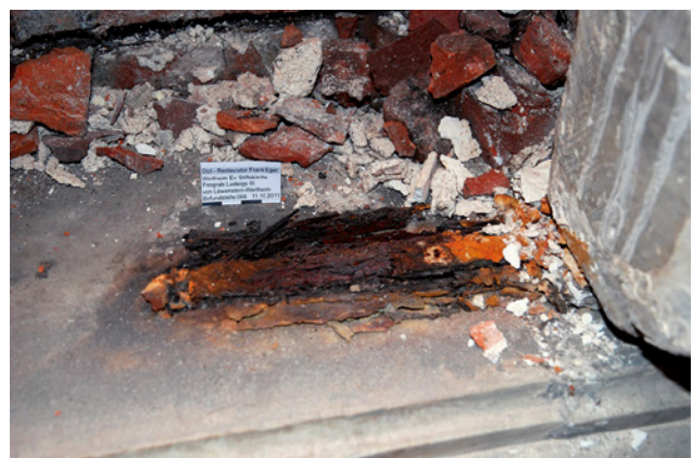
Abb. 8 b Reste der korrodierten Eisen als Ursache der Verformungen
