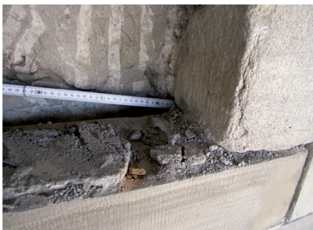
Abb. 3 Nicht hinterfüllter Steinaustausch der 1980er Jahre, Sondageöffnung am Mittelbau
