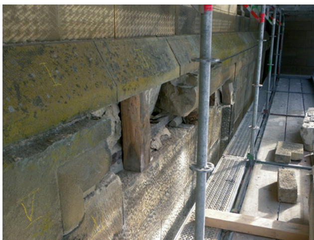
Abb. 24 Ausbau Gesims zwischen EG / OG
