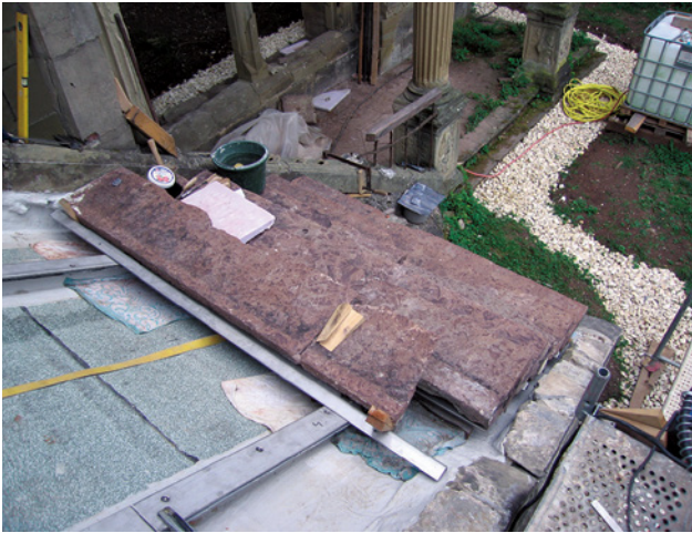
Abb. 15 Treppe während der Versetzarbeiten mit quer verlaufenden Auflagern 2010
