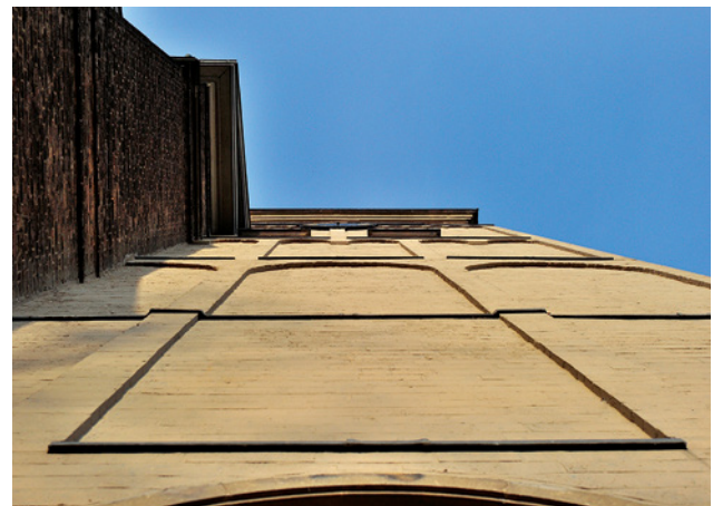
Abb. 6 Zustand des Anstrichsystems auf der Ostfassade von St. Stephanus im Gesamteindruck; dieser stellt sich trotz punktueller Fehlstellen als überwiegend positiv dar.
