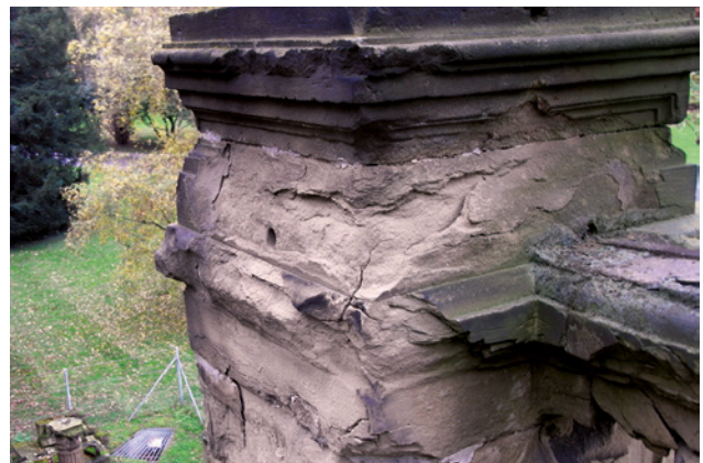
Abb. 8 Schäden an Postamentsadeckung 2008
