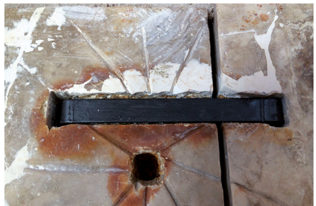
Abb. 33 Neue Verklammerung aus Edelstahl, zusätzlich mit PU-System beschichtet. Der beschädigte Alabaster wurde mit Anstrichmörtel ergänzt.
