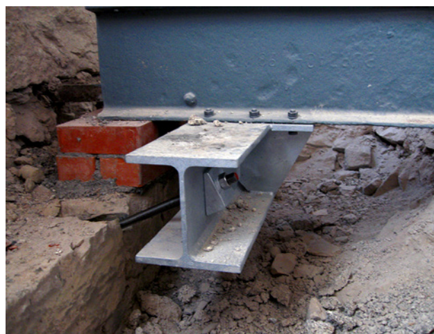
Abb. 25 Rückverankerung innen
