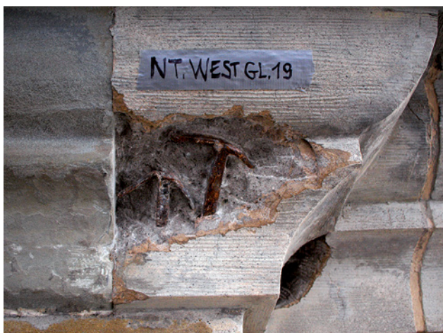
Abb. 9 Sondagebefund: Unkonventionelle Bewehrung am zweischichtig aufgebauten Betongesims, das unvermittelt in Natursteinpartien übergeht. Nordturm Westseite
