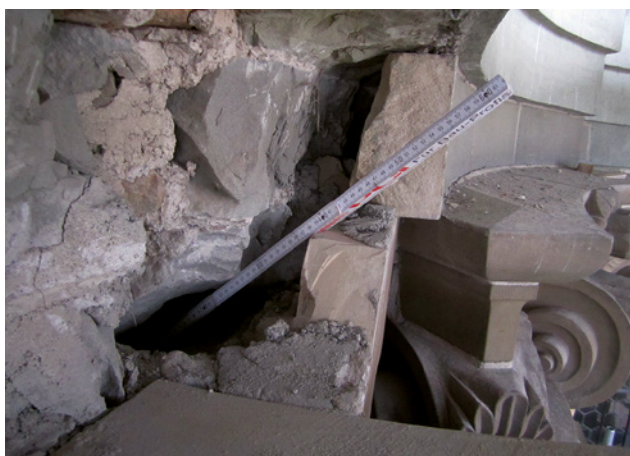
Abb. 5 Nicht hinterfüllte Steinaustauschungen der 1980er Jahre, Sondageöffnung Kapitelle Mittelbau
