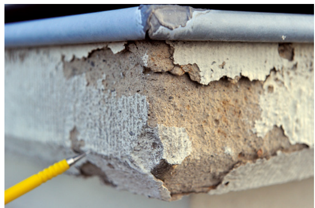
Abb. 10 Abgängiger Dispersionssilikatanstrich nach 24 Jahren Standzeit. Auffallend die Schalenbildung unterhalb des Anstrichs
