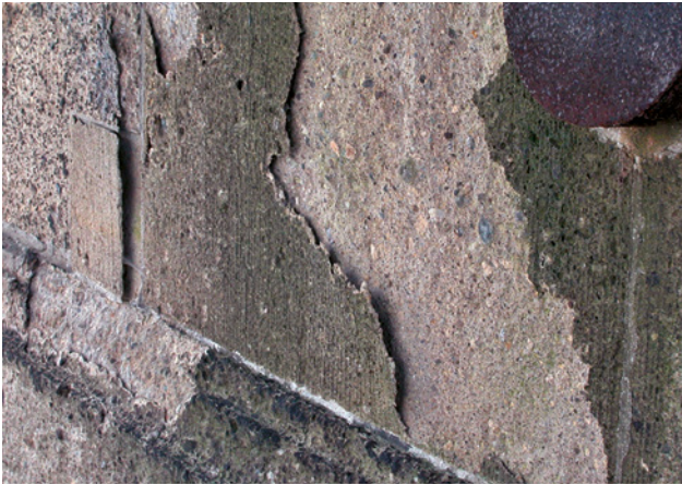
Abb. 1 Schalenbildung in großem Maßstab, ausgelöst durch Eintrag einer hydrophoben Imprägnierung am Beispiel des Charlottenburger Tors Berlin (siehe REISSIG 2008 [2])
