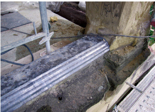
Abb. 17 Bleiabdeckung zum Anschluss an Bitumenabdichtung 2010
