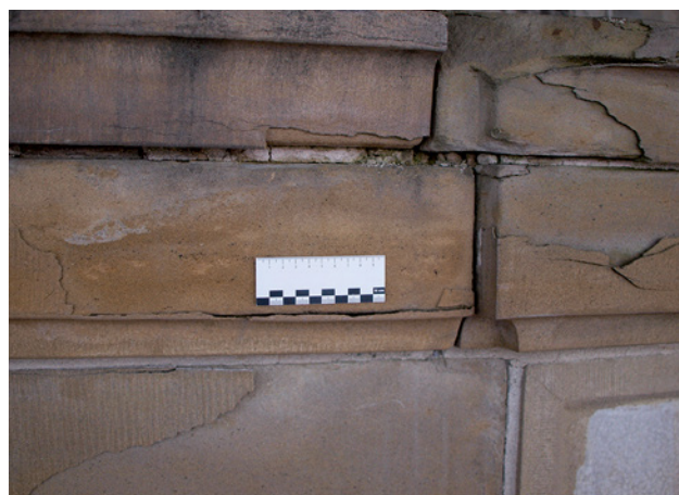
Abb. 6 Vorzustand – Hydrophobierungsschäden der 1980er Jahre, Hauptkranzgesims Mittelbau, dünne Schalenbildungen bis in die Tiefe der Hydrophobierung
