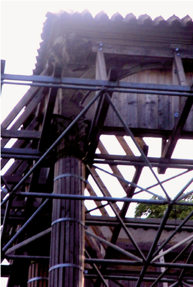
Abb. 6 Hilfskonstruktionen Zustand 2008
