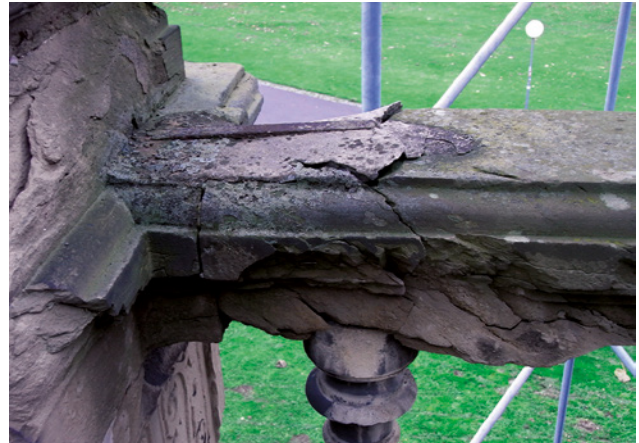
Abb. 7 Schäden an Balustradenabdeckung 2008
