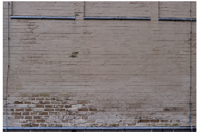
Abb. 8 Das Gesamtbild der besonders stark geschädigten erhöhten Sokkelzone der Westfassade – der Schädigungsgrad der Westfassade ist signifikant höher als in der Ostfassade.
