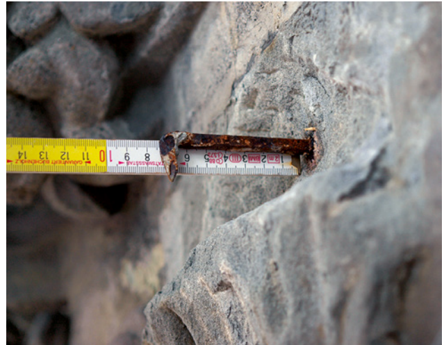
Abb. 14 Korrodierte Bewehrung einer Kunststeinantragung, Einbund in den Stein: i. d. R. ca. 2 cm
