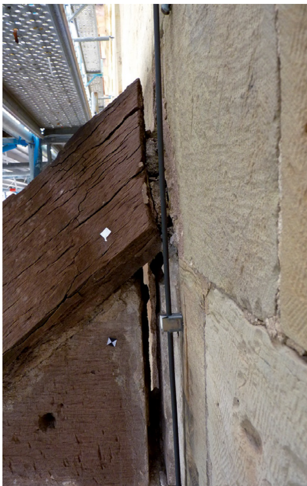
Abb. 18 Anschluss Strebebogen an Obergaden Süd
