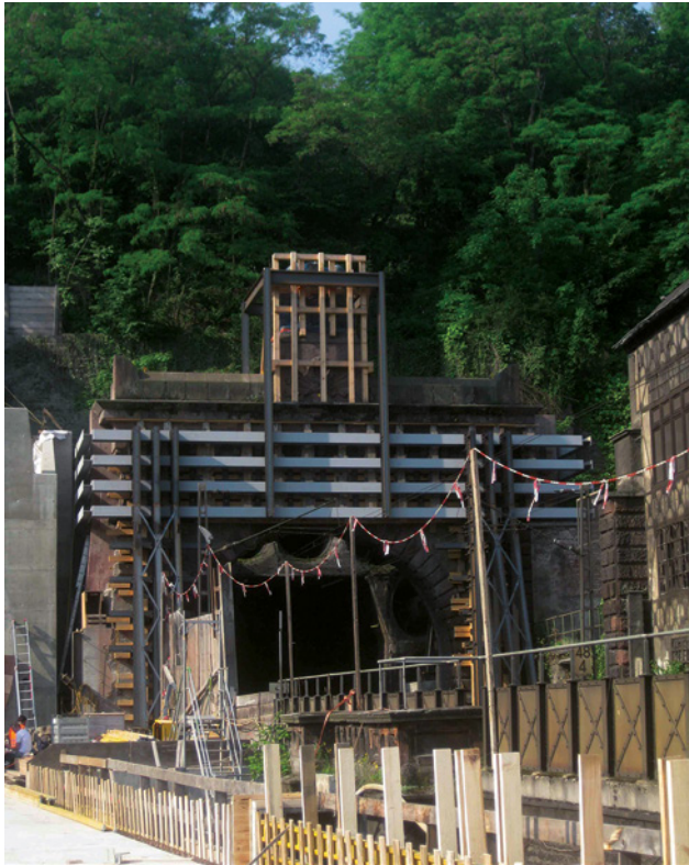
Abb. 10 Notgesichertes Nordportal des Kaiser-Wilhelm-Tunnels
