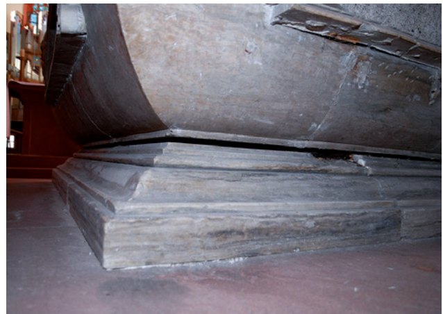
Abb. 8 a Gut sichtbare Verformungen am Sockel des Grabmals (ehemals Pressfugen)
