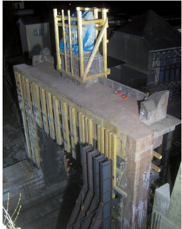
Abb. 9 Aufbau der Holzunterkonstruktion an der Portalrückseite sowie eingefärbten Leichtbetonrahmen
