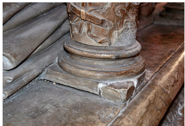
Abb. 9 Säulenbasis mit Versatz und Verformungen
