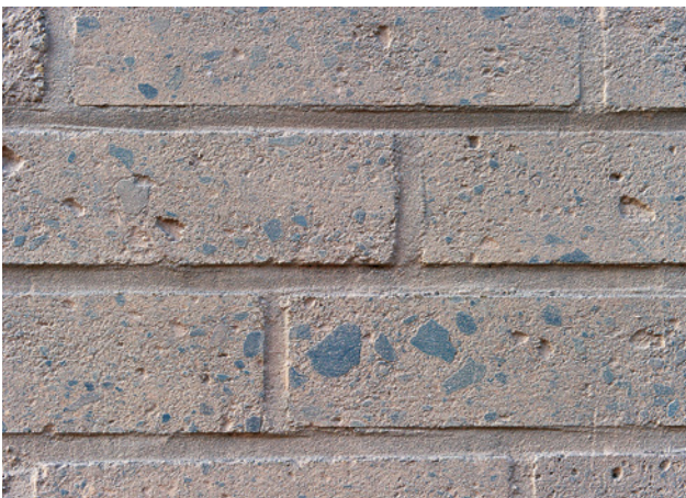
Abb. 5 Dokumentiert wird das Ergebnis der Kombination aus \text{TiO}_2 -freier Materialqualität der Siliconharzfarbe und geringer Trockenschichtdicke des verschlammenden Anstrichsystems.
