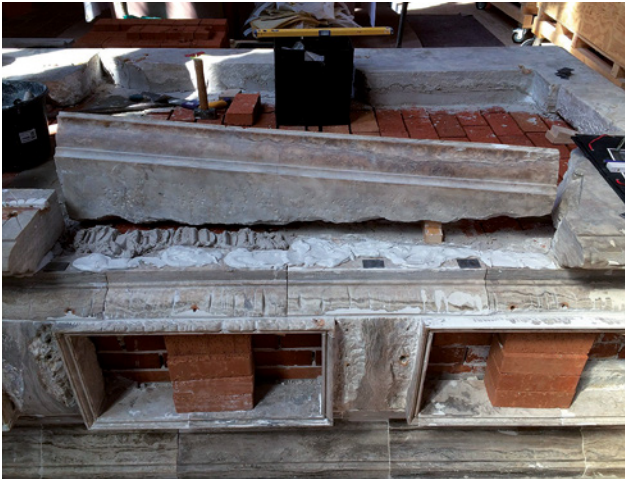
Abb. 35 Wiederaufbau der Bettlade, Einsatz des neuen Gipsmörtels beim Versetzen von Alabasterplatten
