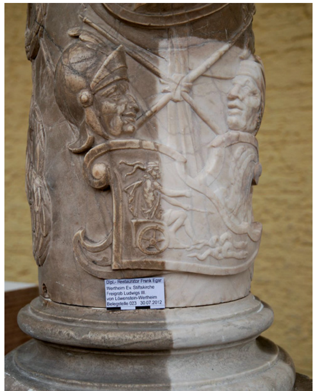
Abb. 31 Teilgereinigte Säule aus Alabaster
