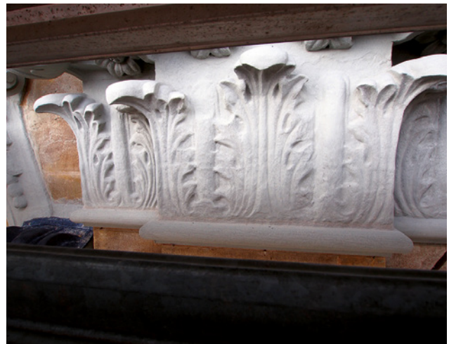
Abb. 16 Konservierung des nördlichen Kapitells (Material: Naturstein, Restauriermörtel, Beton) auf der Ostseite am Nordturm – mit Remmers Schlämlasur überzogen. Endzustand
