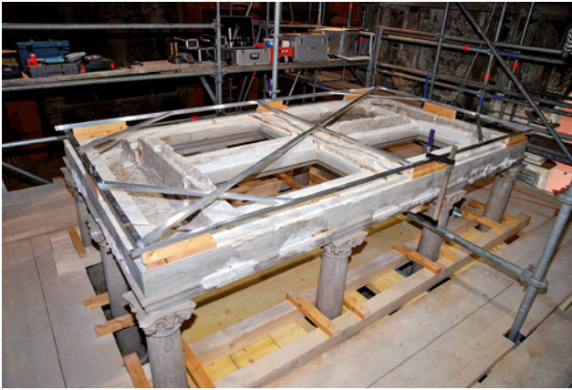
Abb. 28 Verzerrungsfreies Messgerüst für die Erstellung verformungsgerechter Aufmaße jeder Steinschicht
