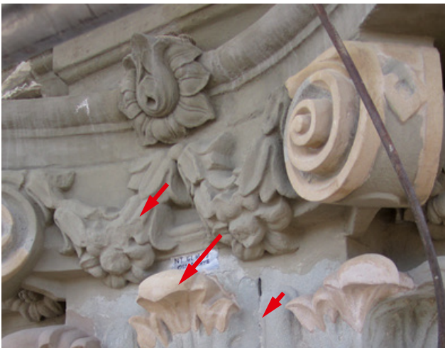
Abb. 15 Konservierung des nördlichen Kapitells auf der Ostseite am Nordturm – Molassesandstein (kurzer Pfeil), Beton (mittlerer Pfeil), Restauriermörtel Sika MonoTop 603 (langer Pfeil), um die Kleinteiligkeit und den schnellen Materialwechsel zu zeigen. Zwischenzustand
