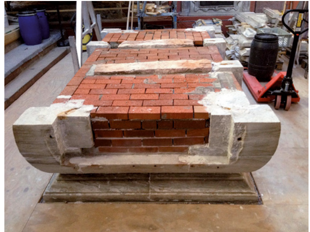
Abb. 36 Neuer Mauerwerkskern mit angesetzten Alabasterstücken
