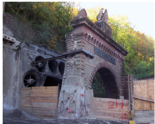
Abb. 4 Portal Kaiser-Wilhelm-Tunnel auf der Cochemer Seite mit abgetragenem Widerlager und „Eisenklammer“
