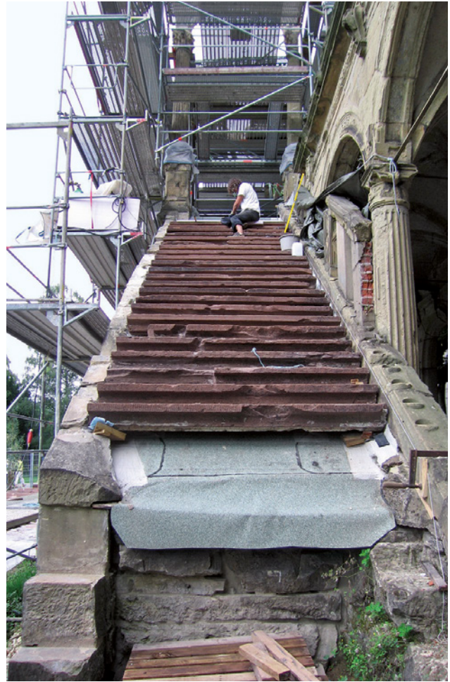
Abb. 16 Treppe nach dem Wiedereinbau der historischen Teile 2010
