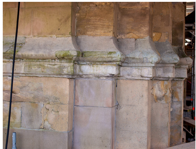
Abb. 2 Vorzustand – der angetroffene Materialmix, auf diesem Bild mindestens drei Naturstein- und drei Kunststeinvarianten, zudem verschiedene Fugenmörtel. Materialien und Schäden überlagern sich vielfältig. Nordturm Nordwestecke, Gesims D (Höhe ca. 27 m)
