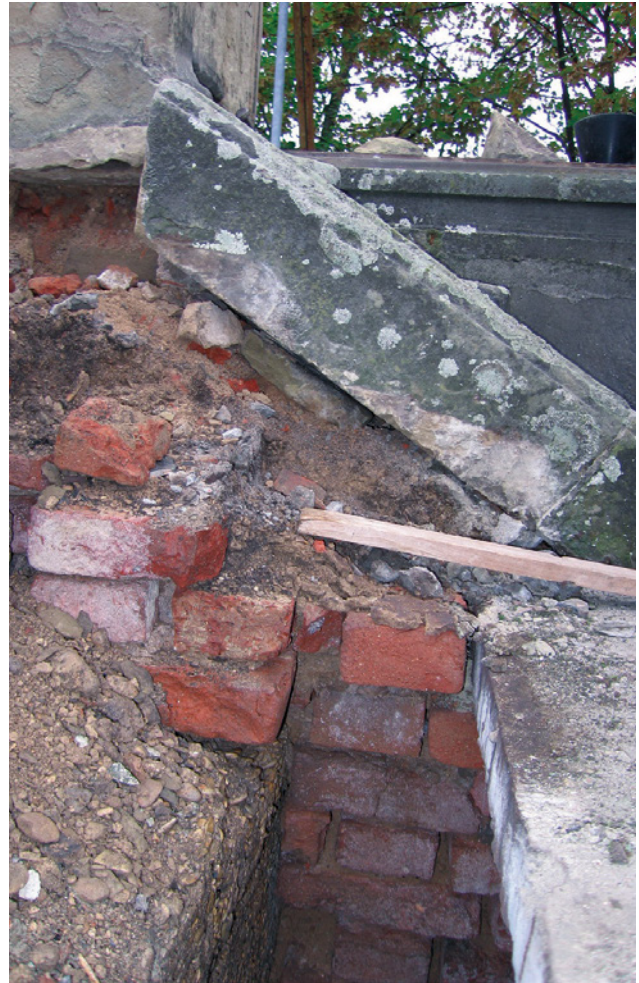
Abb. 12 Situation nach Abbau der Treppe, stark geschädigte gemauerte Wände 2009
