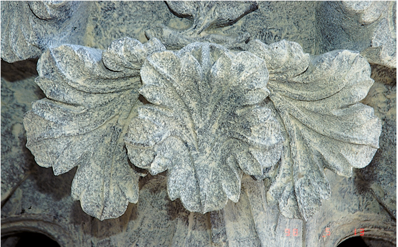
Abb. 3 \text{TiO}_2 -freie Variante eines verschlammenden Anstrichs auf Siliconharzbasis, angewandt 1998 am Kölner Dom (Foto von den Arbeiten im Jahr 1998)
