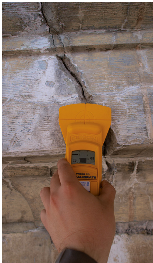
Abb. 10 Der in Rissbereichen (Schwindrisse, Krakelee) stark ausblutende Beton und die klaffenden Risse in den Betonantragungen sind sehr gut zu erkennen. Vorläufige Messung/Suche von weiteren Metallbewehrungen in Antragsmassen mit Metalldetektor
