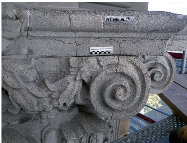
Abb. 7 Kapitell aus Beton stark geschädigt: geöffnete Schwindrisse, Oberflächenkorrosion, Karbonatisierung, z. T. abgelöst, Nordturm Südseite. Vorzustand
