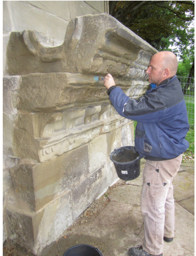
Abb. 20 Reinigungsarbeiten Bauabschnitt 2, 2013
