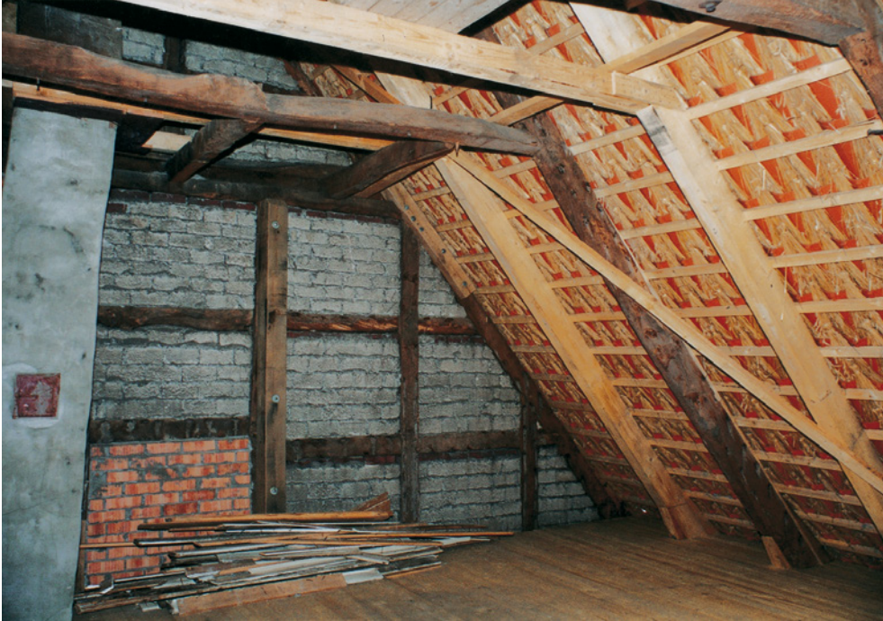
Abb. 105: Restaurierter Sparren- dachstuhl mit Tonpfannen- deckung (in Strohdocken gelegt)
