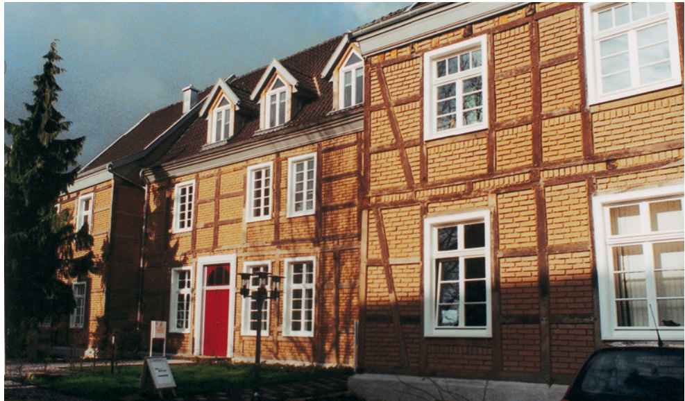
Abb. 70: Die unverputzten Leicht- lehmsteine verleihen dem Fachwerkhaus eine beson- dere Note. Nach einer Heizperiode sollten die Gefache jedoch mit einem Kalkputz versehen werden.
