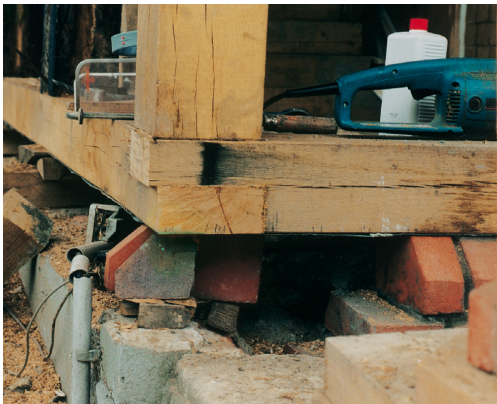
Abb. 53: Gerade Ecküberblattung eines erneuerten Schwellbalkens
