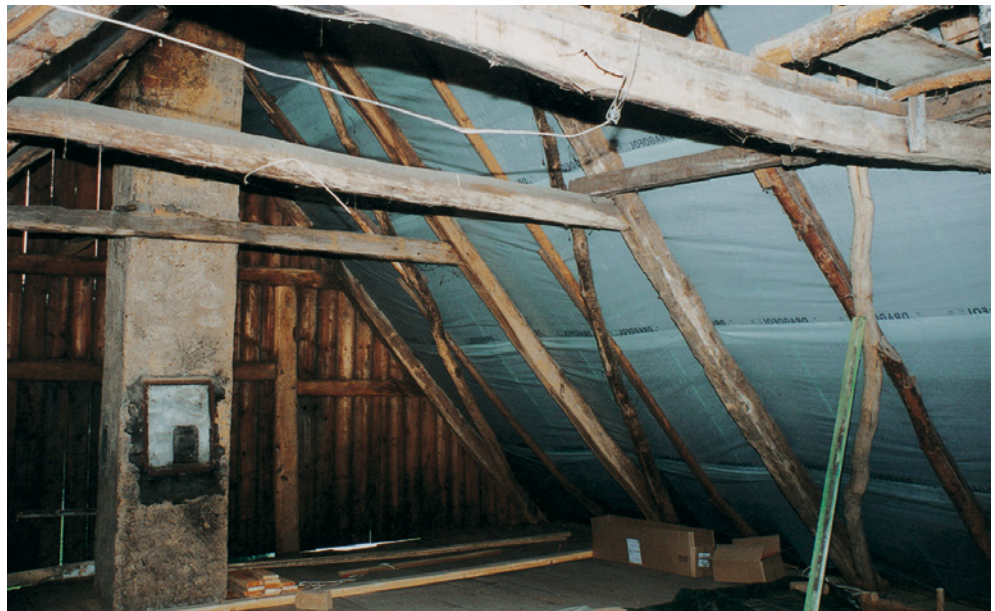
Abb. 104: Trotz relativ neuer Dachhaut muss bei diesem völlig maroden Dachstuhl eine weit reichende Sanierung bzw. Erneuerung erfolgen.
