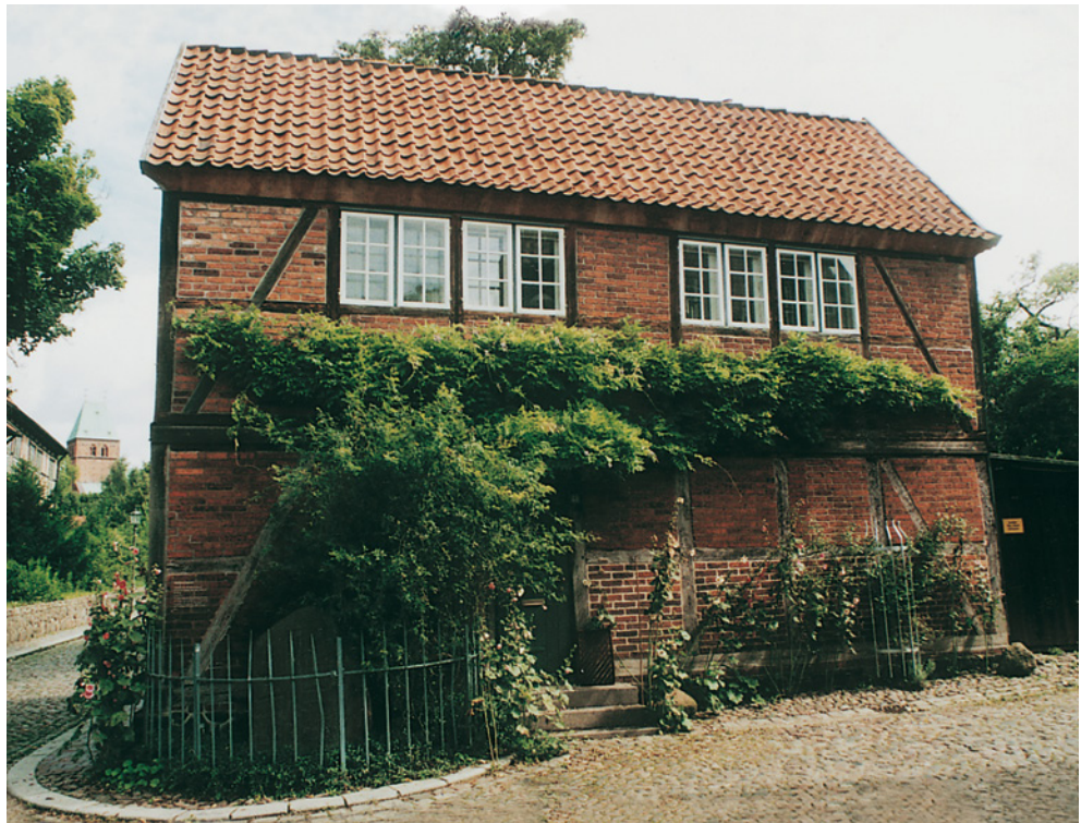
Abb. 150: Neue Stockrahmenfenster mit harmonischer Kreuzsprossenteilung
