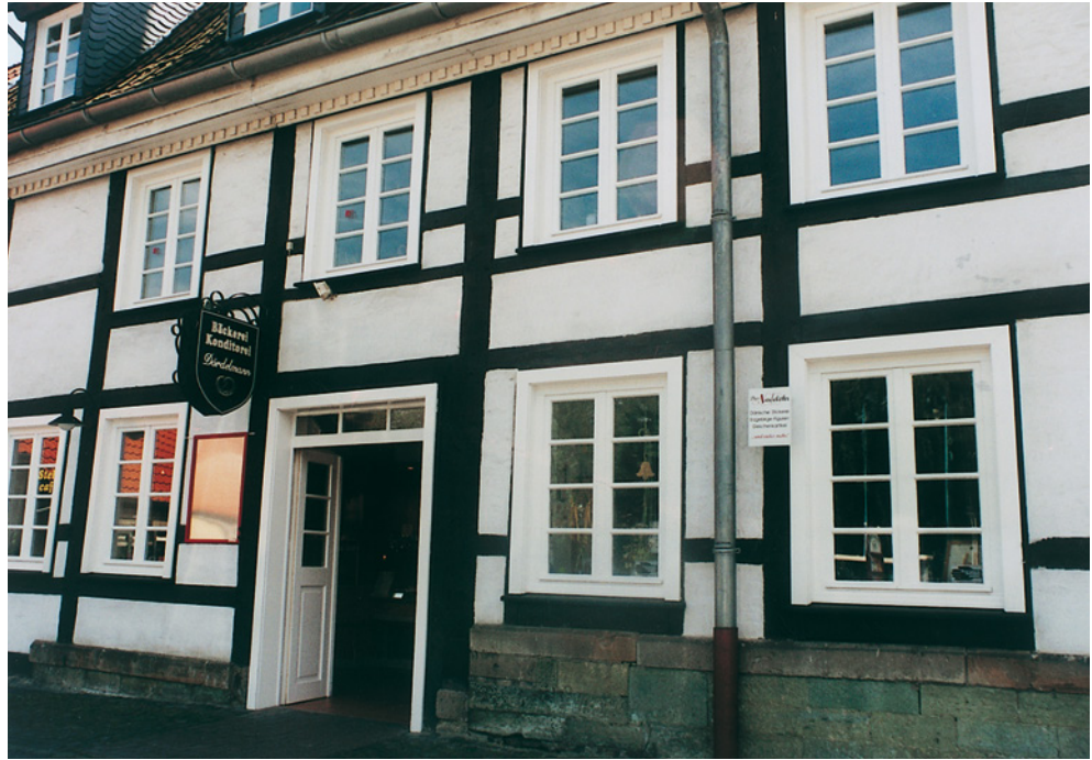
Abb. 138: Ein Beispiel für gut angepasste neue Holz- fenster mit Isolier- verglasung und zierlichen aufgelegten Sprossen
