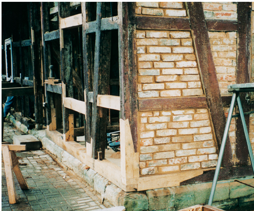
Abb. 55: Dieses Sanierungsbeispiel zeigt gleich drei unterschiedliche Holzverbindungen in fachmännischer Ausführung: Die Verlängerung des Eckständers wurde mit einem oben abgeschrägten Versatz mit geneigter Brüstung angesetzt. Der Schwellbalken zeigt ein schräges Blatt und eine gerade Ecküberblattung.
