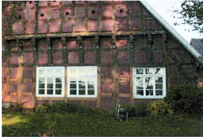
Abb. 167a+b: Fachwerk-Balken von Farbresten und Ver- schmutzung gereinigt durch das Trockeneis- Abstrahlverfahren
