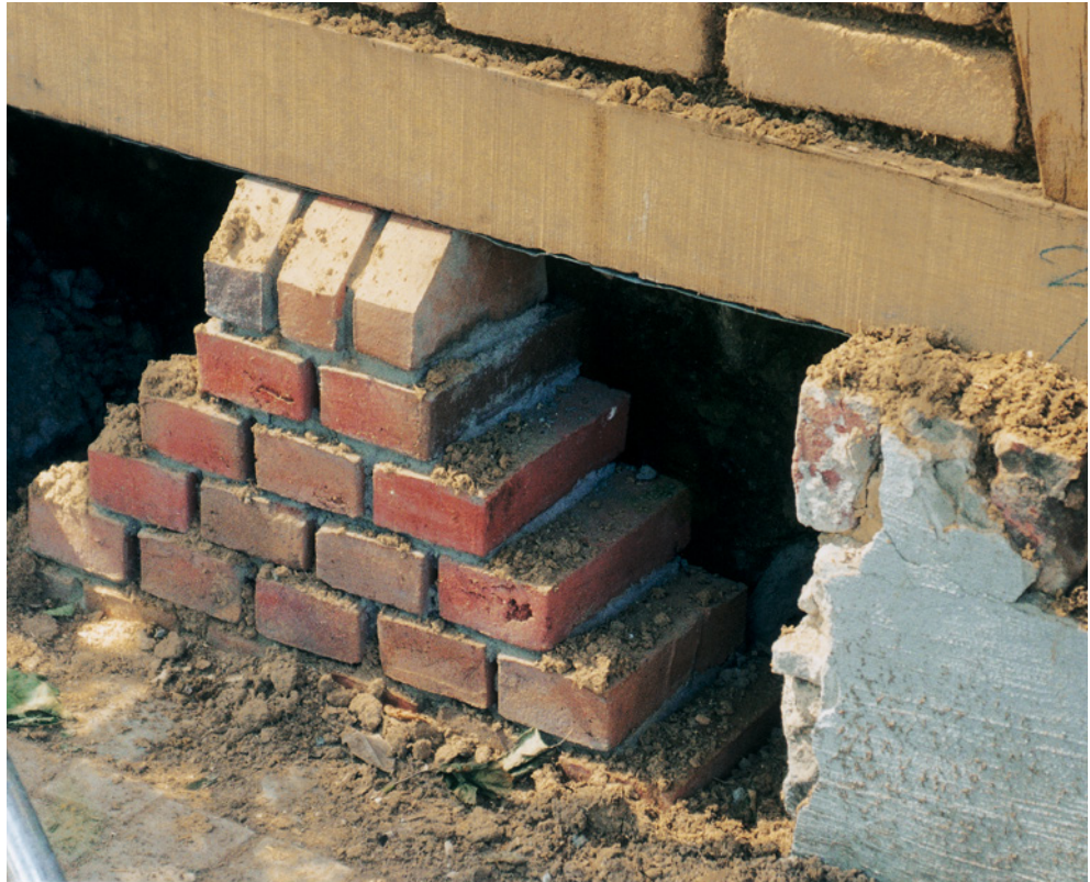
Abb. 25: Fachmännische Erneuerung eines Ziegelsockels. Rechts der alte Sockel mit mittig aufliegender Schwelle als Ursache für die Zerstörung (vgl. S. 65)
