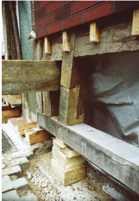
Abb. 62 e (links): Nun werden die Zapfenlöcher in die Schwelle gefräst.
