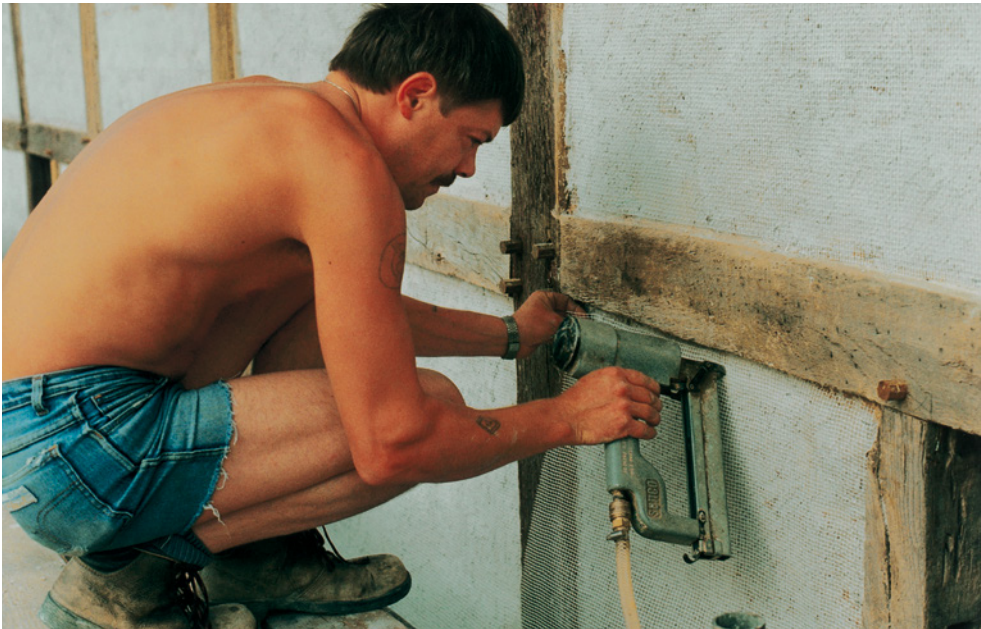
Abb.94: Ein passend zugeschnittenes Putzträgergewebe wird auf die vorgespritzte Lehmausfachung aufgetak- kert. Nun muss noch ein einlagiger Kalkputz balkenbündig aufgebracht und eben abgerieben werden.
