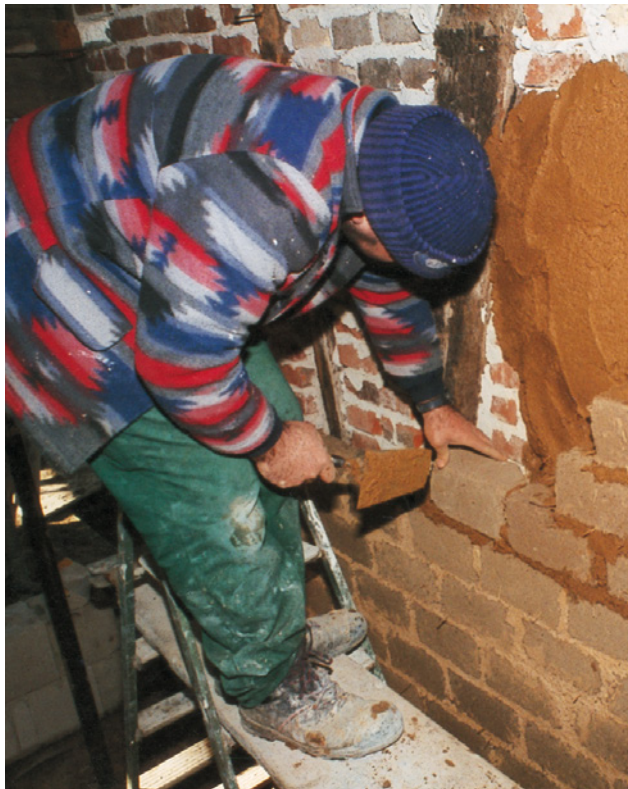
Abb.85: Maurer beim Anbringen der Innendämmung mit Strohleichtelemsteinen
