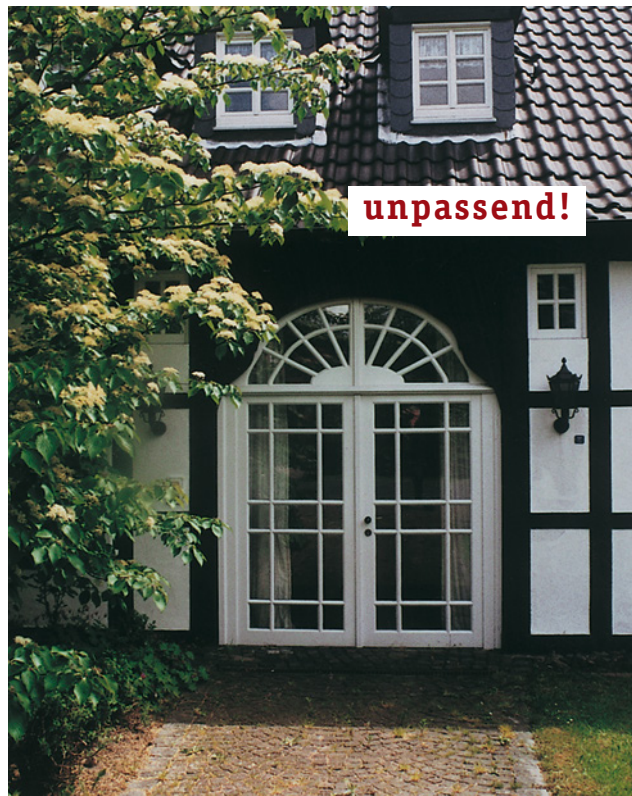
Abb. 158: So bitte nicht! Deelentor-Fensteranlage als Schmuckelement. Es widerspricht dem histo- rischen Zweck des Tores als ehemaliger Eingang in den Wirtschaftstrakt des Hauses.
