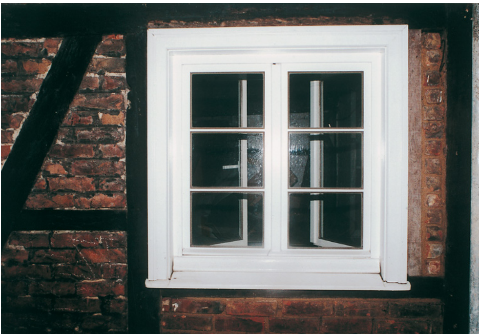
Abb. 144: Kastenfenster von außen, mit geöffneten Innen- flügeln. Die Fenster wurden lackiert eingebaut, nur die Glas-Kittfälze müssen noch gestrichen werden.
