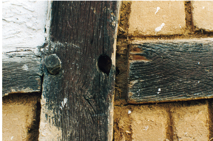
Abb. 48a–e: Sanierung einer zweifach geschädigten Riegel- verbindung
