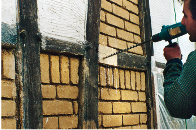
Abb. 48 d: Das eingesetzte Passstück wird für die Holznägel vorgebohrt.
