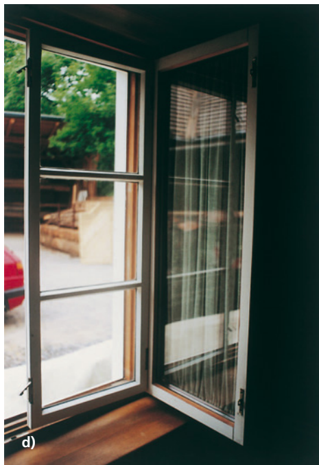
Abb. 137 a–d: Diese Verbundfenster sind außen mit Einfach- und innen mit Isolierverglasung ausgestattet. Bei b), c) und d) ist jeweils ein Verbund- flügel entriegelt.
