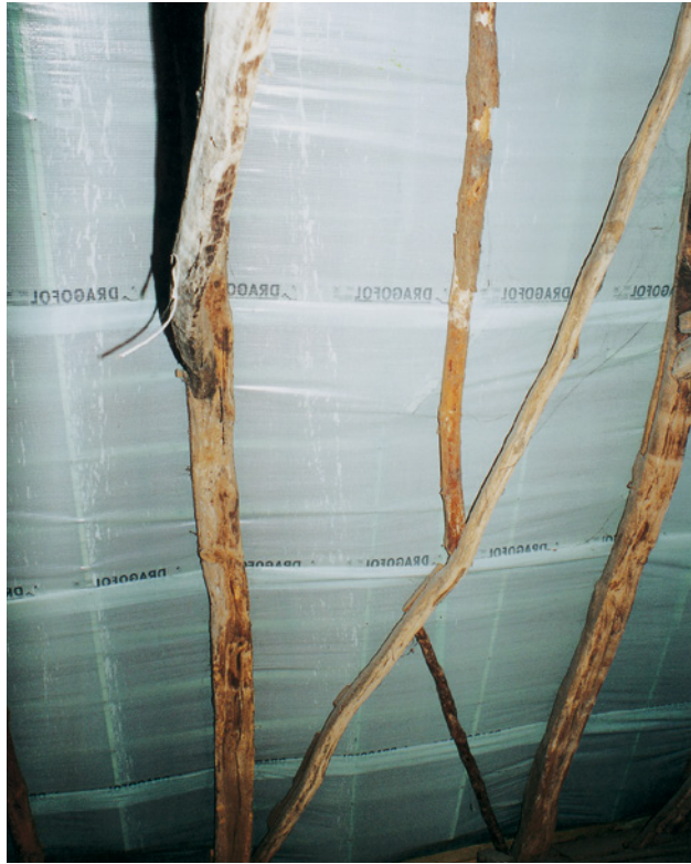
Abb. 110: Eine haarsträubende Lösung: Die Dachlattung wurde einfach auf primitiv eingesetzte Hilfsplatten genagelt.
