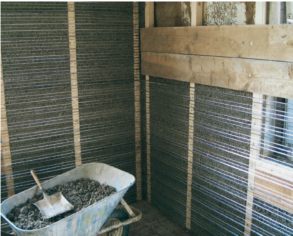
Abb.80f: Alternative: Die fertige Wanddämmung mit Rippen- streckmetall als Putzträger
