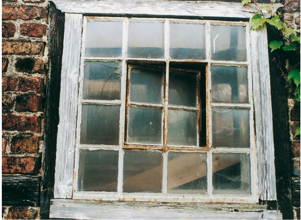
Abb. 130: Ein historisches Gusseisen- fenster in einem ehema- ligen Schmiedegebäude
