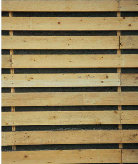
Abb.80d (links): Höherführen der Schalung
