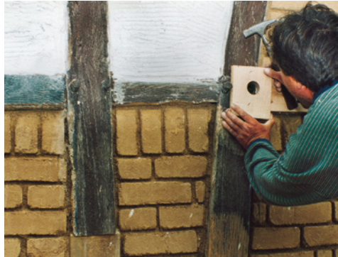
Abb. 59: Übergroße Holznagel- löcher
