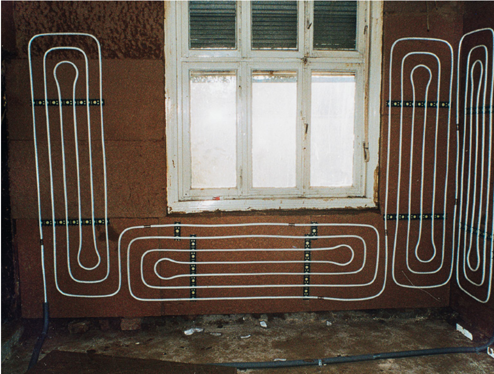
Abb.87: Verlegte Wandheizung auf einer Fensterwand vor dem Einputzen
