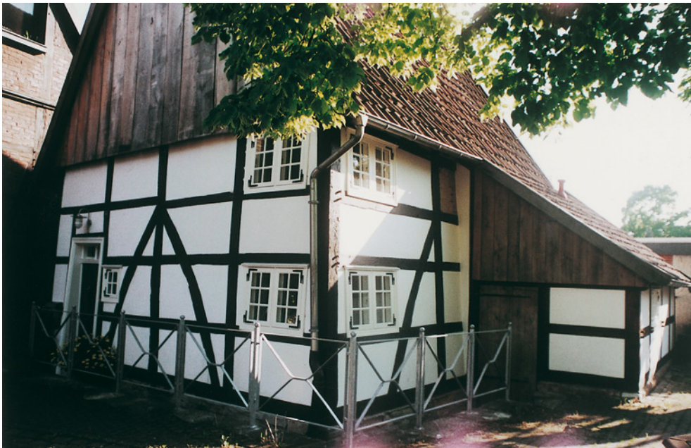
Abb. 146: Fachwerkhaus mit neuen Stockrahmenfenstern
