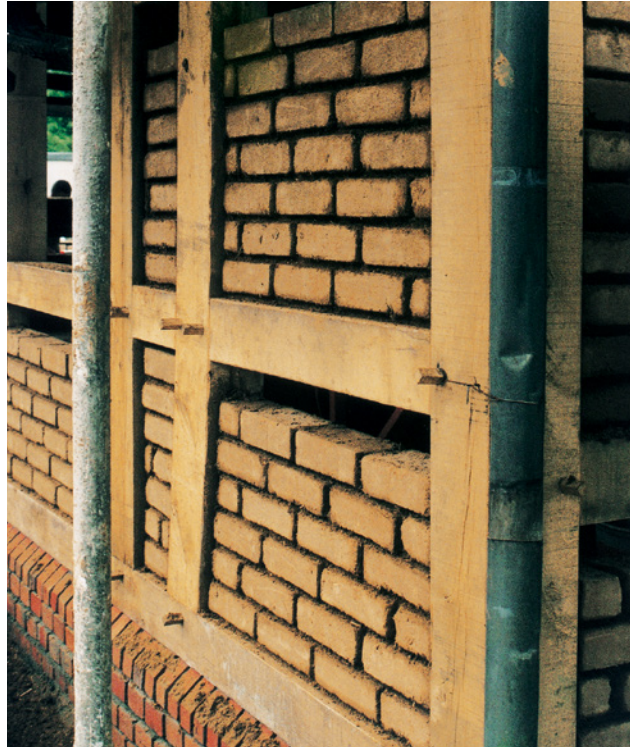
Abb. 71: Die Gefache wurden nach Abschluss der Zimmermannsarbeiten mit Leichtlehmsteinen ausgemauert.
