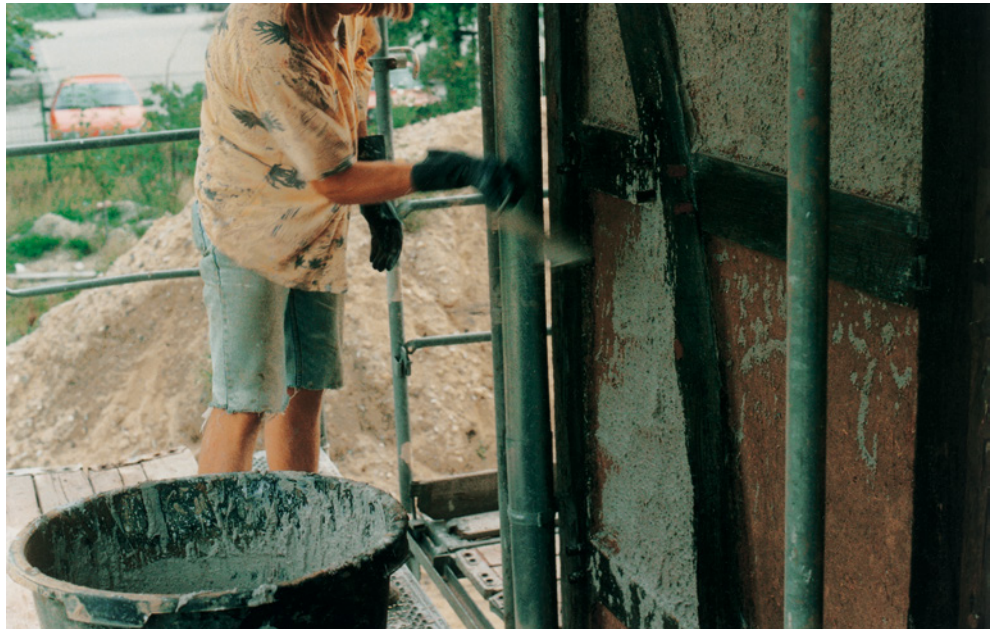
Abb. 92: Die Lehmausfachungen werden mit einem dünnen, grobkörnigen Kalkmörtel vorgespritzt.
