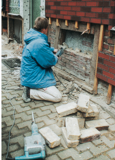
Abb. 62 a–h: Schwellenaustausch (gemäß Abb. 57 d)
