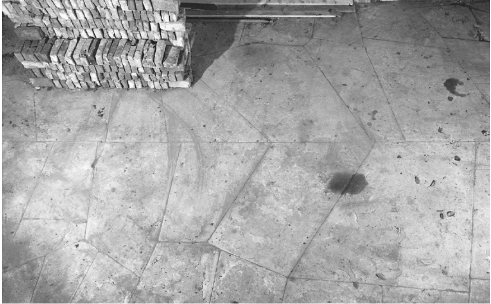
Abb. 19: Original-Fußbodenbelag der Deele eines Fachwerk- hauses. Der Wiedereinbau des Plattenbelags nach erfolgter Sanierung setzt ein genaues Dokumen- tieren der ursprünglichen Situation voraus.
