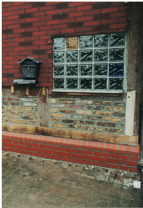
Abb. 62 g (links): Der Maurer beginnt mit dem Untermauern des Sockels.
