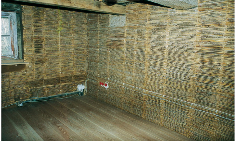
Abb. 79: Die fertig gedämmte Innenseite der Außenwand
