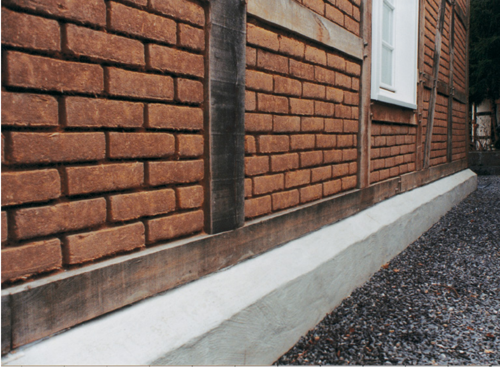
Abb.33: Beispiel für eine vorbildliche Instandsetzung: Fundamentsockel nach dem Verputzen mit überstehendem Schwellbalken
