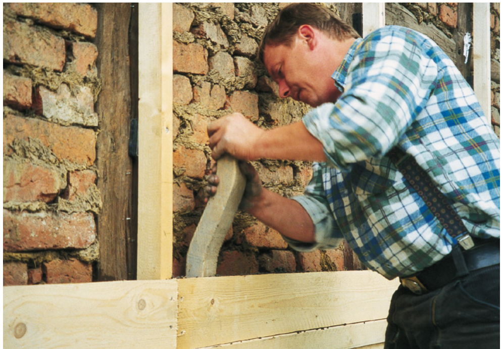
Abb. 80 c: Feststampfen des eingefüllten Dämmguts
