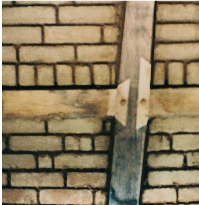
Abb. 58: Schwalbenschwanz- Einsatzstücke für beide Riegelanschlüsse
