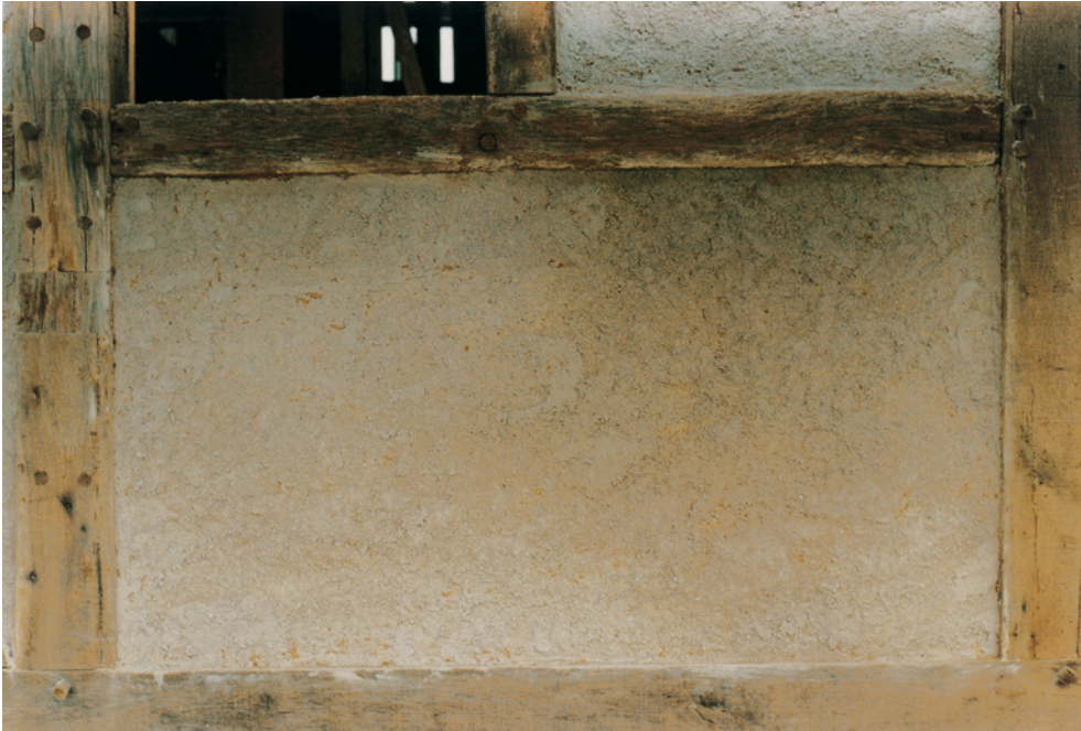
Abb.93: Die vorgespritzte Fläche nach dem Abwaschen der Balken
