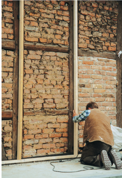
Abb. 80 a–e: Einbau einer Innendämmung
