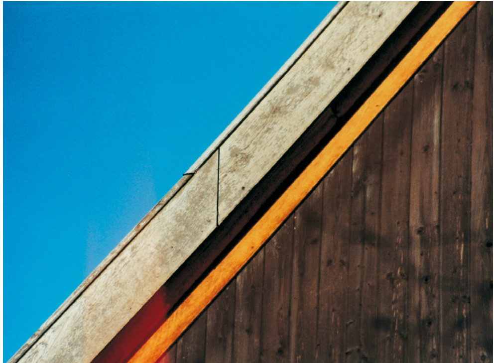
Abb. 114: Schräger Deckbrettstoß und senkrechter Seiten- brettstoß: So ausgeführt kann Regen und Schnee- feuchtigkeit schadlos ablaufen.
