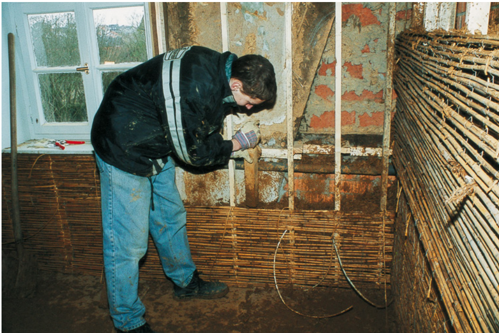
Abb. 78: Leichtlehm dämmung – das eingefüllte Dämmmaterial wird festgestampft.
