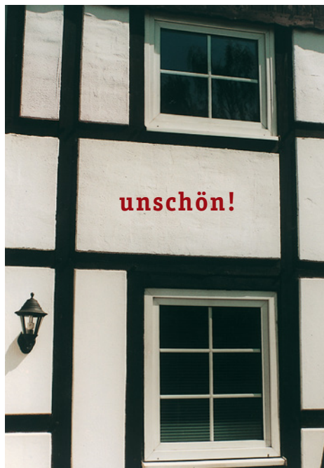
Abb. 159: So bitte nicht! Kunststofffenster mit Zwischensprossen, ohne Bezug auf die Original- teilung, wirken unschön und störend.
