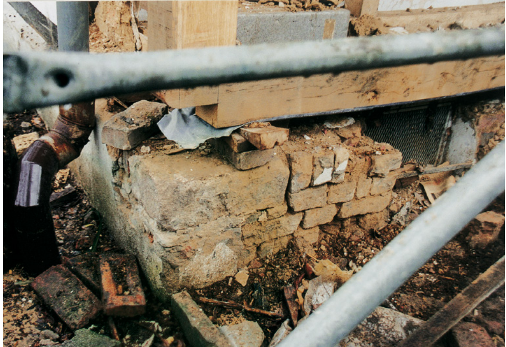
Abb. 30: Dieser marode Fundament- sockel wurde entfernt ...
