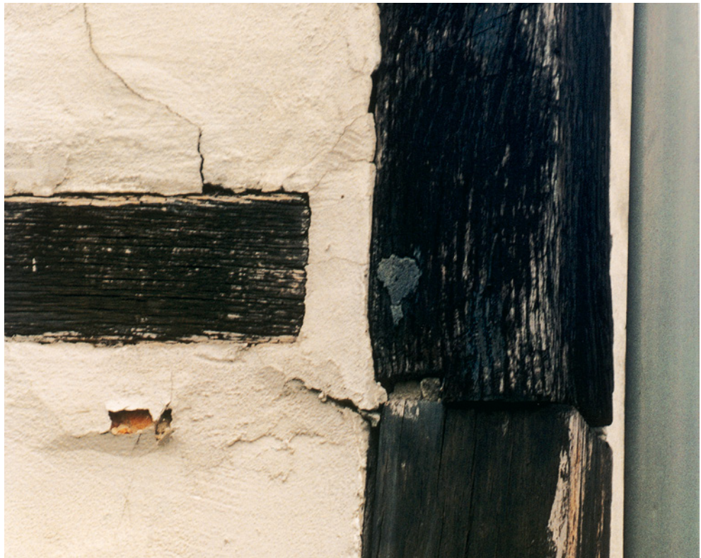
Abb. 44: Dieser Knotenpunkt weist keine kraftschlüssige Verbindung mehr auf. Der Riegel hat seine Funktionalität verloren und das Verschließen der Schadstelle und des Dübellochs mit Putz und Mörtel wird den weiteren Zerstörungsprozess nur noch beschleunigen.
