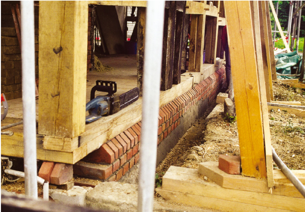
Abb.31: ... und durch ein tragfähiges Betonfundament mit einem Sockel aus Ziegelmauerwerk ersetzt.
