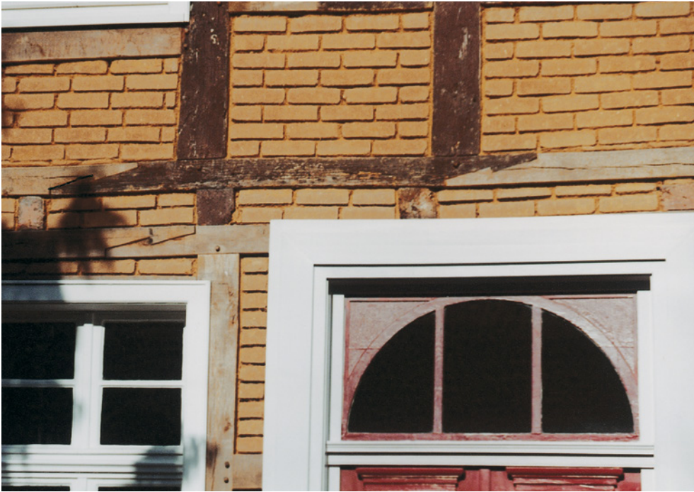
Abb. 49: Das Hakenfalzblatt, hier gleich dreimal auf engstem Raum, zur Sanie- rung der Rähmbalken
