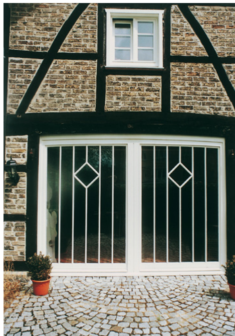
Abb. 156 (links): Verglastes Deelentor- Element aus Stahlrohr- profilen mit geschlossener Doppeltüranlage
