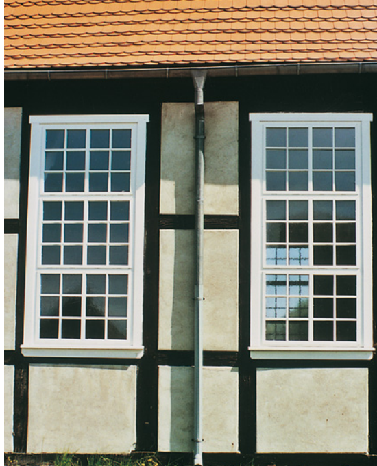
Abb. 142: Isolierglasfenster einer Fachwerkkirche mit jeweils sechs durchgehenden Scheiben und aufgelegten Sprossen
