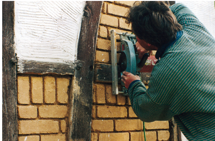
Abb. 48b: Der Riegel wird bis auf Zapfentiefe schräg einge- schnitten.
