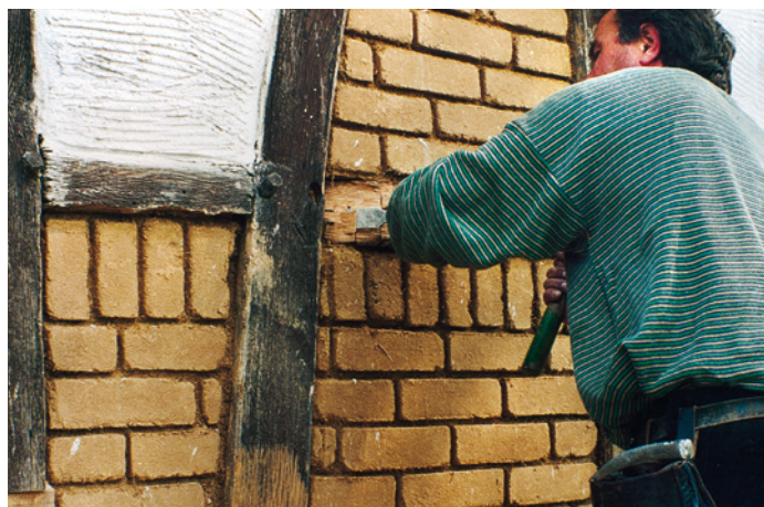
Abb. 48c: Anschließend wird der Riegel bis auf Zapfentiefe ausgestemmt.
