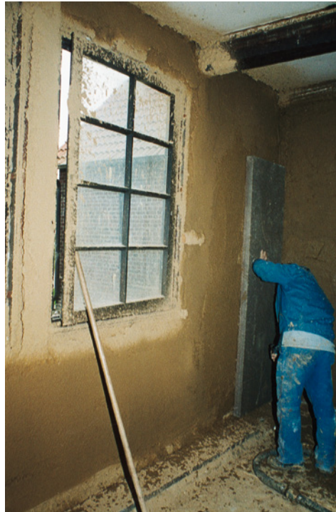
Abb. 83 c (links): Die Faserdämmplatte wird ganzflächig mit Lehm- ansetzmörtel aufgezogen.
