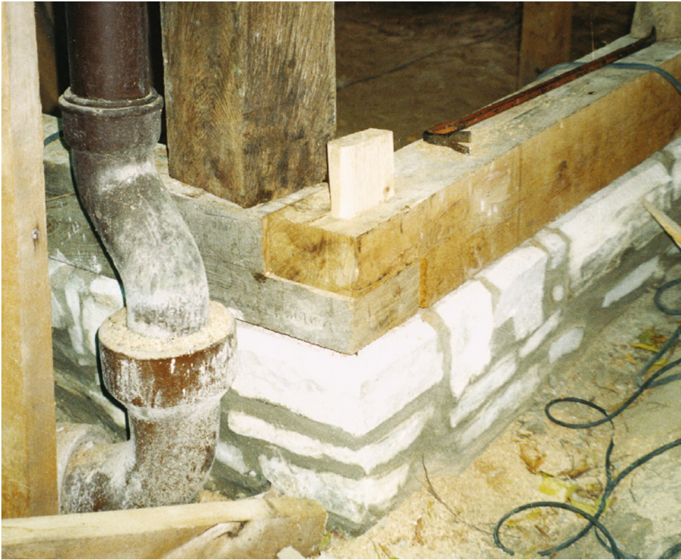
Abb. 26: Sockel aus Bruchstein nach der Erneuerung
