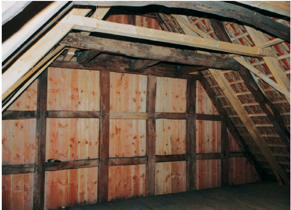
Abb. 112: Neu verschaltes Giebel- dreieck
