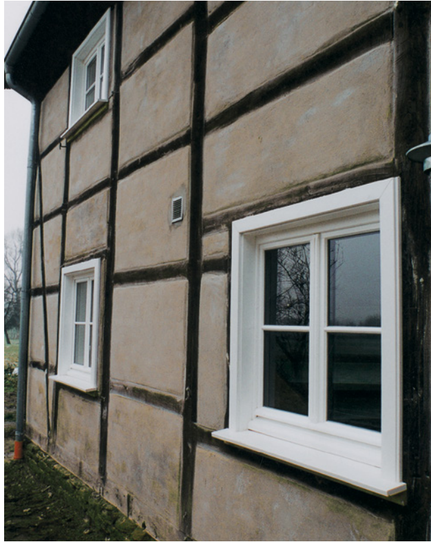
Abb. 96: Balkenbündig gemauerte Gefache mit einem zum Balken hin stark abge- schrägten Kalkputz
