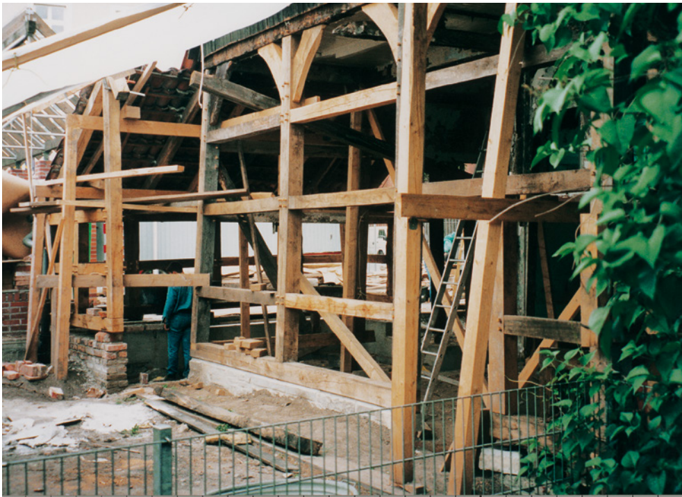
Abb. 38: Fachwerkkonstruktion des 16. Jhs. während der Sanierung. Ein Großteil der historischen Balken wird unter Anwendung traditioneller Verfahren ersetzt.
