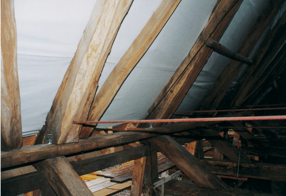
Abb. 107: Die Sparren dieses Dachstuhls wurden durch Zuganker gesichert.
