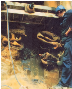
Bild 24 ■ Mögliche Schäden beim Einbringen von Spundbohlen (aus [25])
