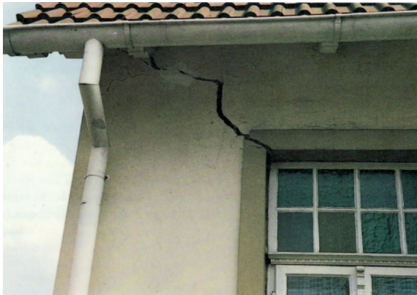
Bild 88 ■ Risse am Nachbarhaus (aus [25])
