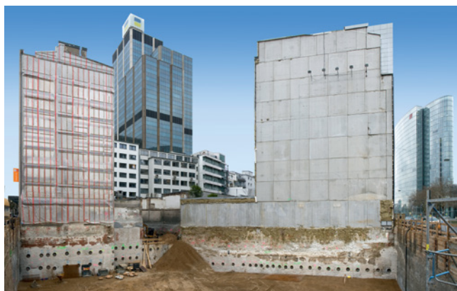
Bild 37 ■ Unterfangungswand als Baugrubensicherung, hergestellt mittels Hochdruckinjektion (Foto: Jahr, Köln)
