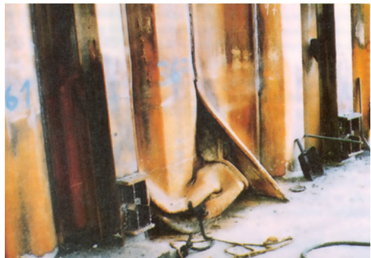
Bild 24 ■ Mögliche Schäden beim Einbringen von Spundbohlen (aus [25])
