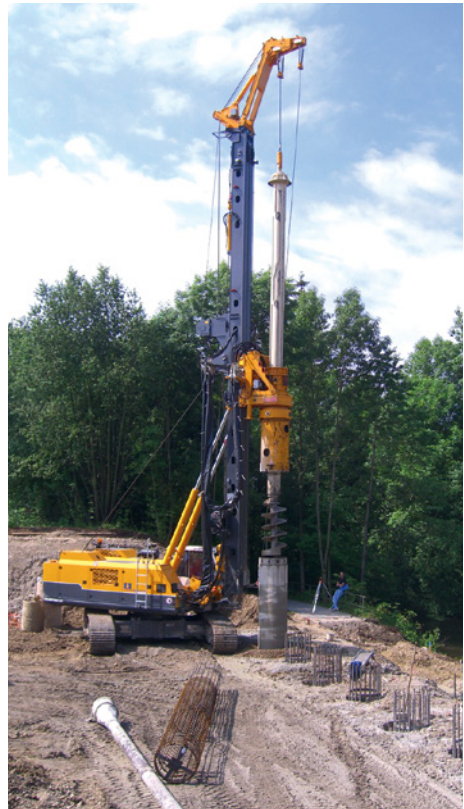
Bild 28 ■ Bohrgerät mit Kellystange und Bohrschnecke
