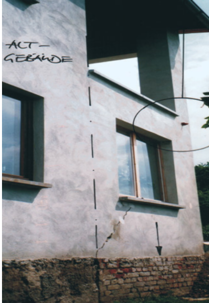
Bild 39 ■ Beispiel für einen Schaden infolge fehlender Scheibenwirkung [15]
