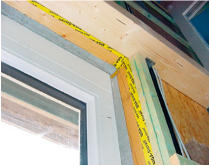
Abb. 43: Fenstereinbau beim Holzbau
