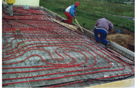
Abb. 79: Betonkernaktivierung
