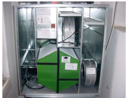
Abb. 49: Zu-/Abluftanlage mit Wärmerückgewinnung
