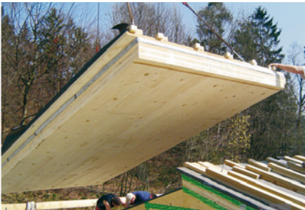
Abb. 112: Anlieferung eines vakuumgedämmten Dachelementes
