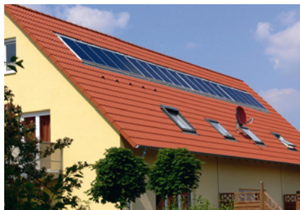
Abb. 83: Integrierte Solarkollektoranlage
