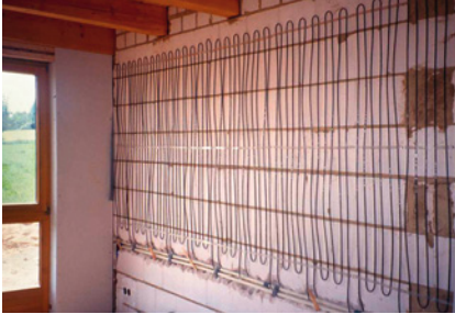
Abb. 78: Rohrsystem einer Wandflächenheizung
