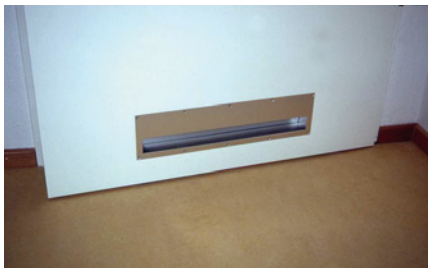
Abb. 61: Überströmmöglichkeiten: a. links Überströmelement in einer Tür b. rechts Überströmquerschnitt 15 mm hoch zwischen Tür und Boden
