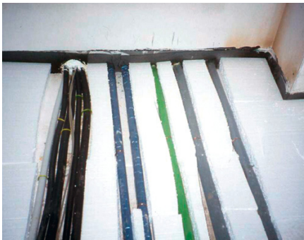
Abb. 77: Verteilleitungen innerhalb der gedämmten Hülle
