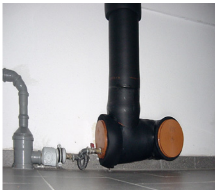
Abb. 54: Kondensatablauf am Ende eines Erdreichwärmetauschers im Keller
