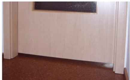
Abb. 61: Überströmmöglichkeiten: a. links Überströmelement in einer Tür b. rechts Überströmquerschnitt 15 mm hoch zwischen Tür und Boden
