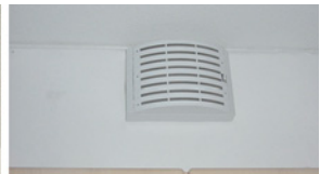
Abb. 60: Abluftdurchlass mit Filtermöglichkeit
