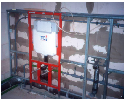
Abb. 44: Luftdichte Verspachtelung des Mauerwerks hinter der Vorwandinstallation
