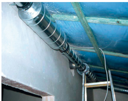
Abb. 58: Leitungsrohre einer Lüftungsanlage mit Schalldämpfer
