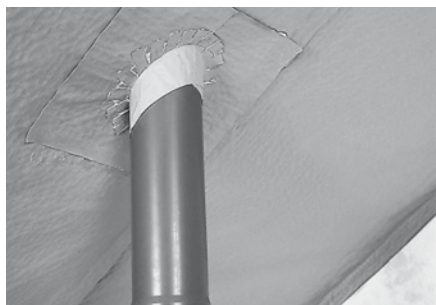
Abb. 42: Manschettenanschluss bei der Durchdringung einer Entlüftungsleitung
