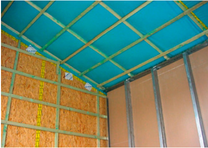
Abb. 40: Platten als luftdichtende Schicht einer Außenwand – Anschluss an eine foliengedichtete Dachfläche und eine Leichtbau-Innenwand
