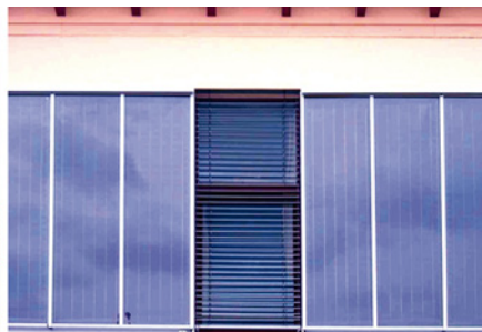
Abb. 84: Flachkollektor als Fassadenkollektor: hohe winterliche Solarausbeute
