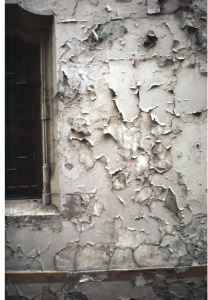
Bild 40: Schäden durch Ablösung eines Dispersionsanstrichs auf einem denkmalgeschützten Gebäude in Wittenberg. Solche Erfahrungen haben die Denkmalpfleger veranlasst, nur mineralische Anstriche zu verwenden.
