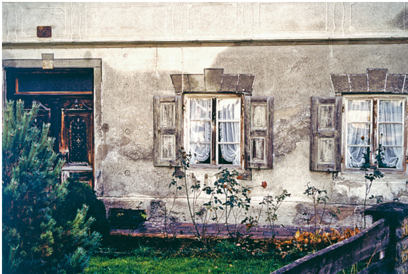
Bild 55: Bauernhaus in Mitterdarching mit feucht aussehendem Außenputz im unteren Fassadenbereich, Eingangsseite Ost
