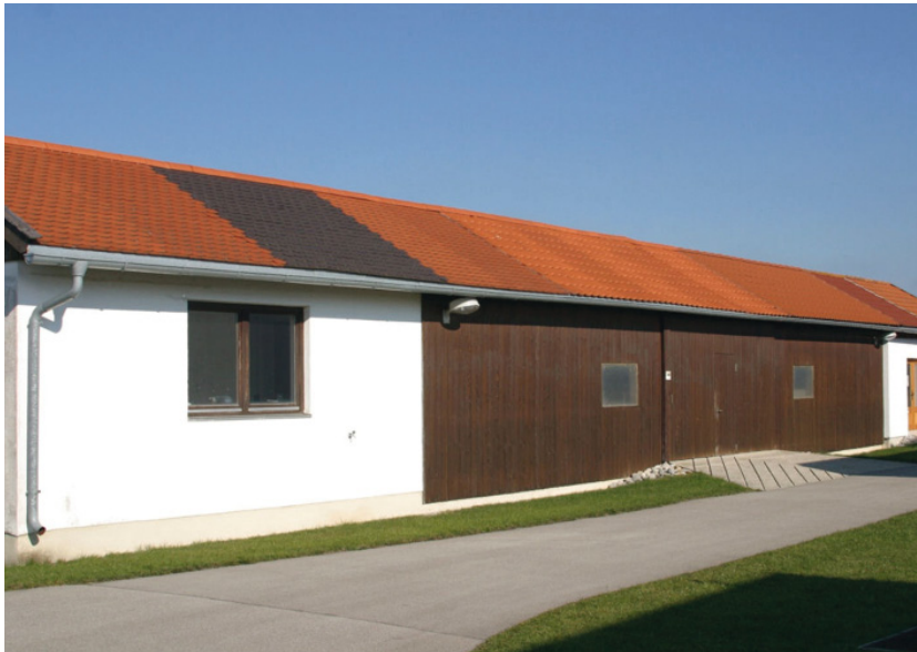
Bild 63: Ansicht des Versuchsgebäudes mit flachgeneigten Dachflächen (28°), nach Süden und Norden orientiert, hier gedeckt mit unterschiedlichen Dachziegeln bei unterschiedlichem Dachaufbau (rote Ziegel ohne und mit Silikonbehandlung, engobierte Ziegel, Flachdachpfannen und Biberschwanz-Deckung)
