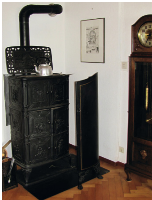
Bild 17: Ofenschirm zur Minderung der direkten Wärmeabstrahlung des Ofens, hier zwischen Ofen und Standuhr
