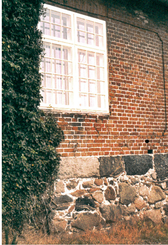
Bild 57: Haus in Norddeutschland aus Sichtziegelmauerwerk mit Natursteinfundament, das mit großformatigen Steinen abschließt (wirksame und bewährte Art der Horizontalisolierung)
