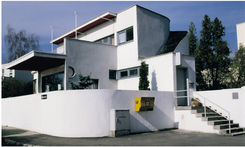
Bild 2: Haus der Weißenhof-Siedlung, Hölzelweg 1, Architekt Hans Scharoun. Beispiel eines Einfamilienhauses, Stahlbeton-Skelettbau mit Thermosplatten-Ausfachung, außen verputzte Bimsbetondielen, innen Gipsdielen. (Foto: Karin Kirsch)
