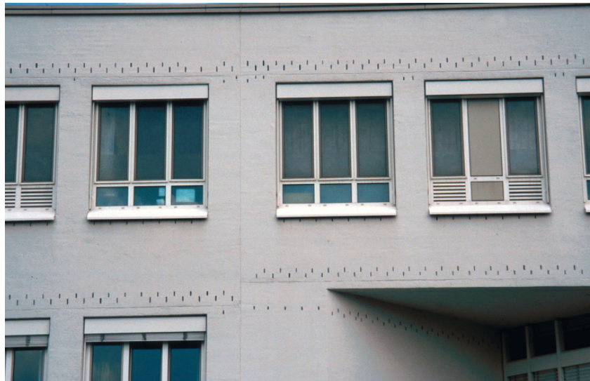
Bild 59: Fassadenansicht einer Klinik in München mit verputztem, zweischaligem Mauerwerk mit Luftschicht und Belüftung nach DIN 1053-1 (1996). Die Belüftungsöffnungen sind auch im Brüstungsbereich und im geschützten Eingangsbereich vorhanden. Eigentlich war dort gar keine Belüftung notwendig, außerdem bewirkt der Außenputz den Regenschutz.
