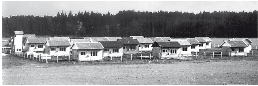
Bild 25: Ansicht der schachbrettartig angeordneten 26 Versuchshäuser nach der Fertigstellung 1952 von der Südseite aus. Die Außenmaße eines Hauses betrugen 4,5 m × 6,5 m; Näheres in [26].
