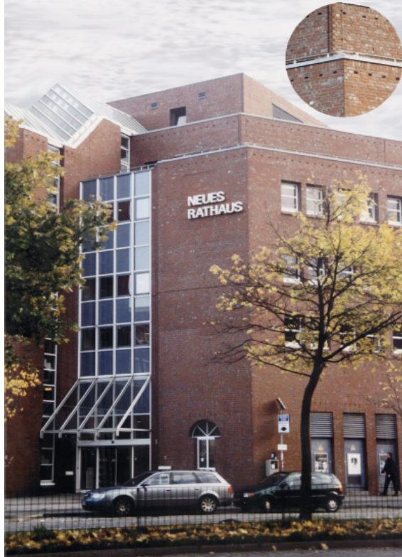
Bild 58: Neues Rathaus in Kiel mit Belüftungsöffnungen nach DIN 1053-1 (1996); Vergrößerung im Kreisbereich oben. Die stärkste Schlagregenbeanspruchung erfolgt im obersten Gebäudebereich. Durch die oberen Öffnungen kann mehr Regen eindringen als durch Belüftung abgeführt wird, wie durch Untersuchungen bestätigt wurde [68].
