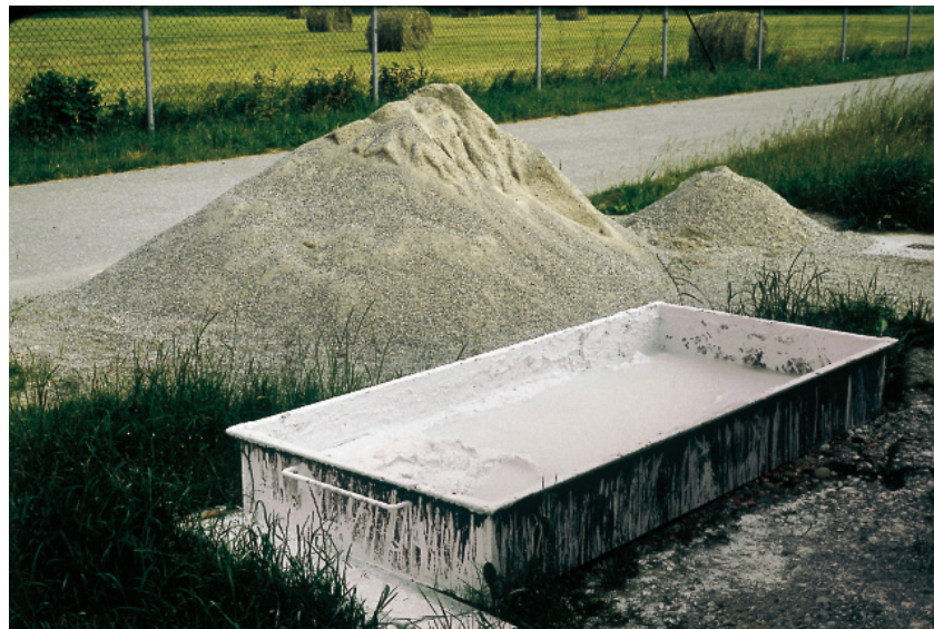
Bild 7: Mörtelbereitung auf der Baustelle in den 1950er-Jahren auf dem Versuchsgelände Holzkirchen. In der Mörtelpfanne wurde aus dem daneben aufgehäuften Sand mit Sumpfkalk und Zementzugabe der Mörtel gemischt.
