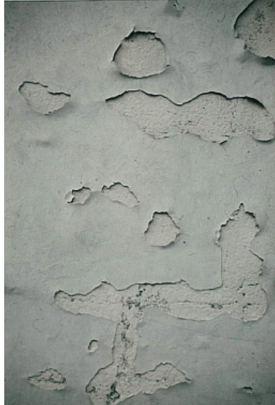
Bild 39: Schäden an einer stark quellfähigen Kunstharzbeschichtung auf verputztem Mauerwerk. Die Ablösung der Beschichtung geht meist von Putzrissen aus und weitet sich im Laufe der Bewitterung aus. Auch Aufwölbungen an Stellen ohne Haftung auf dem Putz sind erkennbar.
