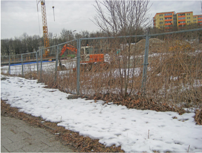
Fest installierter Bauzaun mit Tor
