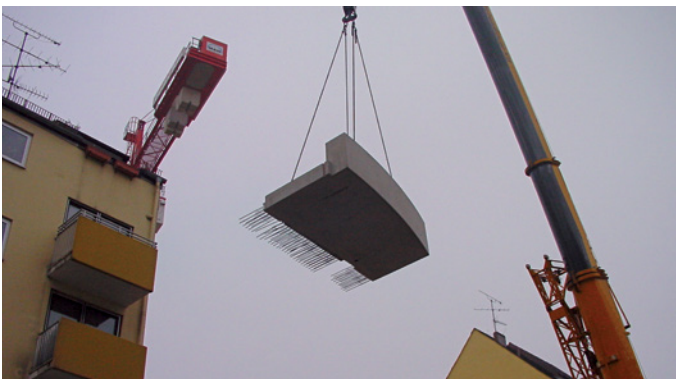
Versetzen Balkon Fertigteil
