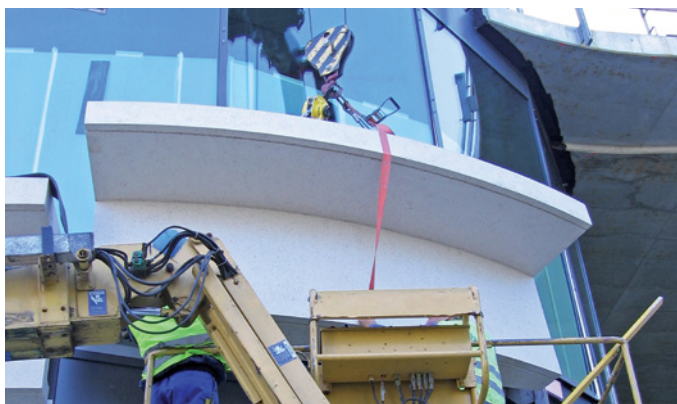
Versetzen gebogenes Fertigteil
