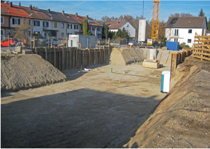
Freie Böschung und Spundwand
