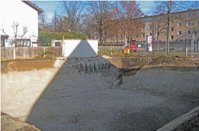
Freie Böschung und Pfähle
