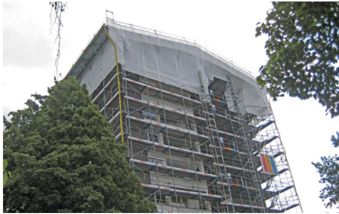
Gerüst mit provisorischer Falleitung
