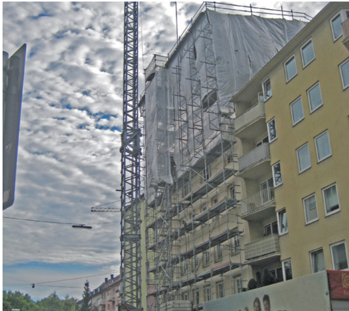
Einhausung Dachaufbau
