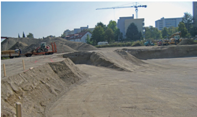
Aushub mit 60^\circ und Rampe
