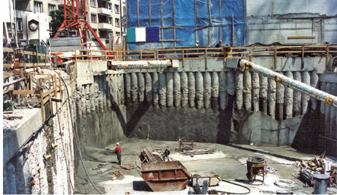
Bohrpfahlwand
