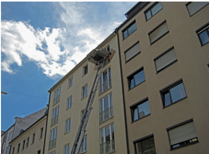
Materialaufzug mit Schutz der Fassade
