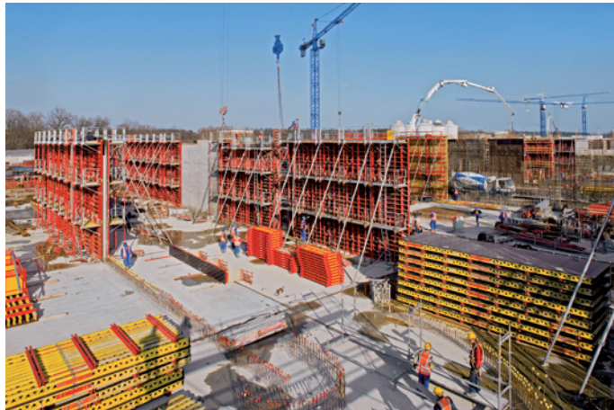
Schalung mit Arbeitsgerüst
