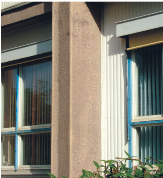
Bild 3.22 Stützen in Sichtbeton, vakuumiert (Detail aus Bild 3.21)
