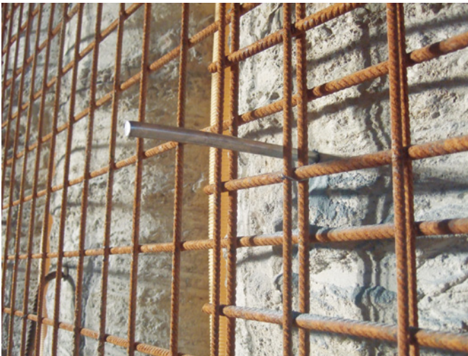
Bild 2.10 Bolzen aus verzinktem Stahl für die Sicherung der Betondeckung und der Außenkante
