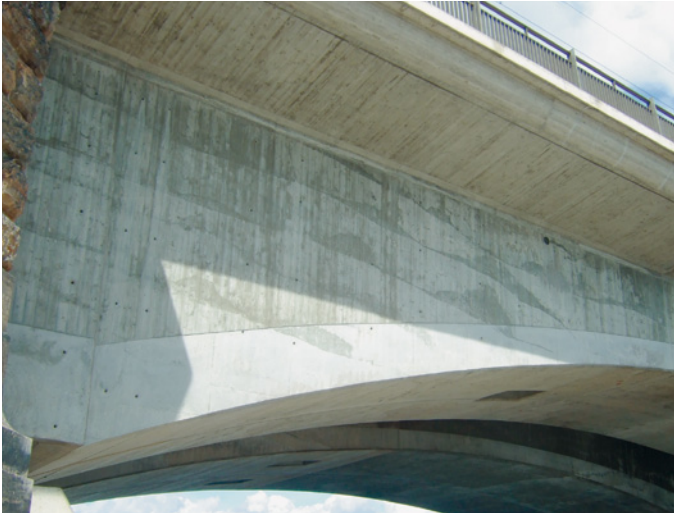
Bild 3.39 Das Abzeichnen der Schüttilagen bei Brückenhohlkästen und veränderlichen Querschnitten ist kaum zu vermeiden. Sie dokumentieren einen ordnungsgemäßen Einbau
