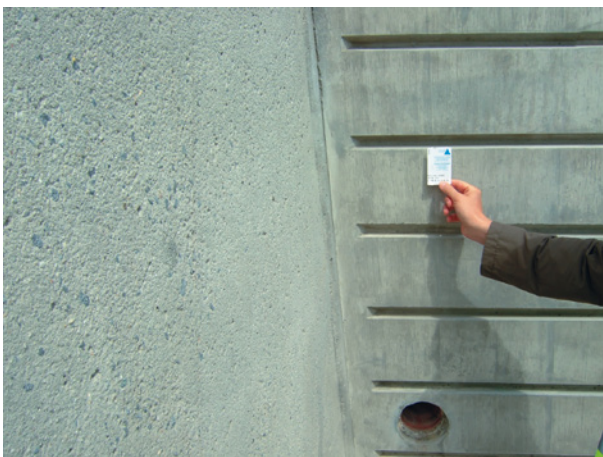
Bild 3.28 Verschiedene Arten von Sichtbeton an einem Brückenwiderlager
