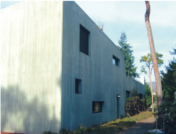
Bild 3.24 Sichtbetonfassade aus selbstverdichtendem Beton (SVB)
