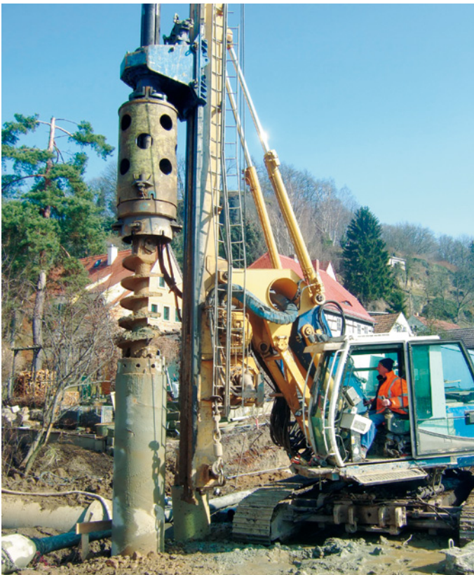
Bild 2.31 Bohrpfahlgerät bei der Herstellung des Hohlraumes für die Pfahlbetonage
