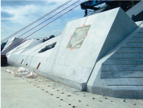
Bild 3.26 Brückenwiderlager in SVB
