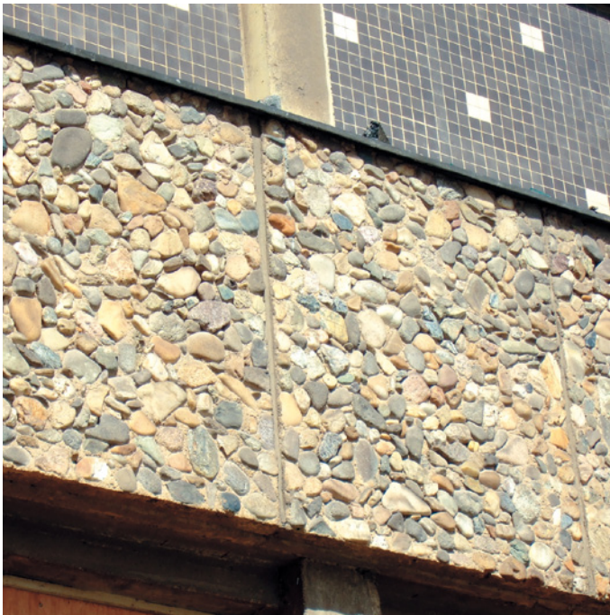
Bild 3.35 Fassadenplatte in Waschbeton von 1962
