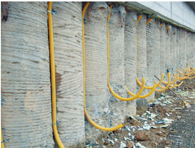
Bild 2.33 Wasserabführung an einer überschnittenen Bohrfahlwand
