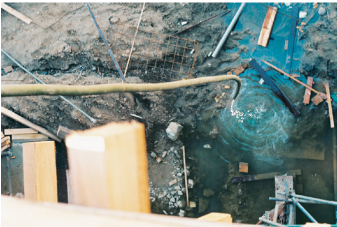
Bild 2.24 Aus dem Beton abgesaugtes Wasser
