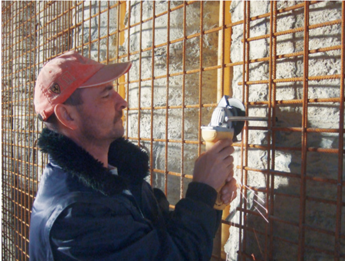
Bild 2.11 Ausrichten auf die Außenseite der Wand
