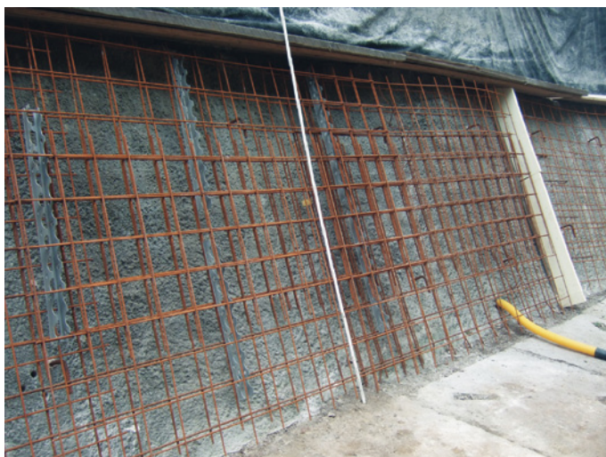
Bild 2.7 Herstellung einer Probewand
