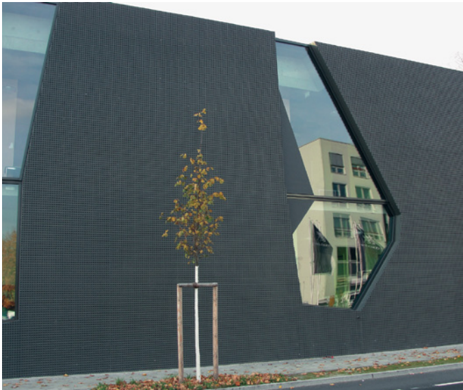
Bild 3.33 Strukturbeton unter Verwendung von Noppen-Matrizen (RECKLI 1997)
