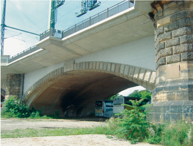
Bild 3.40 Beschichteter Brückenbogen nach der Instandsetzung der Tragfähigkeit
