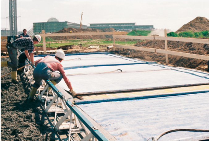
Bild 2.22 Auslegen der Filtermatten und des Vakuumteppichs nach dem Abziehen mit der Rüttelbohle
