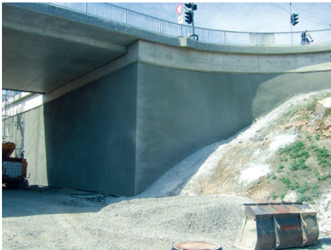
Bild 2.12 Spritzbeton mit erhöhten Anforderungen an die Dauerhaftigkeit
