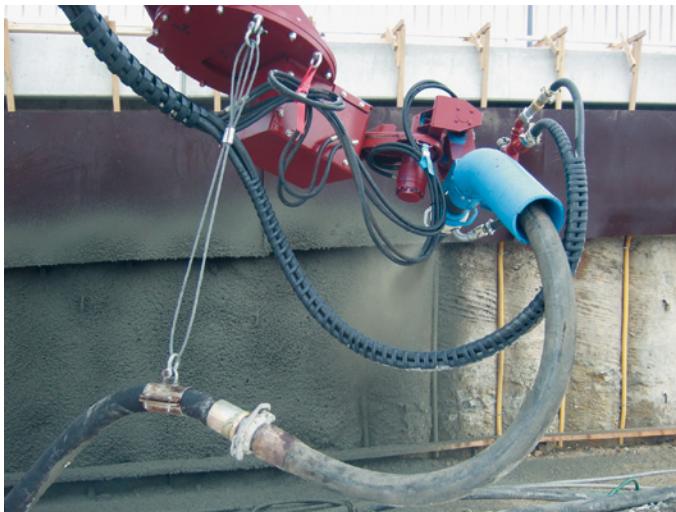
Bild 2.16 Spritzkopf mit den Zuführungen Bereitstellungsgemisch, Beschleuniger und Druckluft
