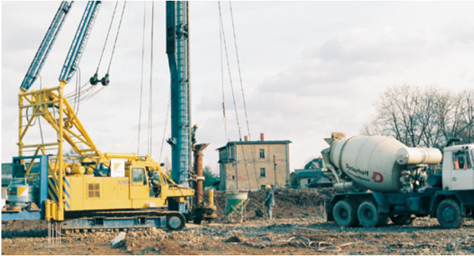
Bild 2.30 Gerät zur Herstellung von Rammpfählen
