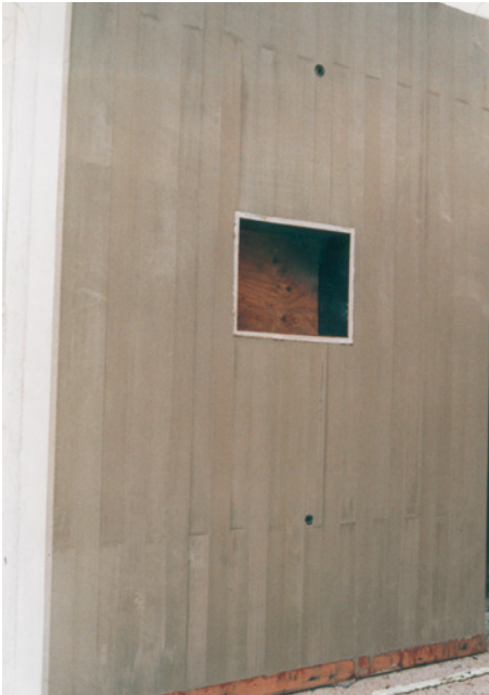
Bild 2.48 Probewand mit SVB als Sichtbeton
