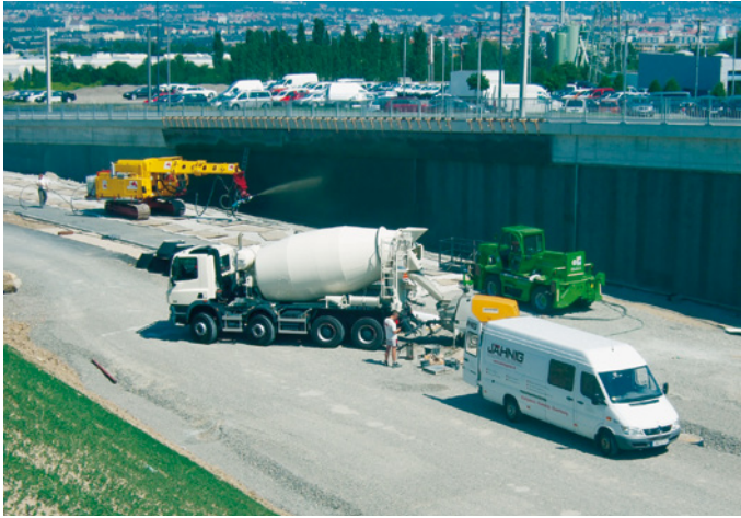
Bild 2.14 Maschinenkomplex für das Nassspritzen
