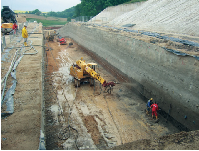
Bild 2.17 Spritzkopf am Teleskopausleger eines Baggers mit Raupenfahrfwerk
