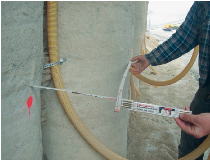
Bild 2.8 Abweichungen vom Soll der Auftragsfläche an einer Bohrfahrwand
