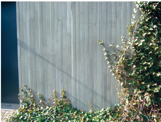
Bild 2.38 Sichtbetonfassade aus selbstverdichtendem Beton
