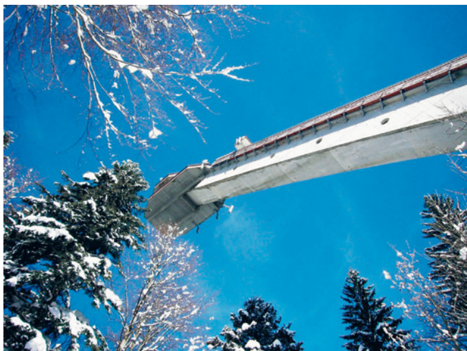
Bild 1.6 Skiflugschanze Oberstdorf, erbaut 1961 mit vorgespanntem Leichtbeton
