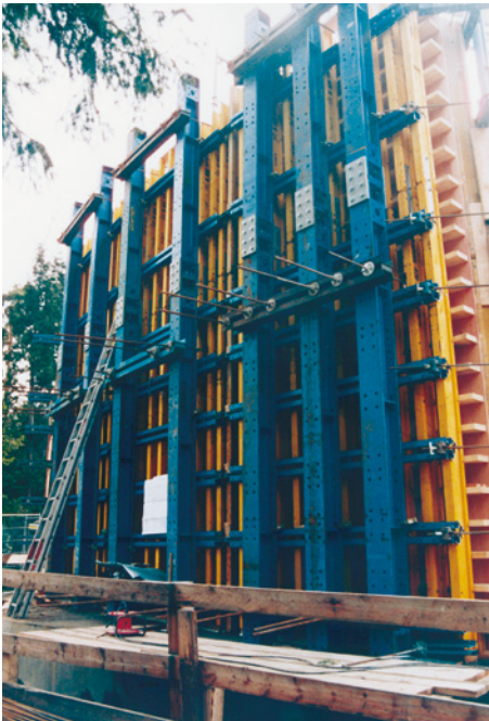
Bild 2.46 Schalung mit großer Wandhöhe für den Einsatz von SVB
