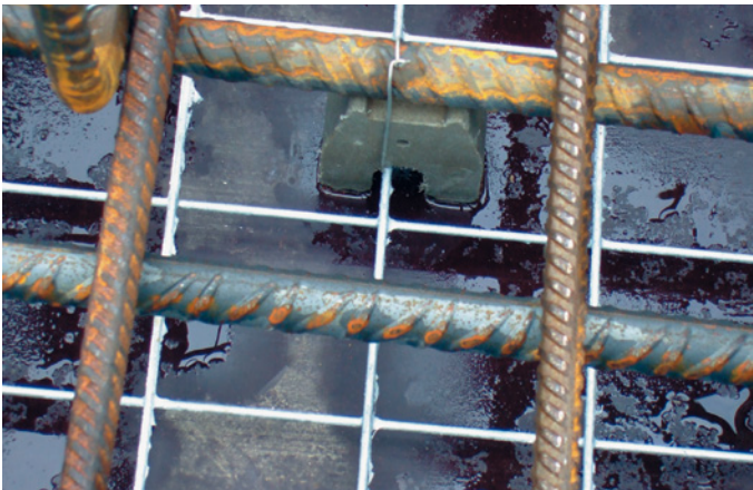
Bild 1.18 Befestigung der verzinkten Mattenbewehrung ohne Kontakt zur tragenden Bewehrung
