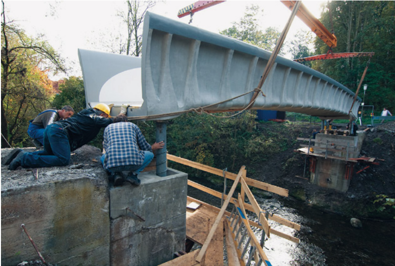
Bild 1.14 Fußgängerbrücke Kempten aus Textilbeton
