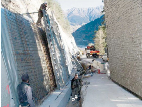
Bild 3.31 Wandschalung mit NOEplast-Strukturmatrize [3.90]
