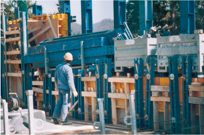
Bild 2.47 Operatives Aufbringen einer Last gegen den Auftrieb aus unterschiedlichen Wandhöhen
