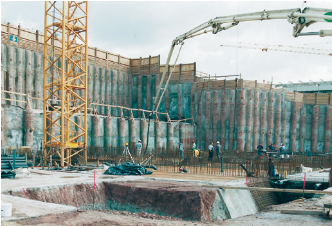
Bild 2.32 Aufgelöste Bohrfahlwand
