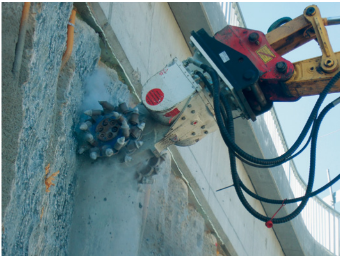
Bild 2.9 Mechanisches Herstellen der erforderlichen Position der Auftragsfläche
