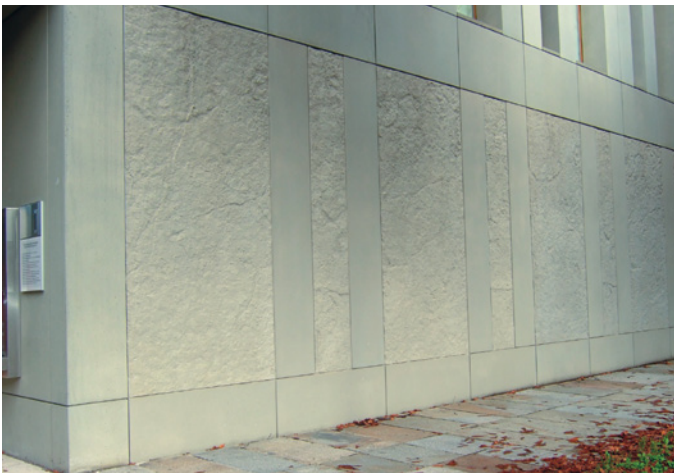
Bild 3.32 Fassadengestaltung mit Strukturschalungselementen
