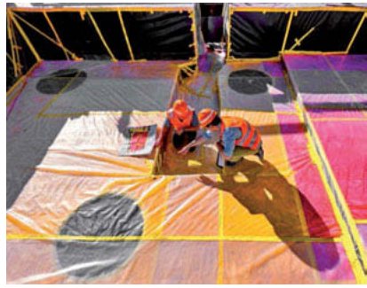
Bild 7 und 8: Matteneinbau im Bereich von Fundamentvertiefungen mit Pfahllagern
