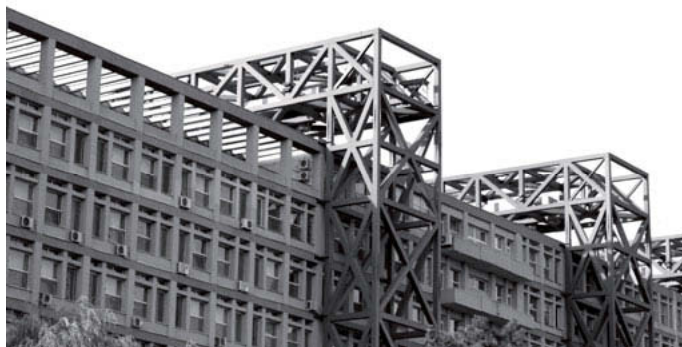
Bild 7: Ansicht nach Renovierung der Fassade und Errichtung der Stahlrahmen
