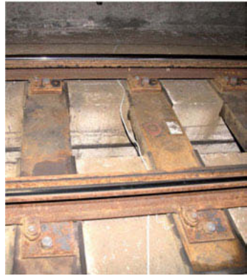
Bild 5: Gleisaufbau
