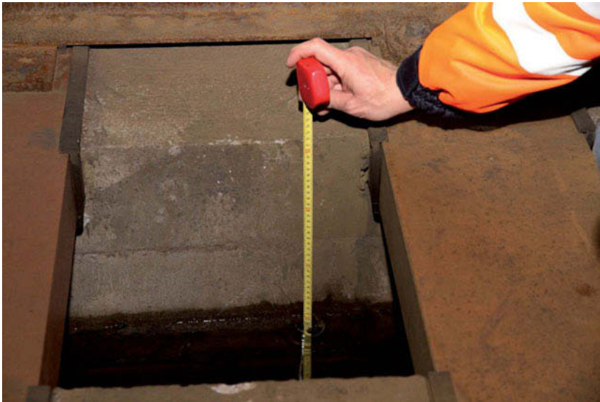
Bild 6: Stehendes Wasser im Bereich des MFS in der Längsrinne. Der Wasserstand beträgt ca. 20 cm
