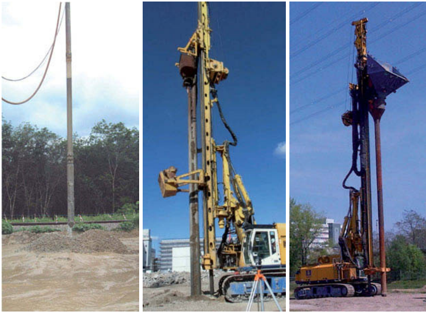
Bild 1: Von links: Tiefenrüttler zur Sandverdichtung, Schleusenrüttler und Stahlrohr mit Aufsatzrüttler
