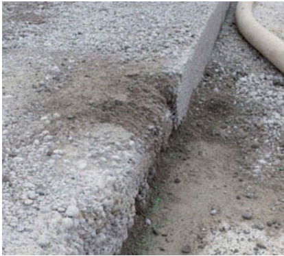
Bild 5: zurückgewiesene Abnahme der Magerbetonsohle Quelle: Basler & Hofmann AG
