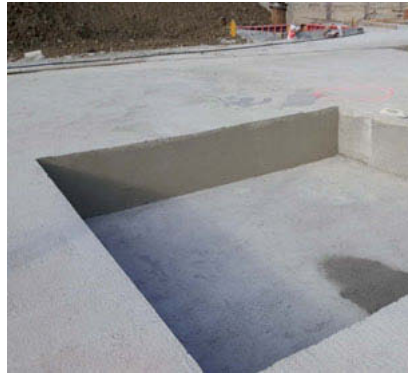
Bild 6: Abnahme Magerbetonsohle mit kleinen Nachbesserungen Quelle: Basler & Hofmann AG
