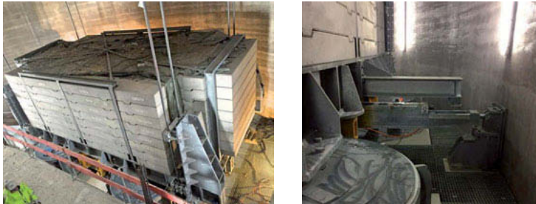
Bild 2: Links: Passives Tilgersystem (Einfachpendel) – Rechts: Aktuator (Linearmotor)
