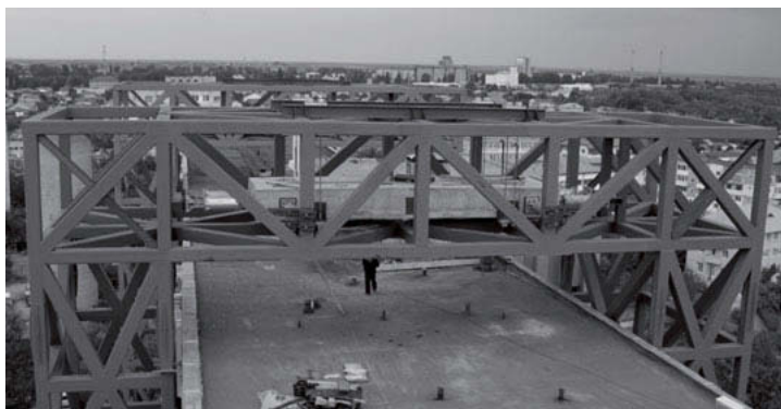
Bild 9: Ansicht des Tuned Mass Control Systems (TMCS) in einem der drei Stahlrahmen
