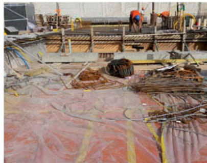
Bild 9 und 10: Eingebaute Matten bei der Abnahme durch den Fachingenieur und nach weiteren Arbeiten auf der Baustelle
