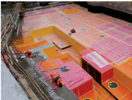
Bild 9 und 10: Eingebaute Matten bei der Abnahme durch den Fachingenieur und nach weiteren Arbeiten auf der Baustelle
