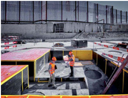
Bild 7 und 8: Matteneinbau im Bereich von Fundamentvertiefungen mit Pfahllagern
