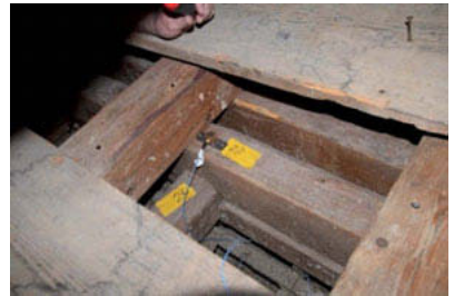
Bild 14: Anschluss eines Querträgers (MP 26) an einen Untergurträger (MP 27).
