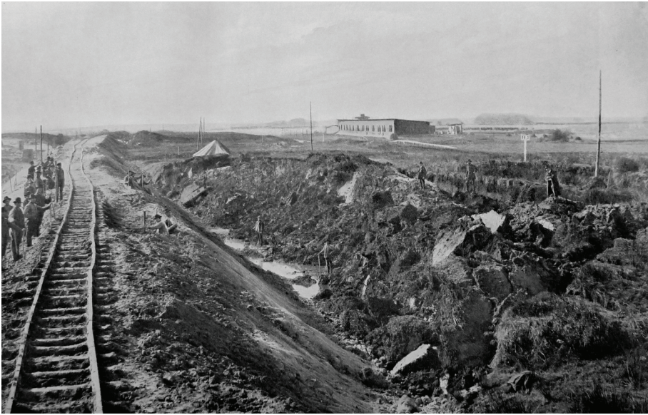
Abb. 2: Mooraufreibung an Sanddammschüttung, Oktober 1891. Quelle: Carl Loewe, Geschichte des Nord-Ostsee-Kanals, Festschrift zu seiner Eröffnung am 20./21. Juni 1895, Berlin 1895.
