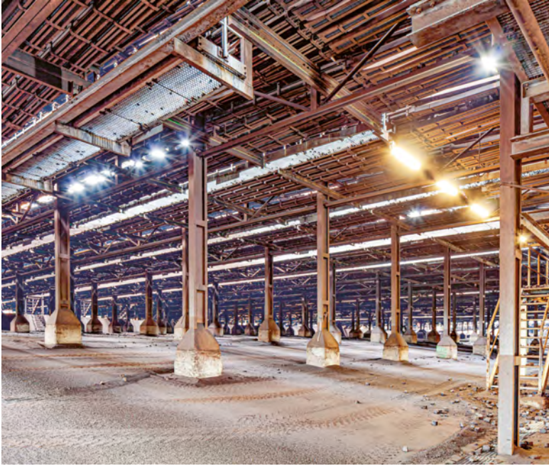
Abb. 8: Brikettfabrik Frechen-Wachtberg: Das Rinnenfeld zum Abkühlen der Briketts, Blick unter den Rinnen hindurch, Foto 2022.
