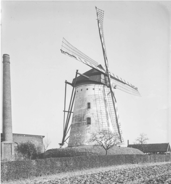
Abb. 3: Ölmühle in Kalkar-Grieth, nach 1800, Foto 1930.
