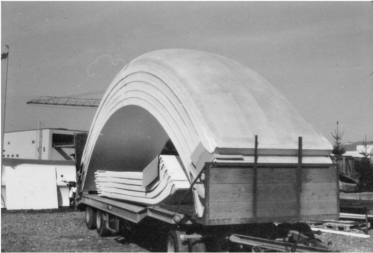
Abbildung 14: Die vorfabrizierten Schalelemente aus Kunststoff, 1983. 73
