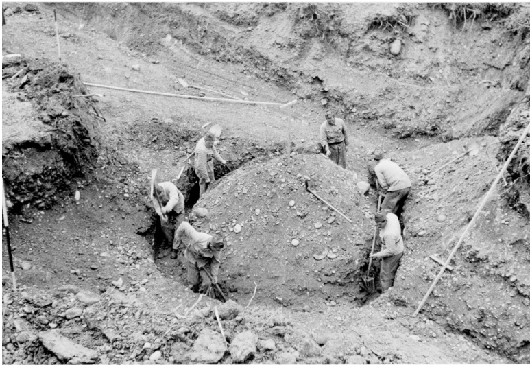
Abbildung 6: Die Vorbereitung des Erdkerns für den Atomunterstand, 05.12.1955. 5
