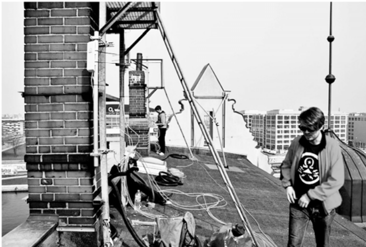
Abbildung 1: Freifunker*innen verlegen Kabel bei FluxFM
