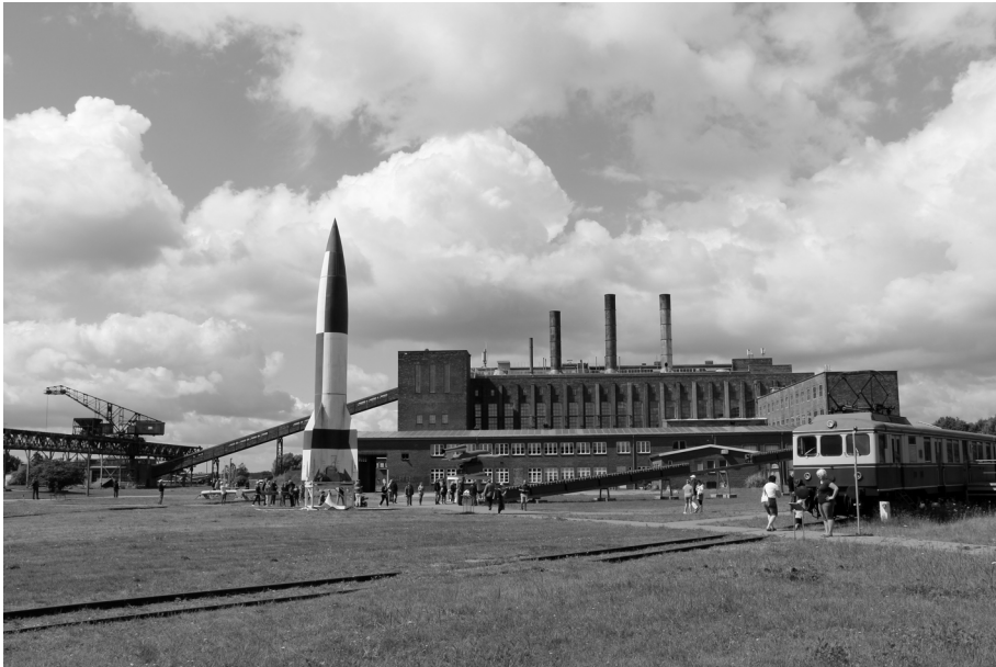
Abb. 1: Das 1991 gegründete Historisch-Technische Museum Peenemünde (HTM) befindet sich im ehemaligen Kohlekraftwerk der Versuchsanstalten. Neben dem Kraftwerk, den Bekohlungsanlagen, der Kranbahn und einem Triebwagen der Werksbahn sind auch Modelle der A4-Rakete (,V2‘) und der Flugbombe Fieseler Fi 103 (,V1‘) zu sehen. Quelle: Historisch-Technisches Museum Peenemünde GmbH, 2017
