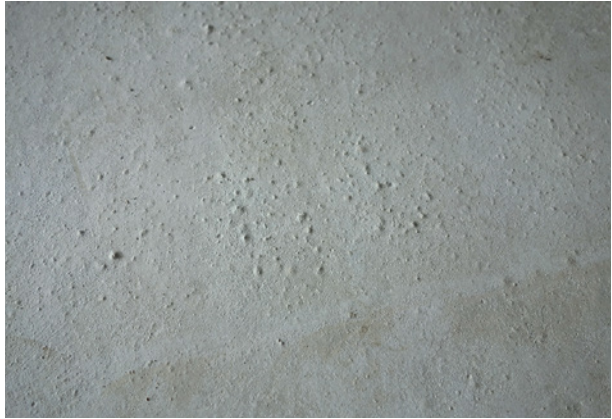
Bild 18 ■ Zementestrich mit einer Zementleim- schicht und pickelartiger Oberfläche
