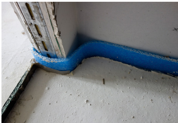
Bild 36 ■ Nicht fachgerecht ausgebildeter Randdämmstreifen
