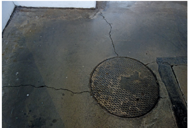
Bild 42 ■ Risse in einem alten Betonuntergrund
