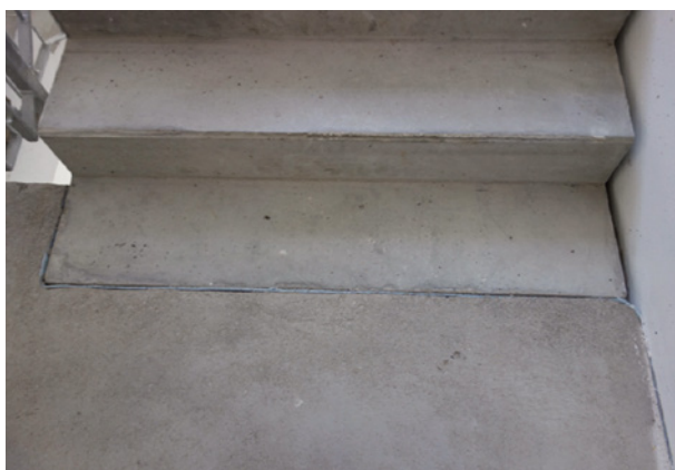
Bild 34 ■ Bewegungsfuge zwischen Stahlbeton-Treppenlauf und Stahlbeton-Treppenpodest
