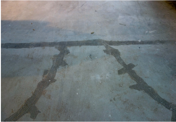
Bild 40 ■ Kraftschlüssig verharzte Risse
