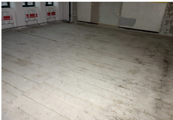
Bild 71 ■ Dielenböden müssen bei der Verlegung mit Oberbelag hinterlüftet werden.
