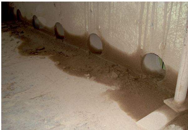
Bild 63 ■ Nachträglich eingedrungene Feuchtigkeit in den Untergrund durch das Kühlwasser des Betonschneiders
