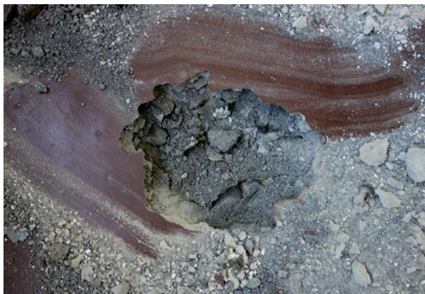
Bild 10 ■ Dieser Schlackeestrich ist nicht mehr tragfähig, wie augenscheinlich zu erkennen ist
