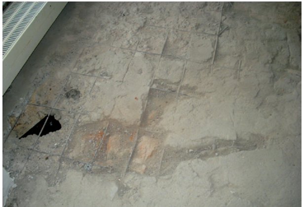
Bild 24 ■ Alte Betonuntergründe erfordern zur Erzielung der Ebenheiten häufig zusätzlich einen Höhenausgleich.
