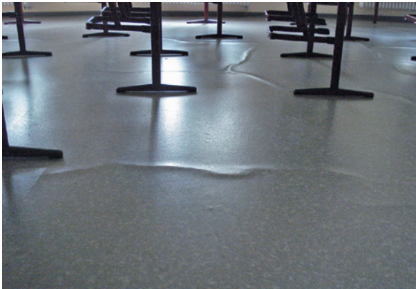
Bild 29 ■ Die Scheinfugen und Risse wurden hier nicht fachgerecht kraftschlüssig verharzt.
