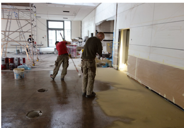
Bild 75 ■ Auftragen einer Epoxidharzgrundierung, die in den frischen Auftrag abgequarzt wird.
