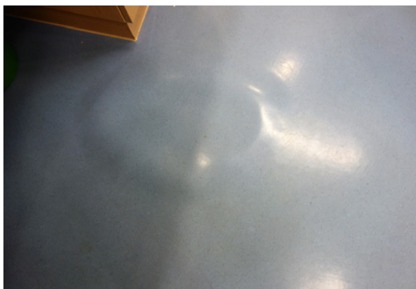
Bild 92 ■ Blasen und Beulen im elastischen Belag durch zu hohe Untergrundfeuchte.
