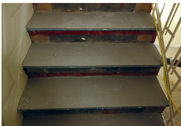
Bild 49 ■ Fachgerecht gespachtelte Treppenstufen vor der Belagsverlegung
