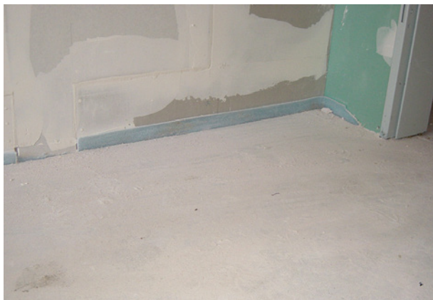
Bild 37 ■ Im Bereich des Randdämmstreifens muss der Estrichleger nacharbeiten.
