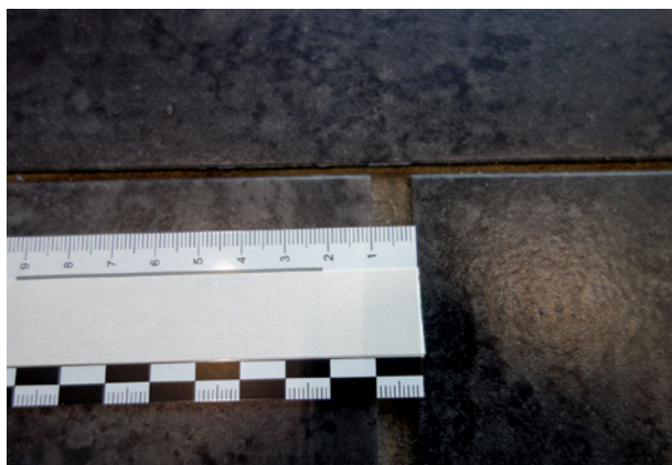
Bild 89 ■ Fugenbreiten von 10 mm deuten auf Material- und Kleberprobleme hin.
