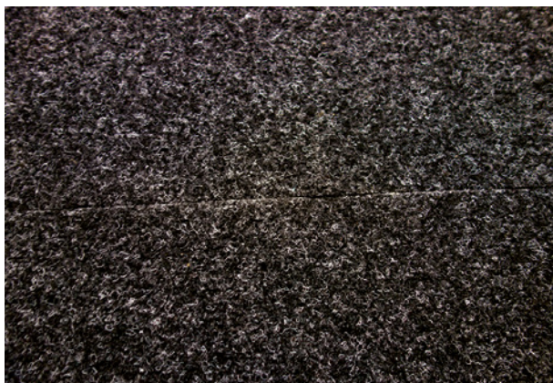
Bild 82 ■ Fugen im Nadelvliesbelag
