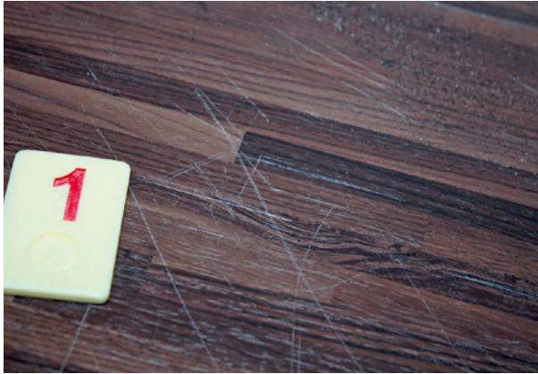
Bild 91 ■ Extrem zerkratzte Belagsoberflächen lassen sich nicht retuschieren und haben unterschiedliche Ursachen.
