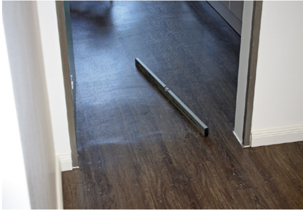
Bild 90 ■ Kellenschläge werden von Bauherren nicht akzeptiert.
