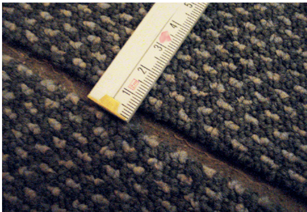
Bild 81 ■ Fugenbildung im textilen Bodenbelag aufgrund nicht ausreichenden Klebstoffauftrages und Einsatz ungeeigneter Werkzeuge
