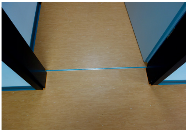
Bild 33 ■ Fachgerecht ausgeführtes Fugenprofil unter dem Türblatt
