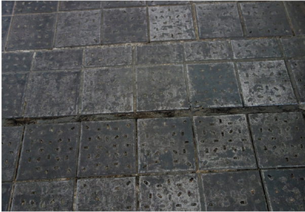
Bild 35 ■ Diese alte Bauwerksfuge darf nicht kraftschlüssig geschlossen werden, da der Untergrund aus in den Stahlbeton verankerten perforierten Stahlplatten besteht
