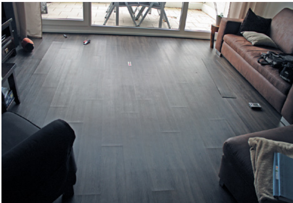
Bild 86 ■ Diese Stippnähte wird kein Nutzer akzeptieren.
