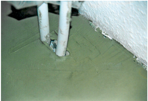
Bild 52 ■ Die Isolierummantelung wurde bündig mit Oberkante Estrich abgeschnitten. In der Folge ist die Spachtelmasse zwischen Isolierummantelung und Heizungsrohr gelaufen.
