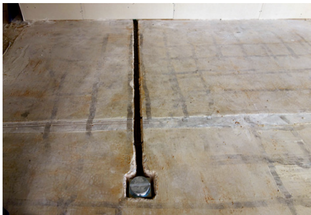
Bild 44 ■ Zum fachgerechten Schließen dieser Fehlstelle reichen die vorhandenen 2 cm Einbauhöhe nicht aus.
