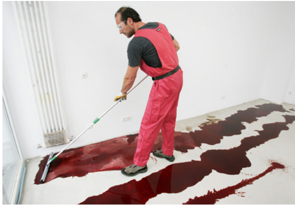
Bild 76 ■ Auftragen einer porenfüllenden Reaktionsharzgrundierung
