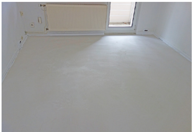
Bild 20 ■ Fach- gerecht eingebauter Calciumsulfatfließestrich
