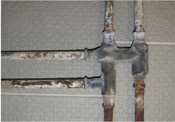
Bild 54 ■ Stark korrodiertes Heizungsrohr
