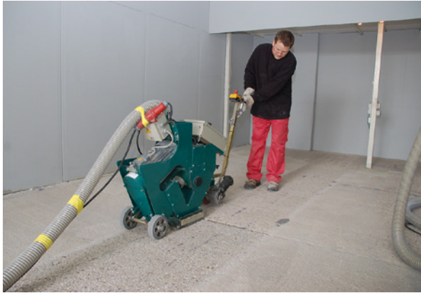
Bild 13 ■ Kugelstrahlen einer Betonoberfläche
