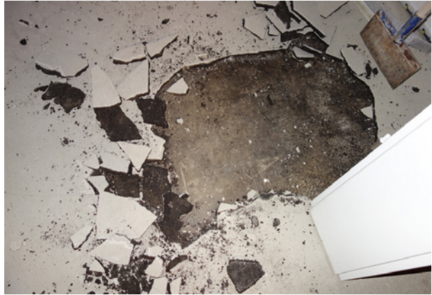
Bild 11 ■ Der bituminöse Untergrund war von der Betonbodenplatte vollflächig abgeplatzt. Die Spachtelmasse war fest mit dem bituminösen Untergrund verbunden.
