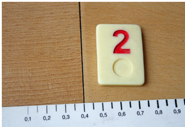
Bild 87 ■ Fugenbreiten bis 0,5 mm in PVC-Designbelägen gelten als hinnehmbare Unregelmäßigkeiten.
