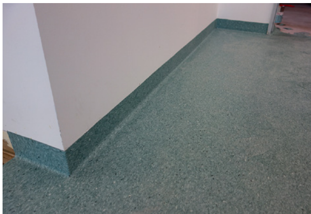
Bild 94 ■ Fachgerecht eingebaute Hohlkehlsockelleiste
