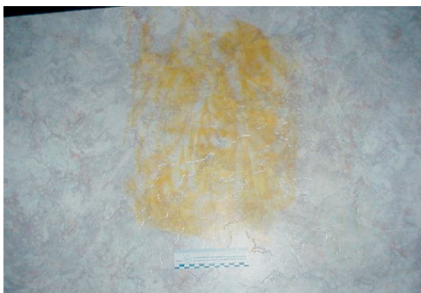
Bild 103 ■ Verfärbung auf einem Fußbodenbelag, verursacht durch eine zusammengefaltete Luftmatratze unter einem Bett
