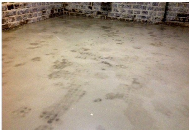
Bild 21 ■ Verunreinigungen des Untergrundes durch Öl, Wachs, Lacke wirken hydrophob
