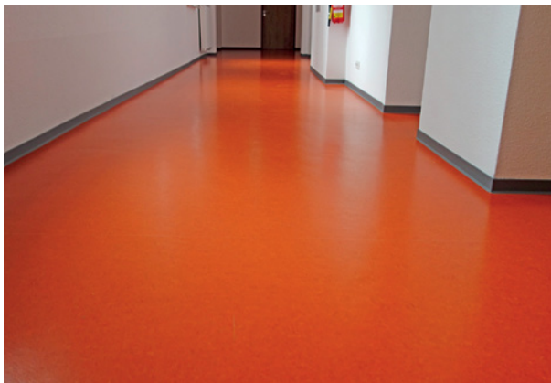
Bild 83 ■ Bei der Linoleumverlegung ist darauf zu achten, dass die Bahnen richtungsgleich zu verlegen sind.
