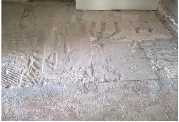
Bild 23 ■ Altuntergründe sind problematisch, wenn die erforderlichen Ebenheitstoleranzen erzielt werden sollen.
