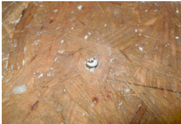
Bild 73 ■ Die Nägel haben sich aufgrund der Bewegung der Holzbalkendecke aus den OSB-Platten gelöst.
