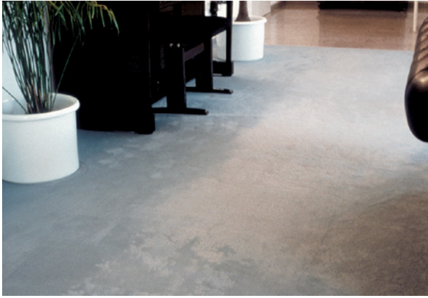
Bild 98 ■ Polveränderungen in der Zone der stärksten Frequentierung
