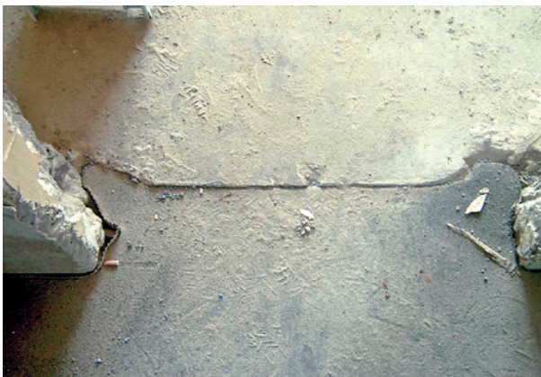
Bild 30 ■ Zwischen dem Anhydritestrich und dem Gussasphaltestrich ist eine Bewegungsfuge anzuordnen. Das ist bei dieser Ausführung nicht möglich. Der Estrichleger muss hier nacharbeiten, eine fachgerechte Bewegungsfuge ausbilden.
