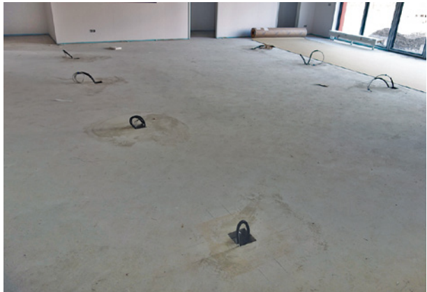
Bild 19 ■ Calciumsulfat- fließestrich, teilweise mit einer Sinterschicht
