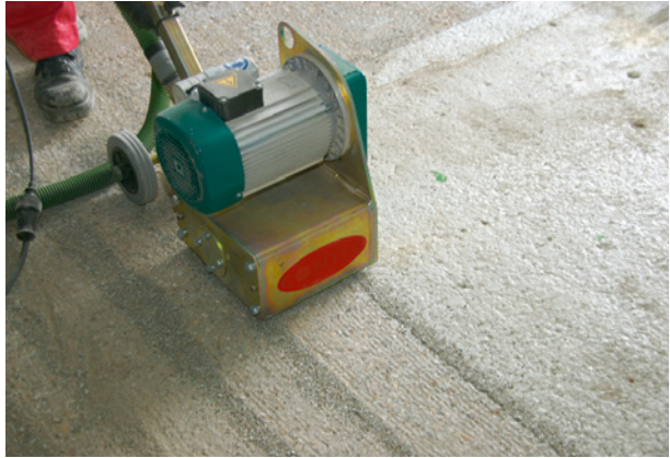
Bild 78 ■ Fräsen einer kritischen Estrichrandzone
