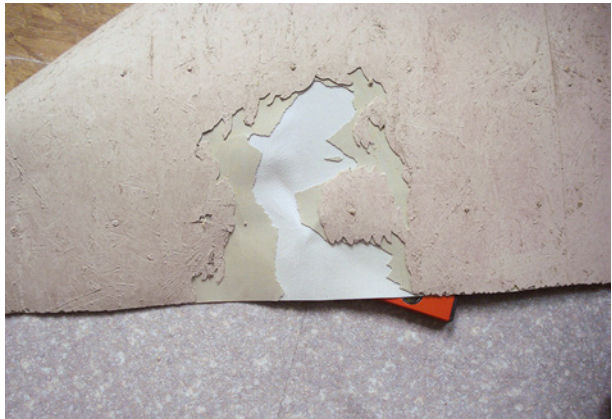
Bild 79 ■ Hier wurde beim Überspachteln des kritischen Untergrundes die Schichtdicke von fünf Millimetern überschritten. Die Spachtelmasse platzte ab und hängt fest verbunden am Oberbelag.
