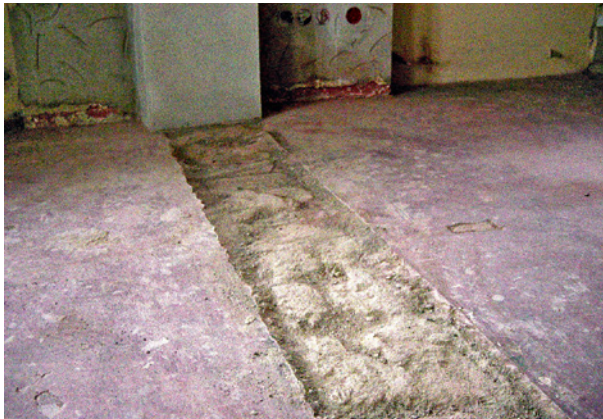
Bild 46 ■ Breite und flache Fehlstellen sollten mit einem Epoxidharzmörtel geschlossen werden.
