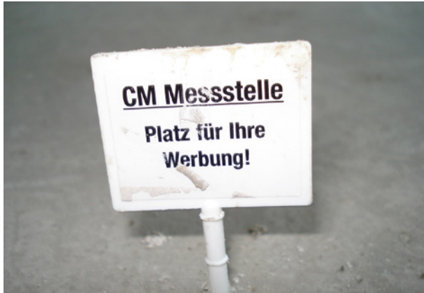
Bild 59 ■ Fachgerechte Markierung einer Messstelle im Heizestrich
