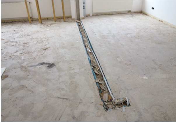
Bild 45 ■ Im Bereich des Randdämmstreifens muss der Estrichleger nacharbeiten.
