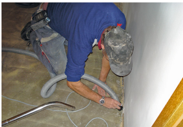
Bild 38 ■ Die Randfugen sind intensiv zu säubern, besonders bei Altestrichen.
