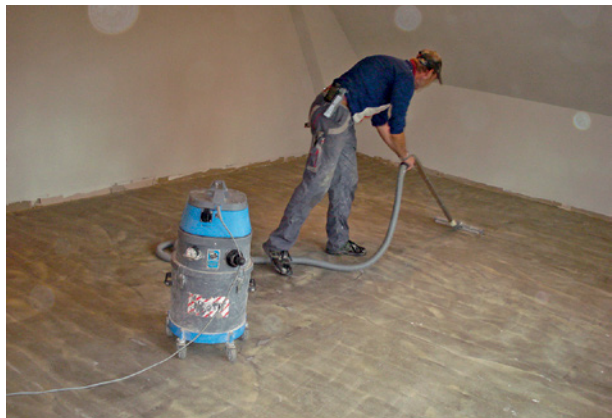
Bild 65 ■ Nach der Untergrundvorbehandlung ist der Untergrund mit einem Industriesauger abzusaugen.
