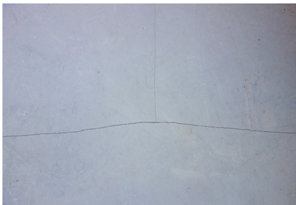
Bild 39 ■ Risse in einem neu eingebauten Zementestrich
