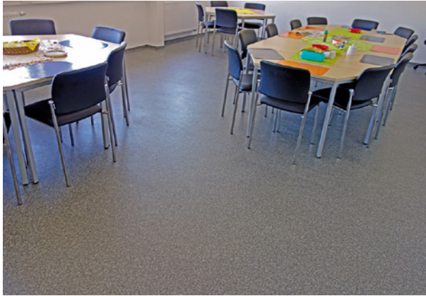
Bild 85 ■ Aufstandsflächen und Möbelgleiter müssen auf den Bodenbelag und die Verlegewerkstoffe abgestimmt sein.
