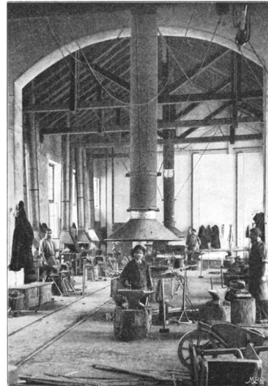
Abb. 3: Schmiedewerkstatt auf der Nordseite des Simplontunnels. Quelle: S. Pestalozzi, Die Bauarbeiten am Simplontunnel, Sonderabdruck Schweizerische Bauzeitung 39, 1902, S. 28, Abb. 69.
