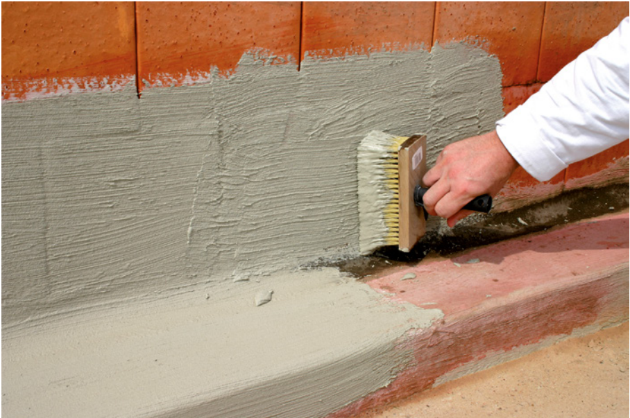
Bild 7: Herstellen des Hinterfeuchtungsschutzes [Quelle: Hölzen]
