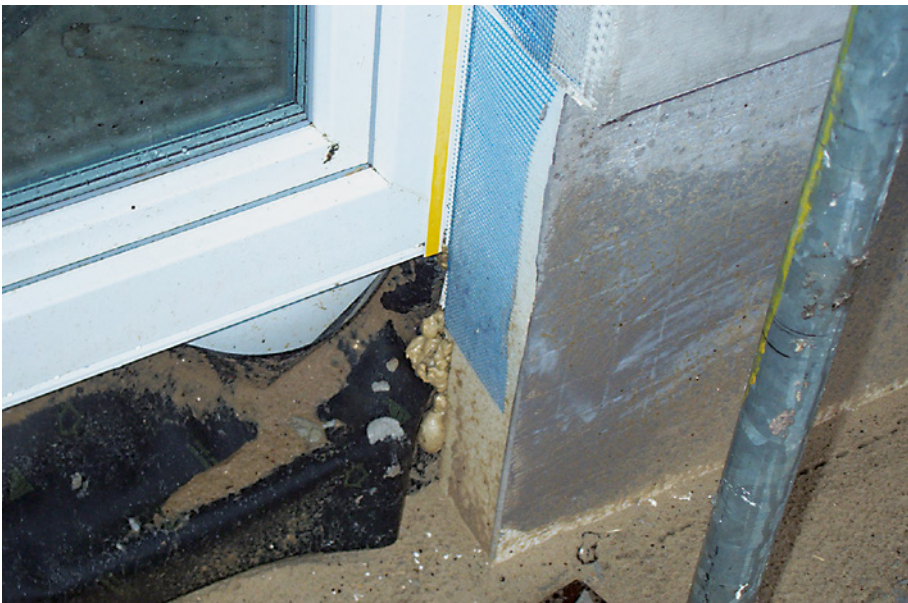
Bild 31: fehlerhafter Türanschluss [Quelle: Hölzen]
