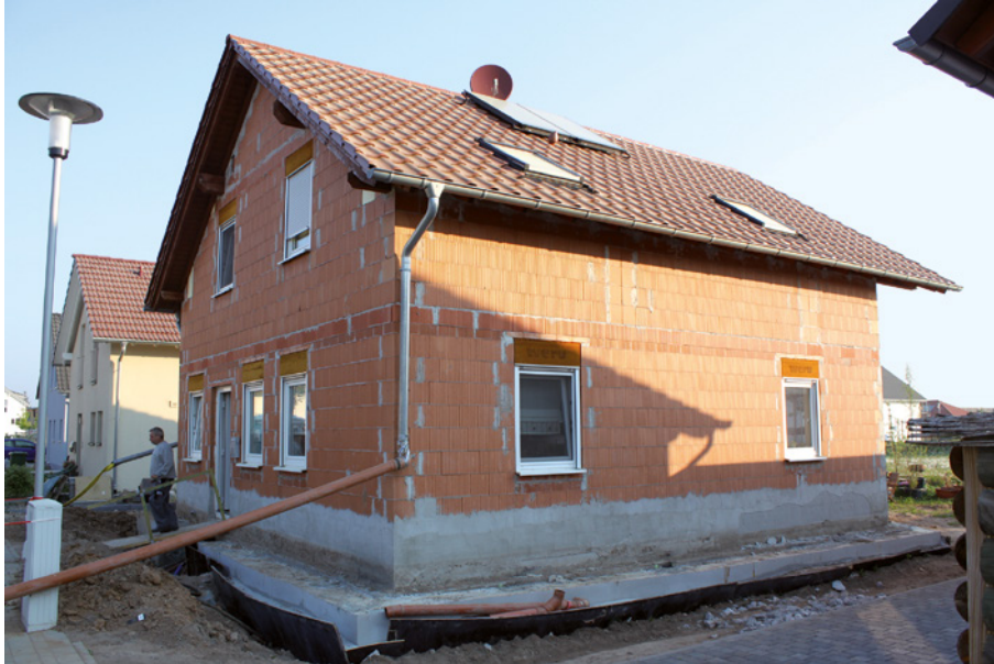
Bild 44: Objektansicht Bodenplatte schon angehoben [Quelle: Stefan G. Hock, Firma Adikon]
