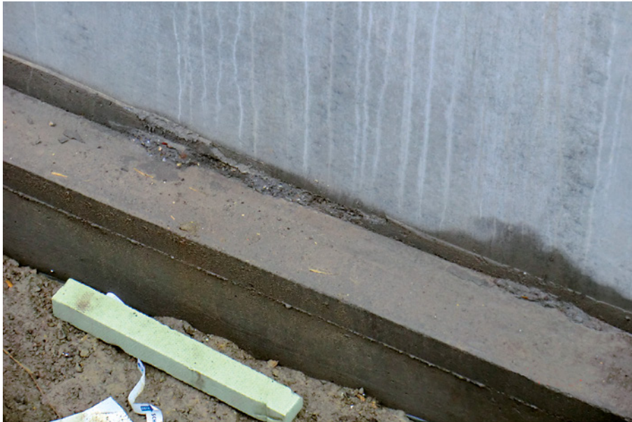
Bild 1: Mangelhafter Sohlenwandanschluss [Quelle: Hölzen]
