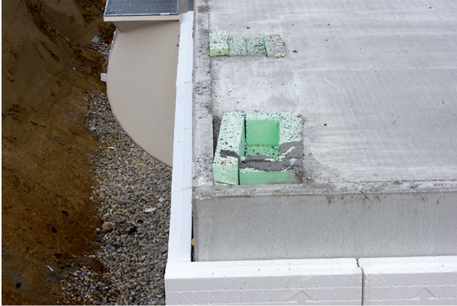
Bild 42: Betonaußenwände ohne eine Bauwerksabdichtung oder Sockelabdichtung [Quelle: Hölzen]
