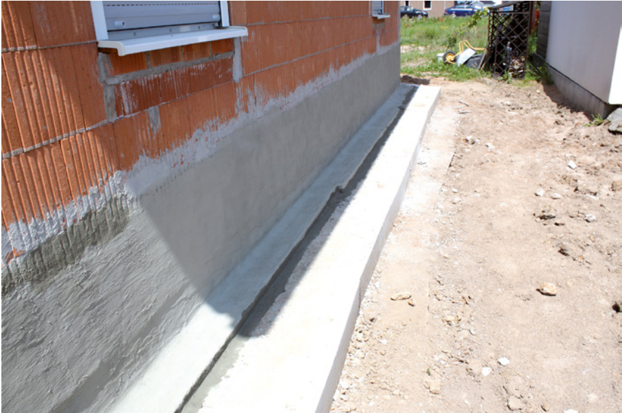
Bild 45: Auftrag der Dichtungsschlämme als Hinterfeuchtungsschutz [Quelle: Stefan G. Hock, Firma Adikon]
