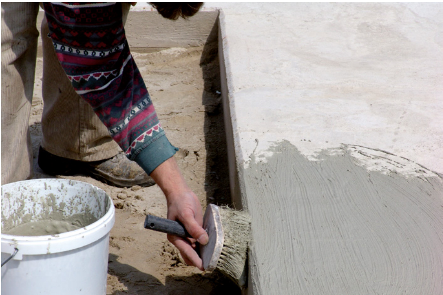
Bild 4: Auftrag einer Haftschrämme [Quelle: Hölzen]
