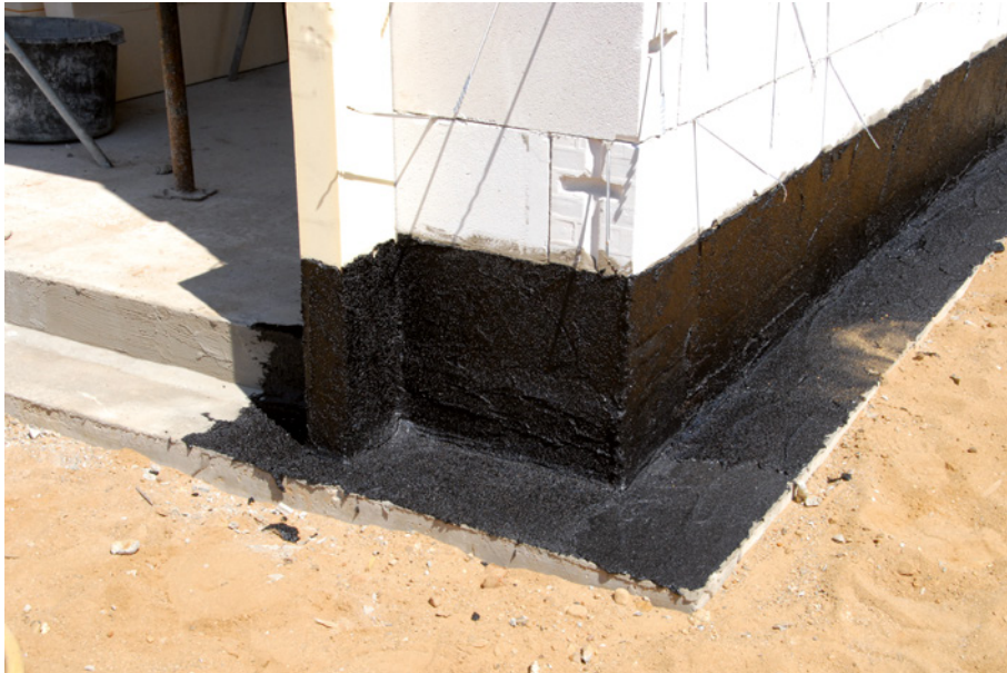
Bild 52: Fußpunkt vor der Verblendung, mit PMBC abgedichtet [Quelle: Hölzen]
