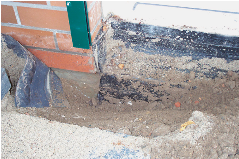
Bild 33: mangelhafter Anschluss – Terrassentür [Quelle: Hölzen]
