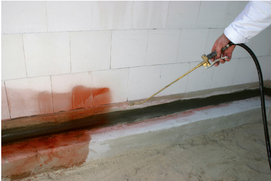
Bild 5: Grundierung im Wandaufsatzbereich [Quelle: Hölzen]
