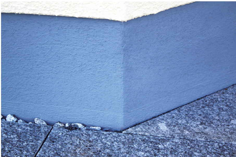
Bild 48: fertiger Sockel im Detail: Abdichtungshöhe ca. 6–7 cm über OKG [Quelle: Stefan G. Hock, Firma Adikon]
