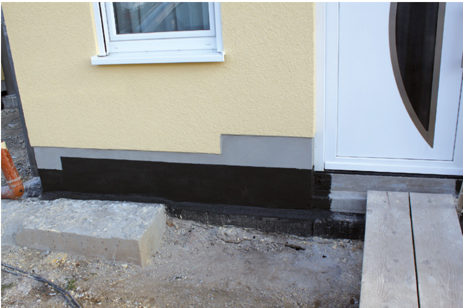
Bild 46: Sockel mit flexibler Dichtungsschlämme abgedichtet [Quelle: Stefan G. Hock, Firma Adikon]
