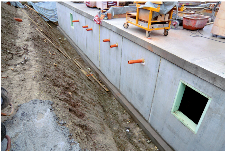
Bild 2: Vorbereiteter Sohlenwandanschluss [Quelle: Hölzen]
