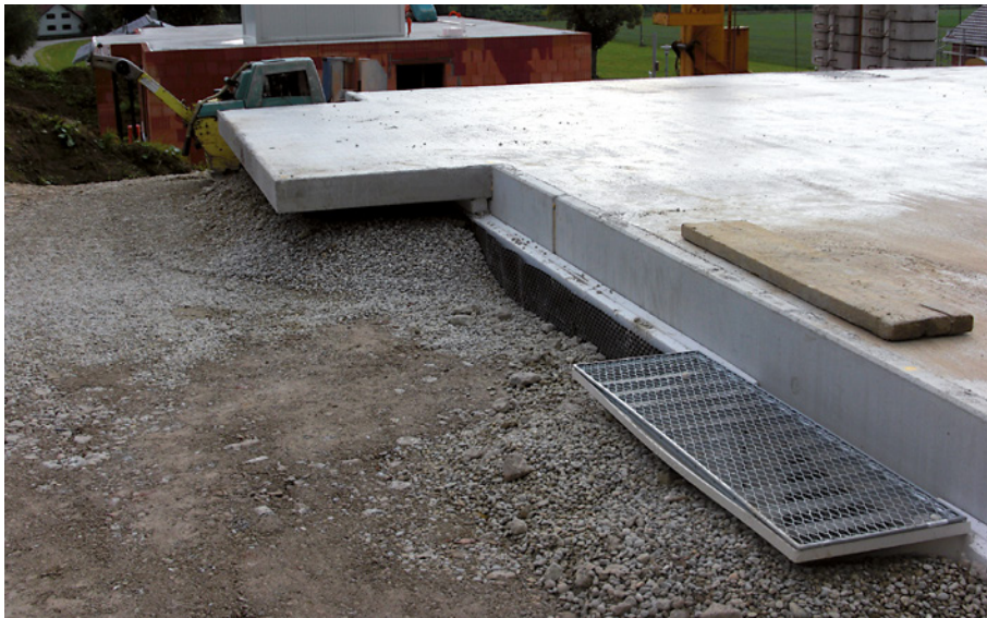
Bild 43: keine Sockelabdichtung [Quelle: Hölzen]
