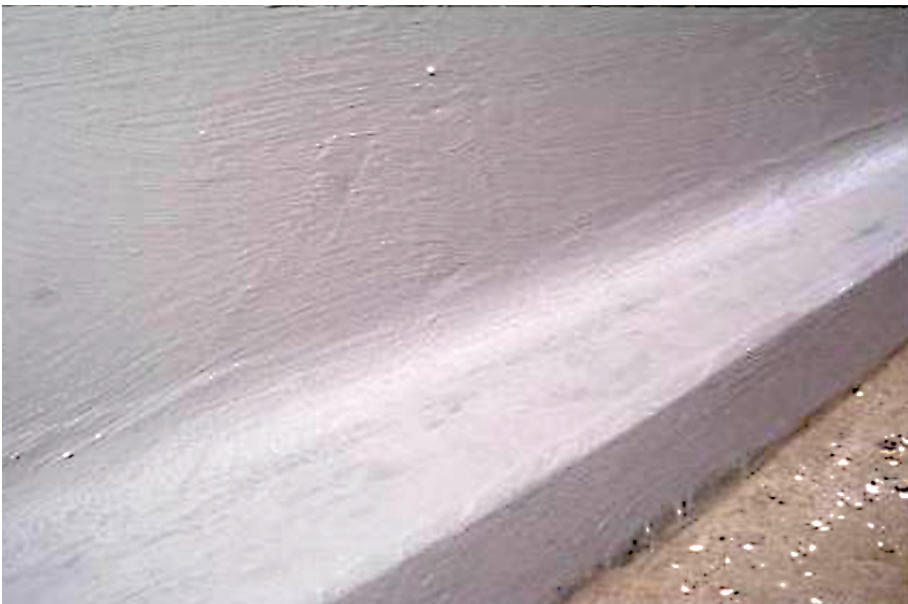
Bild 8: Wasserdichter Anschluss mit Dichtungsschlämmen [Quelle: Hölzen]
