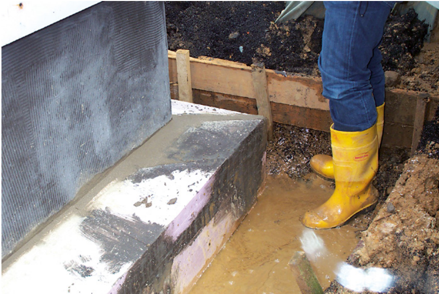
Bild 28: Vollflächige Verklebung der Dämmplatten [Quelle: Hölzen]
