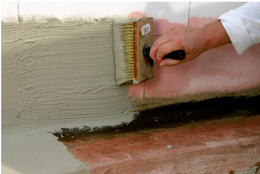
Bild 6: Eingebaute Dichtungskehle und Grundierung für die Fläche [Quelle: Hölzen]
