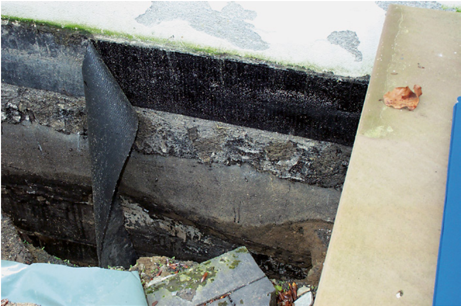
Bild 30: mangelhafte Abdichtung und Dämmung [Quelle: Hölzen]
