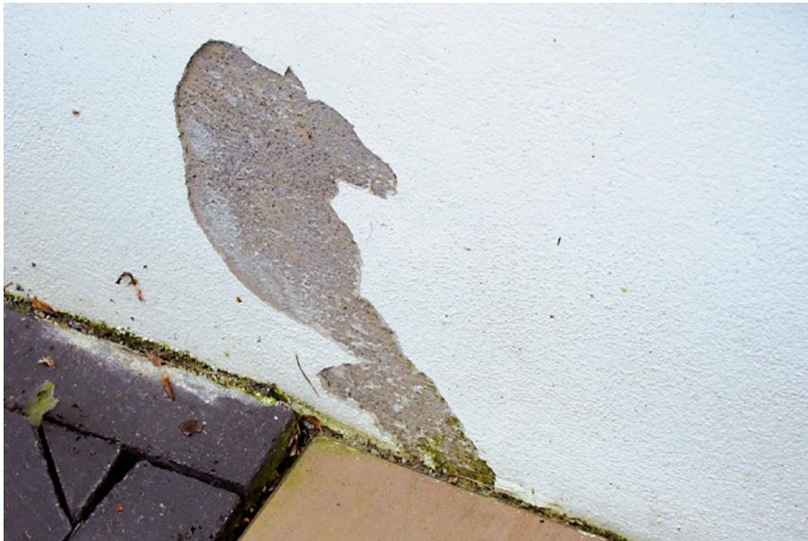
Bild 29: Anstrich und Putzschaden [Quelle: Hölzen]
