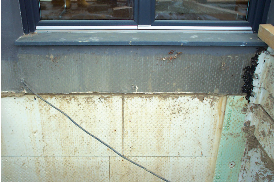
Bild 37: mangelhafter Abschluss der Bauwerksabdichtung am Sockel [Quelle: Hölzen]
