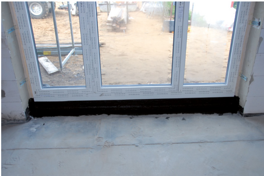
Bild 53: Fenster und Bodenanschluss mit PMBC abgedichtet [Quelle: Hölzen]
