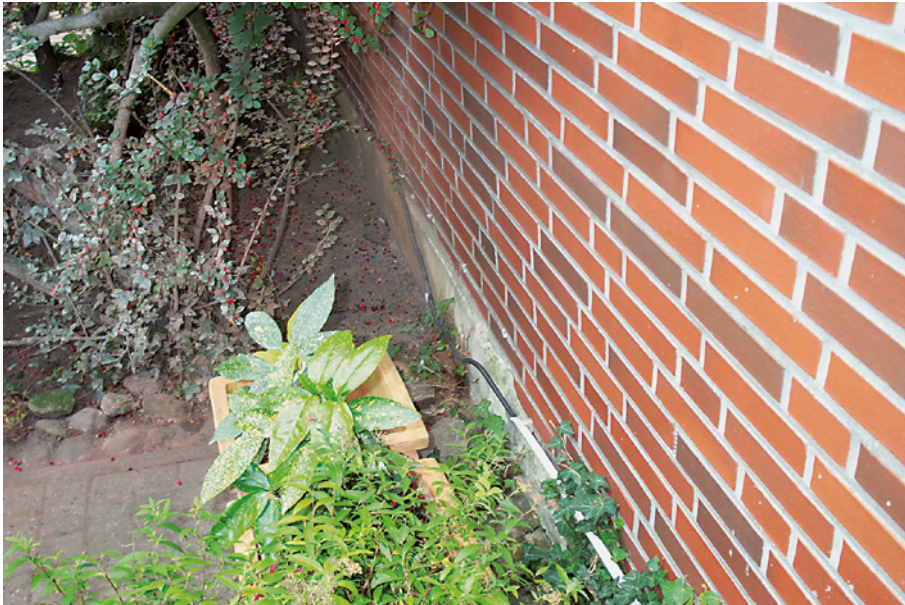
Bild 32: fehlende Bodenplattenabdichtung [Quelle: Hölzen]
