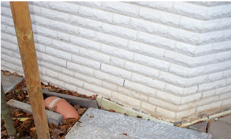
Bild 36: kein Anschluss der Abdichtung an den Sockel [Quelle: Hölzen]
