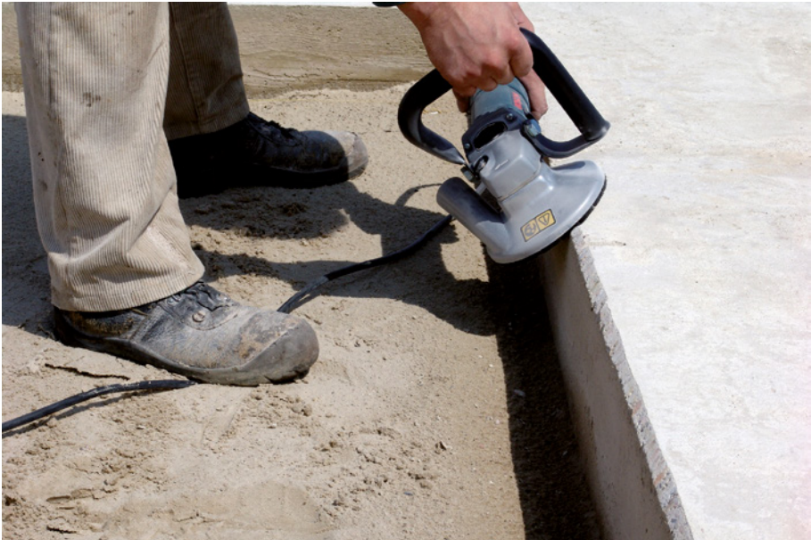
Bild 3: Herstellen der Fasse [Quelle: Hölzen]
