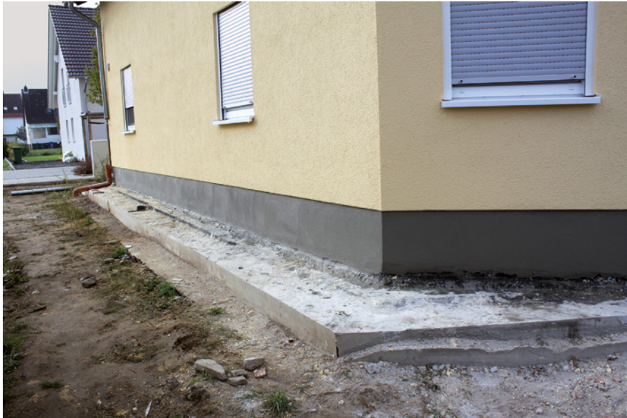
Bild 47: ausgeführter Sockelputz [Quelle: Stefan G. Hock, Firma Adikon]
