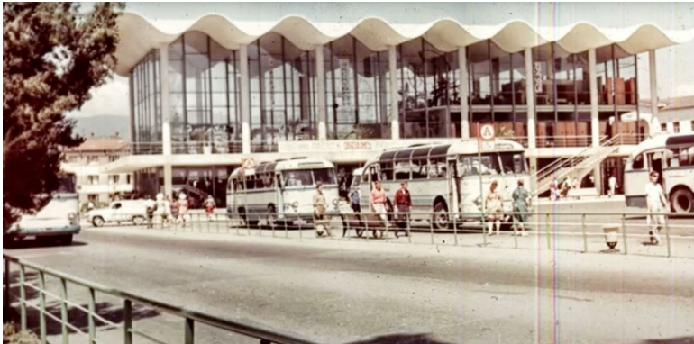
Abb. 1: Bushaltestation in Sotchi 1968, Russland/UdSSR
