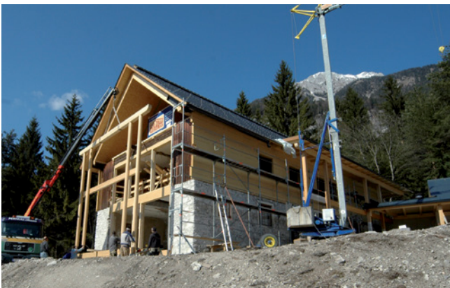
Abb. 5: Primärkonstruktion Balkon, Holzweichfaserplatten montiert
