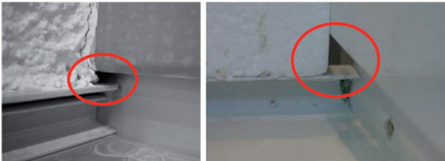
Abb. 4: Wassereintrittsstelle im Bereich des Gewerkeloches
