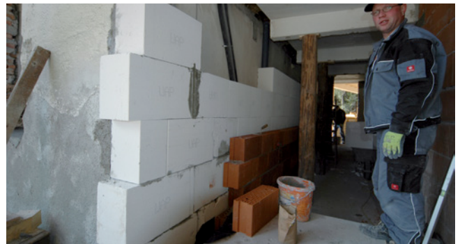
Abb. 14: Mineralschaumplatten samt Vormauerung nach Durchtrennung der nördlichen Stahlbetondecke
