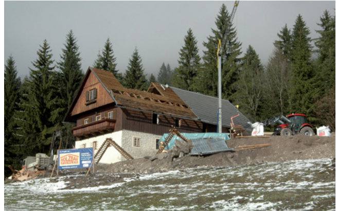
Abb. 2: Abbrucharbeiten des alten Dachstuhls
