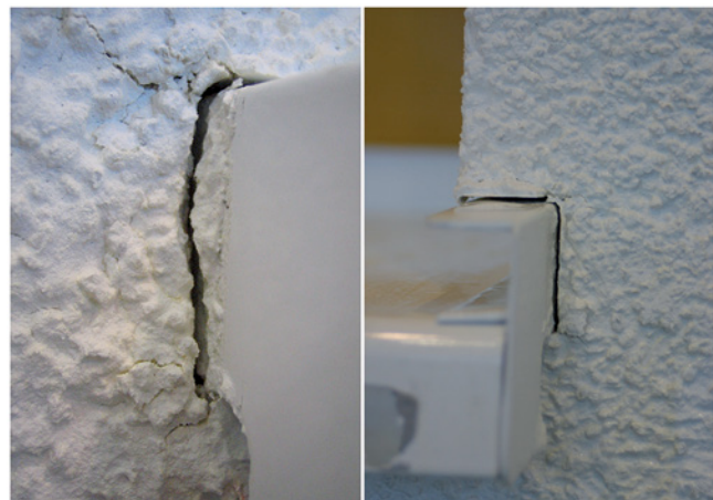
Abb. 2: Putzabrissfugen im Bereich des Anschlusses Fensterbank/ WDVS
