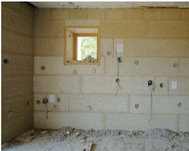
Abb. 9: Einbau der Messsonden
