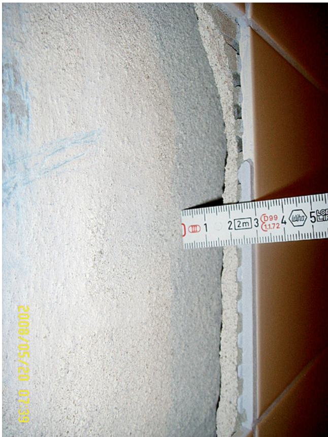
Abb. 8: Die Schichtentrennung erfolgte auf diesem Betonuntergrund innerhalb des Grundputzes.
