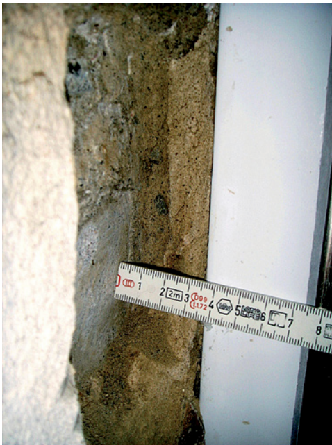
Abb. 2: Schichtdicke eines zweischichtig applizierten Gipszement-Unterputzes von ca. 35 mm Dicke. Die erste Schicht ist durchfeuchtet und im Gefüge mürbe, d. h. der Gips hat seine Bindekraft verloren.
