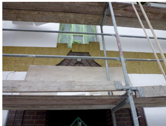
Abb. 4: Brandriegel für ein EPS-Wärmedämmverbundsystem
