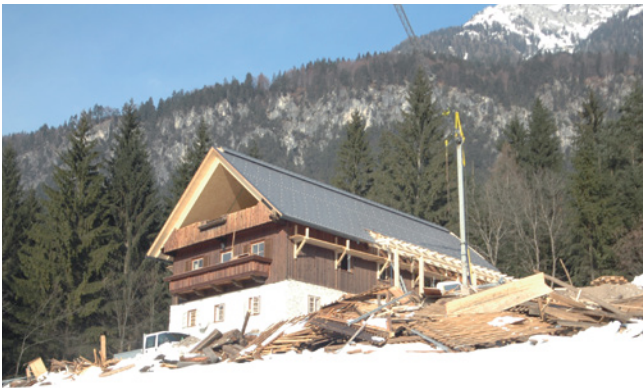
Abb. 3: neuer Dachstuhl samt neuer Dachdeckung
