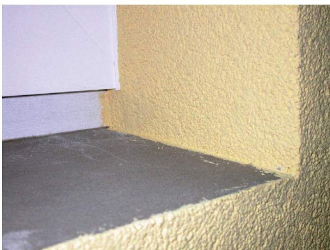
Abb. 7: 2. Dichtebene ausgeführt mit Dichtschlämme auf bereits 5° nach außen geneigtem Parapet (mittels Dämmkeil)
