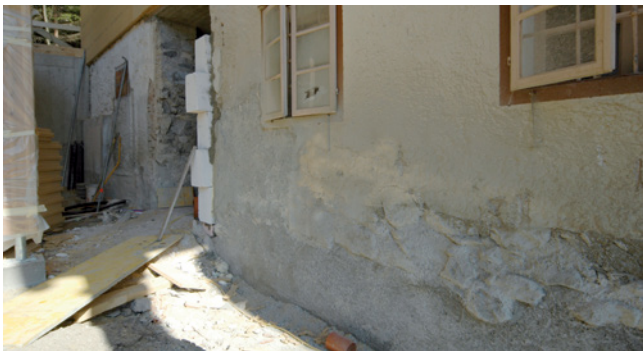
Abb. 13: trockengelegte Außenwand vor Herstellung der Außendämmung
