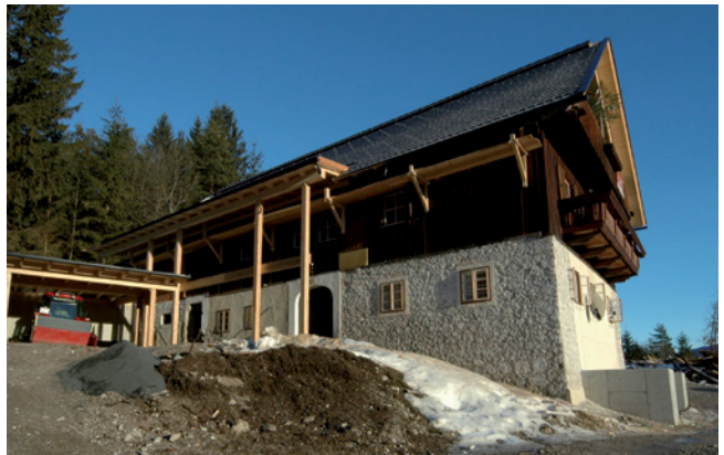
Abb. 4: der Außenputz wurde abgeschlagen
