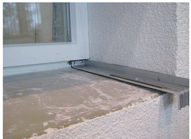
Abb. 6: Am Fenster montierter Rillengleit-Anschluss. Die Fensterbank wird in weiterer Folge eingelegt und befestigt.
