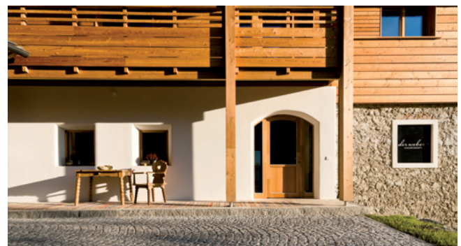
Abb. 16: Außendämmung im nördlichen Bereich des Einganges mit abgeschrägten Fensterlaiben
