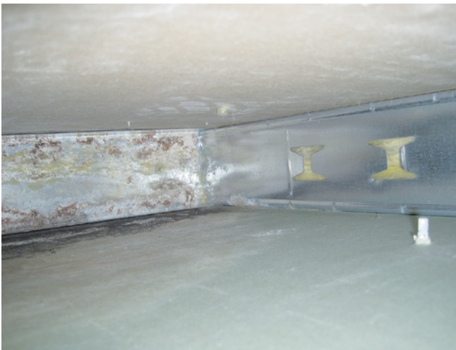
Abb. 7: Rückseite der Trennwand geöffnet (Rost an den Profilen)
