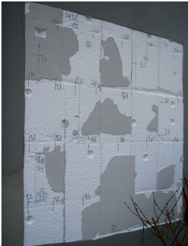
Abb. 13: Erstmessung der freigelegten Fugen
