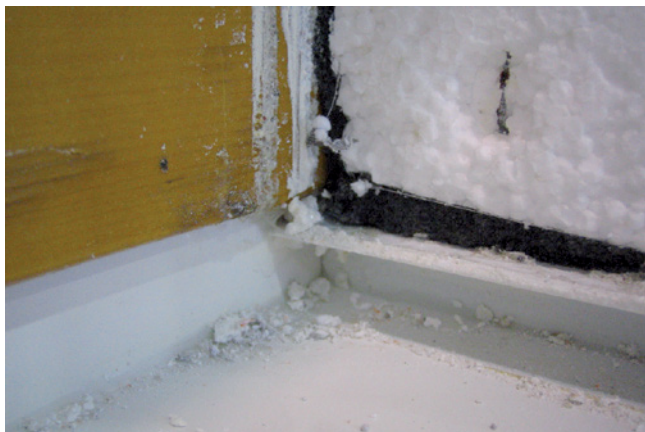
Abb. 3: nicht ordnungsgemäß eingebautes Fugendichtband im Anschluss Laibungs-EPS zu Fensterrahmen und Fensterbankendprofil. Der Komprimierungsgrad ist zu gering.
