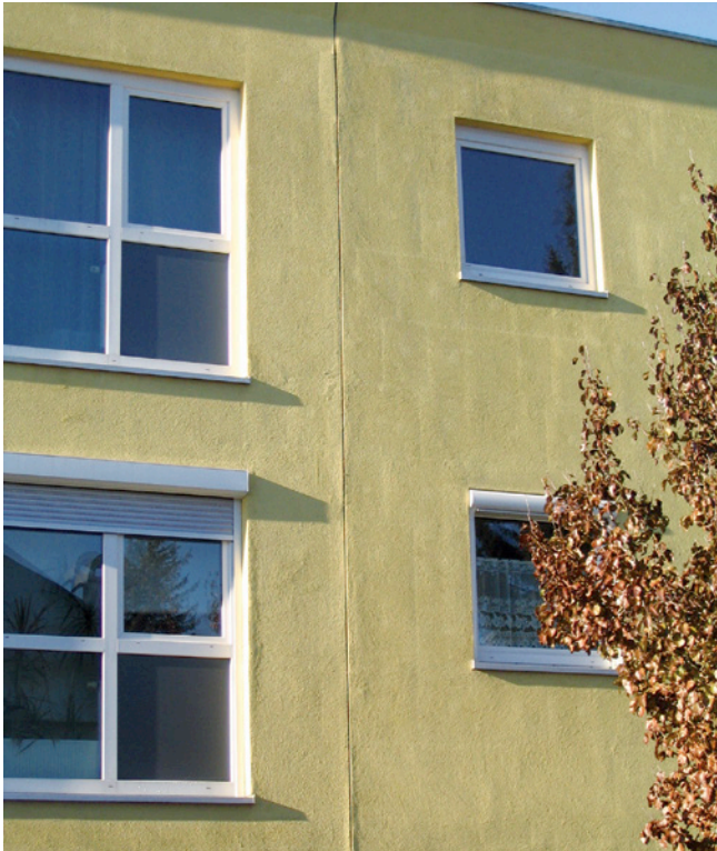
Abb. 9: Nachschwinden des Dämmstoffs
