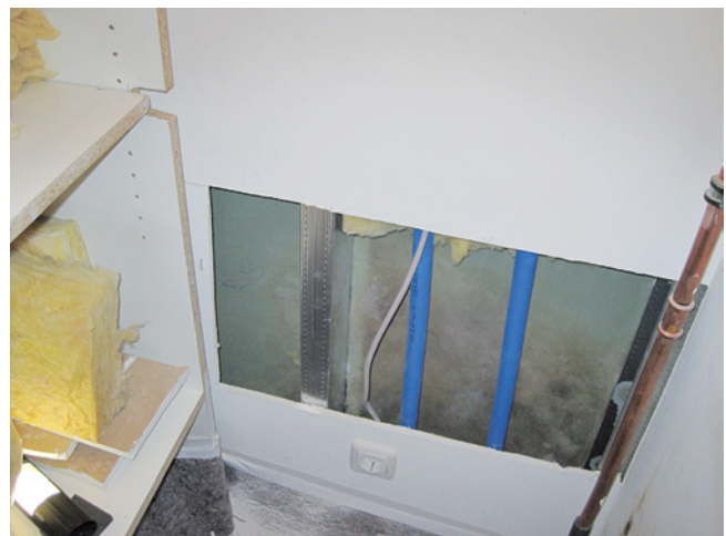
Abb. 5: Rückseite der Trennwand geöffnet (Schimmelbildung)
