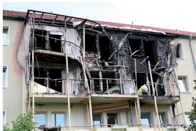
Abb. 2: Brandbeschädigtes WDVS (Quelle: Feuerwehr Erfurt)
