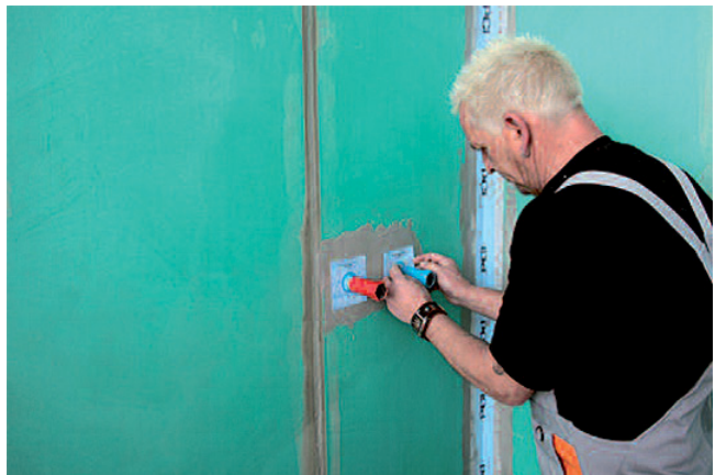
Abb. 3 (Quelle PCI): Vor den Plattenarbeiten müssen Dichtmanschetten um die Rohrdurchdringungen und Dichtbänder über dem Inneneck-Anschluss eingebaut werden.
