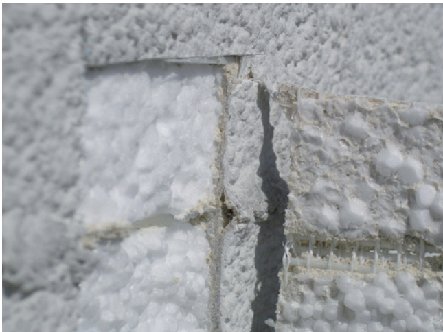
Abb. 2: Detailaufnahme Quetschfalte, Dehnung des Textilglasgitters
