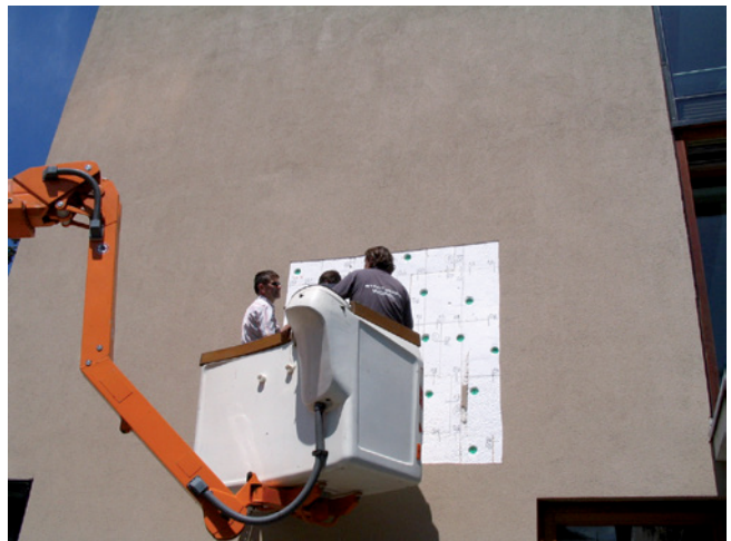
Abb. 11: großflächige Sondierung
