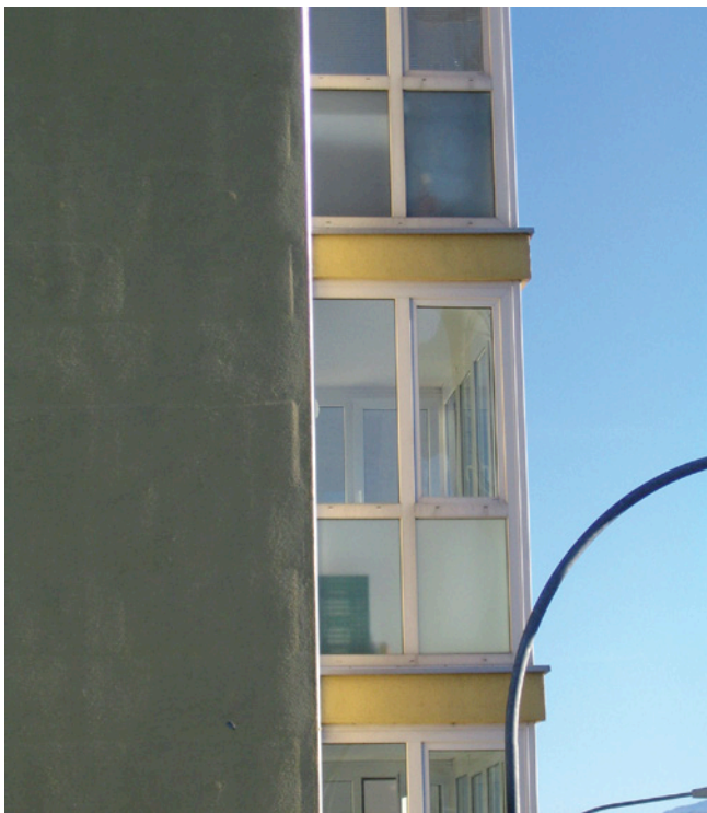
Abb. 10: Schwindverformung im Eckbereich
