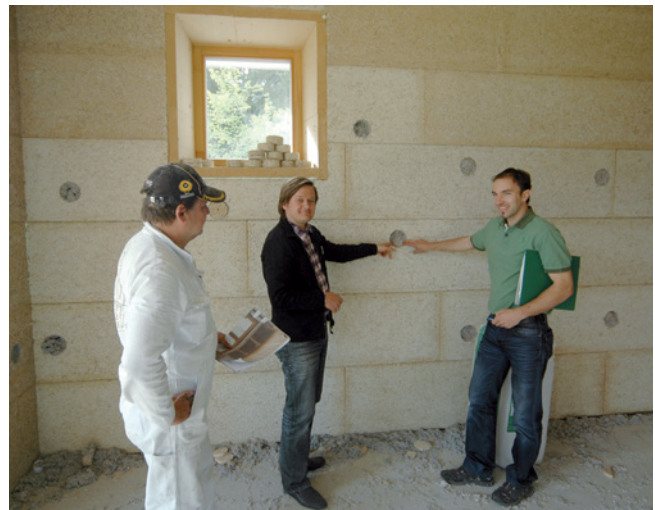
Abb. 10: Einbau der Messsonden
