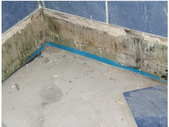
Abb. 4: Dusche - Duschwanne entfernt
