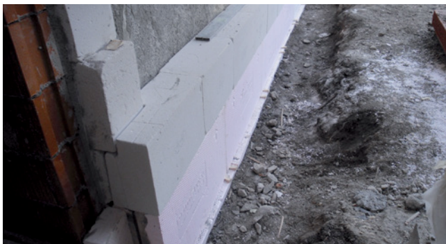
Abb. 15: Die 26cm starke Außendämmung wird 70cm unter Terrain geführt. Unter Niveau werden die Mineralschaumplatten durch XPS-Platten ersetzt.
