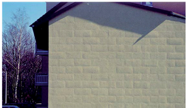
Abb. 3: Matratzenefekt durch unzureichende Dämmplattenbefestigung
