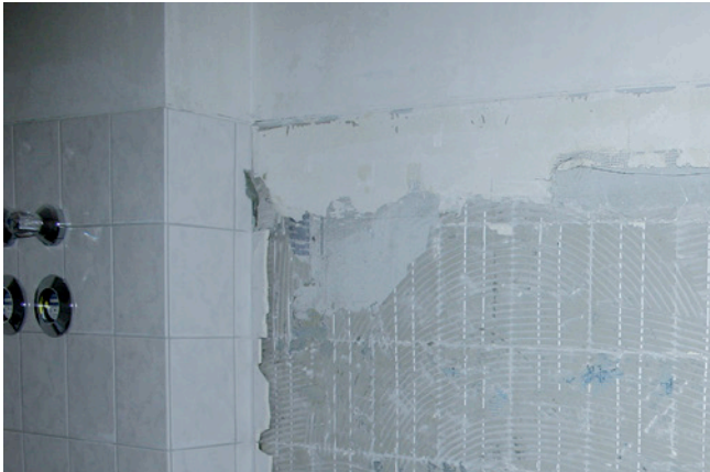
Abb. 10: Untergrund zementgebundene Platten, Spachtelfuge statt Klebefuge, Kreuzfuge
