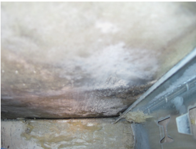
Abb. 6: Rückseite der Trennwand geöffnet (Schimmelbildung und Rost an den Profilen)
