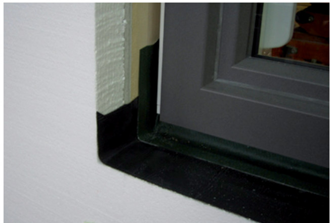
Abb. 8: 2. Dichtebene ausgeführt mit wannenförmig geklebten Folien
