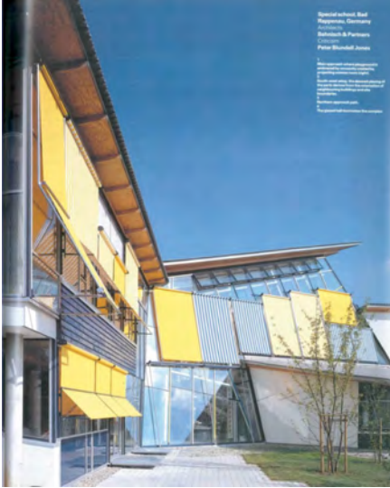
Abb. 29: Albert-Schweizer-Schule, Bad Rap- penau (Deutschland) (1992)
