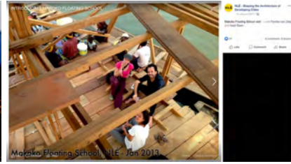
Abb. 76: Besuch von Iwan Baan und Femke van Zeijl beim Bau der MFS, Jan 2013
