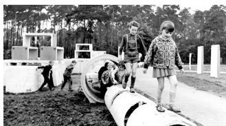
Abb. 17: Freizeitkomplex Ost, Hoyerswerda 1970.
