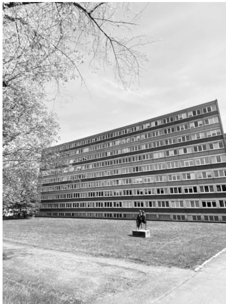
Abbildung 7: Ehemaliges Internatsgebäude in der Reichenhainer Straße 39.
