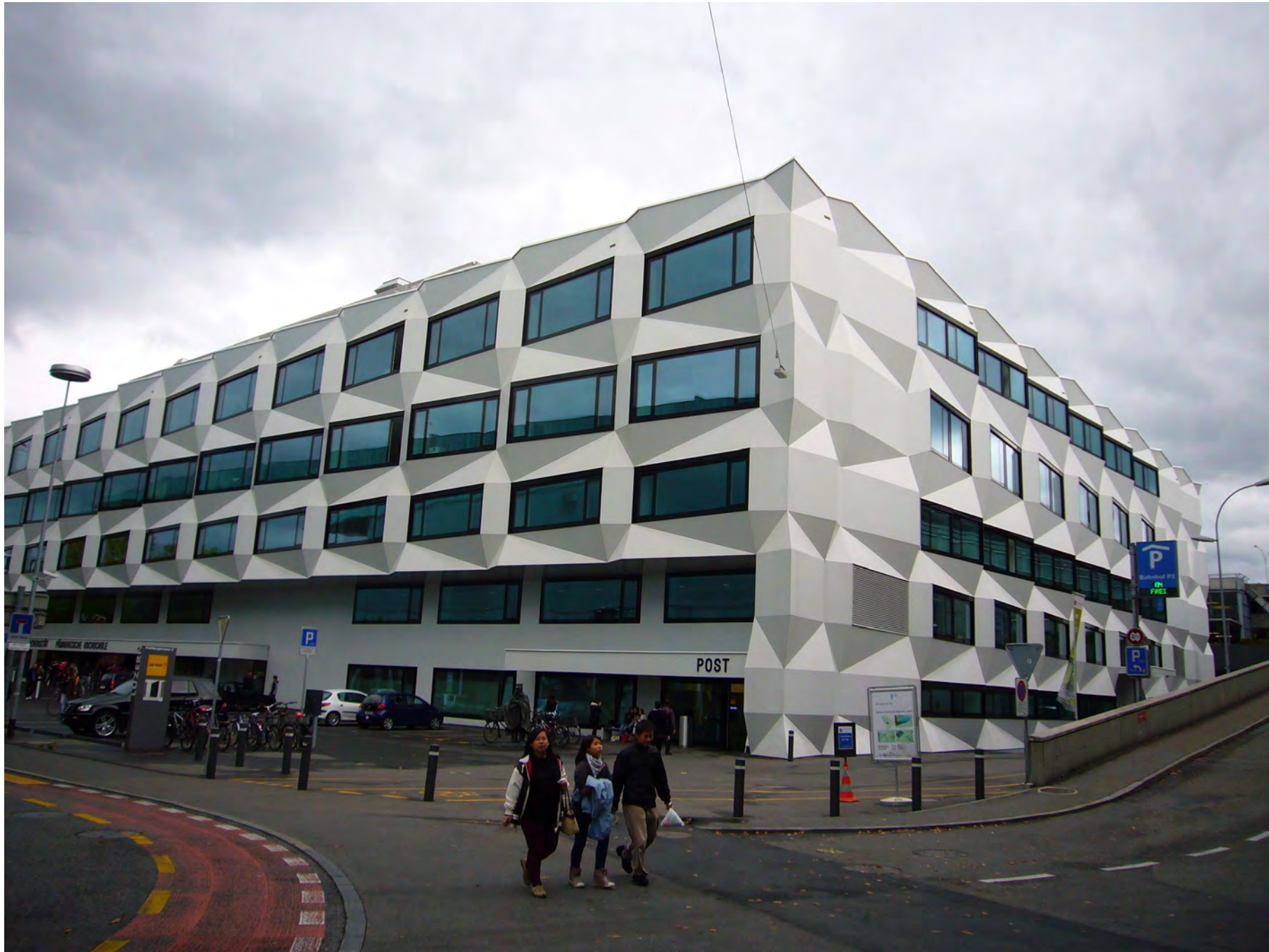
Abb. 10: Uni/PH Luzern: Die neue Fassade des ehemaligen Postgebäudes
