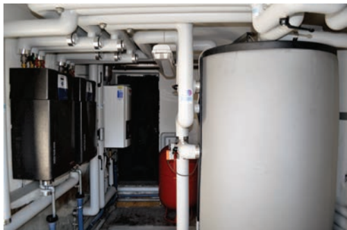
Heizraum mit 85 kW-Wandkessel hinten (nachher)
