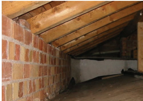
Foto 1: Unbeheizter Dachraum, Einfamilienhaus Bj. 1961, unverputzte Außenwand (rot)
