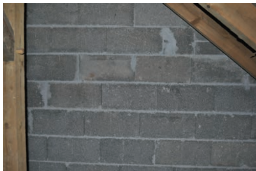
Foto 3: Unverputzte Giebelwand im unbeheizten Dachraum des MFH, 30 cm Hbl (grau)
