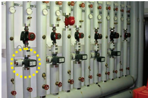
Sechs Heizkreise mit Pumpe, Thermometer sowie Absperrventilen, fünf davon mit Mischer (gelber Kreis)
