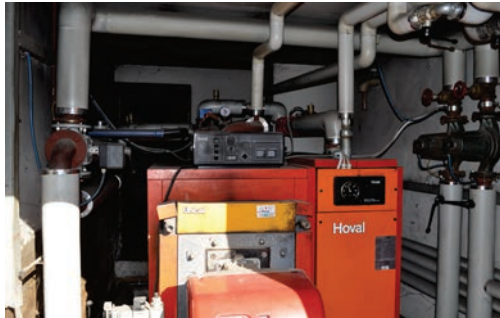
Heizraum mit 345 kW-Standkessel vorne (vorher)
