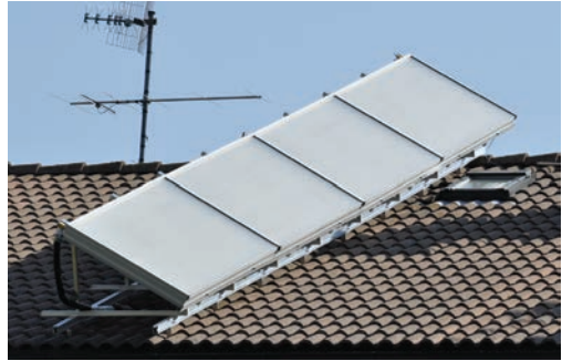
Auch eine Lösung – wenn das Dach um mehr als 45^\circ von Süden abweicht
