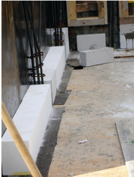
Abb. 21: Bewehrung Stahlbetonhöcker, daneben zwei Lagen Porenbetonsteine [Schöberl & Pöll GmbH]
