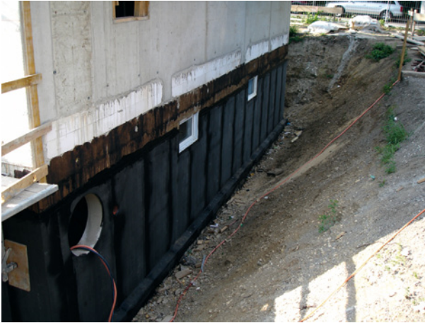
Abb. 23: Oberhalb der Schwarzabdichtung der Tiefgarage sind die Stahlbetonhöcker zwischen den weißen zweilagigen Porenbetonsteinfeldern zu sehen [Schöberl & Pöll GmbH]
