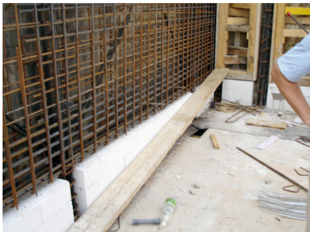
Abb. 22: Oberhalb der Stahlbetonhöcker und des Porenbetons wird die Wand bewehrt [Schöberl & Pöll GmbH]
