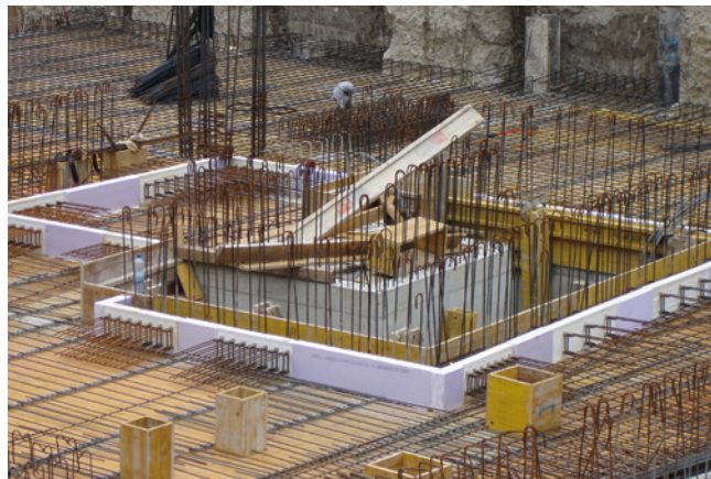
Abb. 29: »Warme Hülle« Treppenhaus Decke über Tiefgeschoss – Foto [Schöberl & Pöll GmbH]
