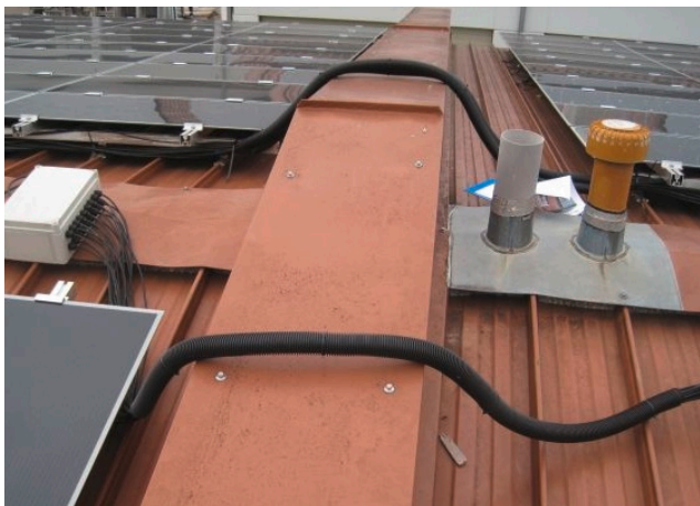
Bild 132: ohne zusätzlichen Schutz überführte Kabelbündel bei einer Brandschutzwand
