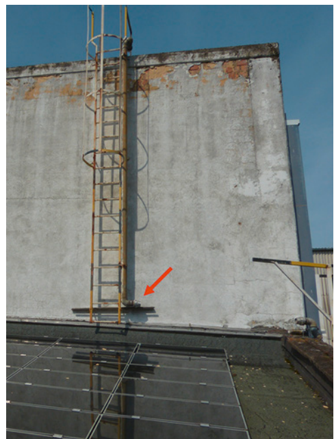
Bild 133: mit Modulen zugebauter Dachzugang mit stationärer Löschwasserzufuhr
