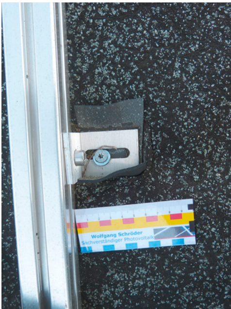
Bild 151: direktes Durchschrauben einer Abdichtungsbahn; der darunter gelegte Elastomerstreifen ist hier nur Kosmetik, das Dach ist undicht
