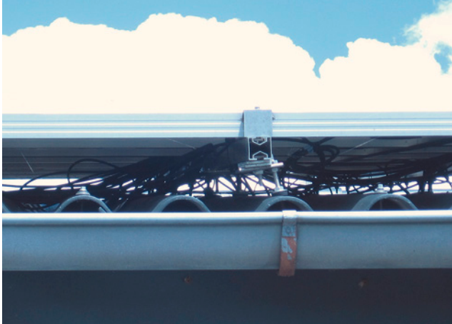
Bild 56: Bei so viel Kabelgewirr kann man sicherlich nicht von einer kurzschluss sicheren Verlegung sprechen.
