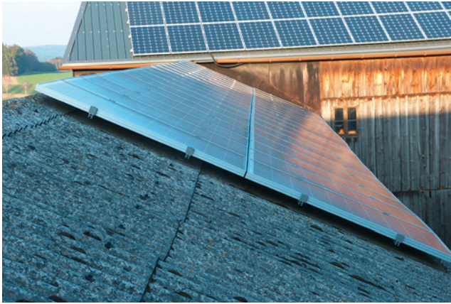
Bild 15: Bereits bei der Errichtung nicht zulässig: überbaute Asbestzementdächer
