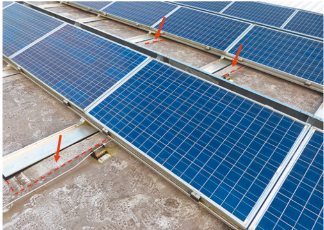
Bild 49: Lageverschiebung von sogenannten Leichtbausystemen
