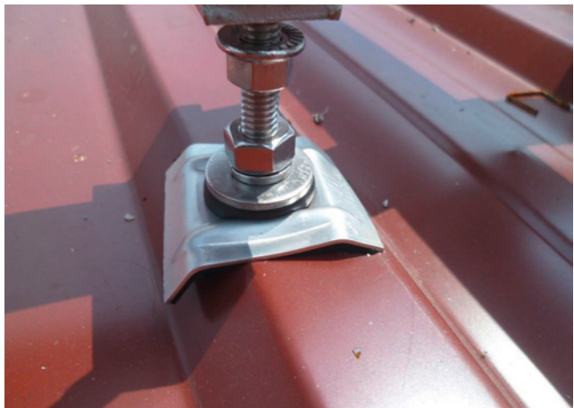
Bild 42: verschobene und deformierte Befestigungskalotte
