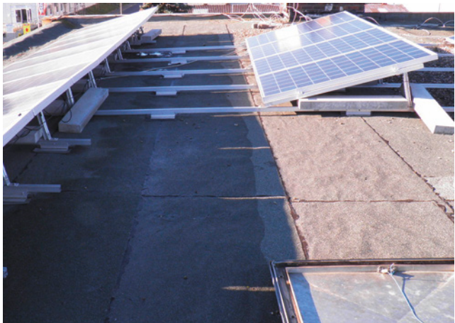
Bild 46: unterschiedliche Beschwerungsanordnungen ohne feste und dauerhafte Auflagerung
