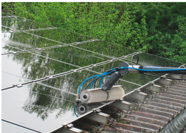
Bild 176: professionelle Reinigung mit aufbereitetem Wasser
