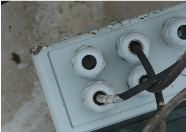
Bild 82: nicht verschlossene oder nicht zum Kabelquerschnitt passende Leitungsöffnungen
