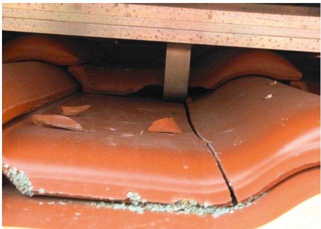
Bild 34: Aufliegende Dachhaken begünstigen Ziegelbruch.
