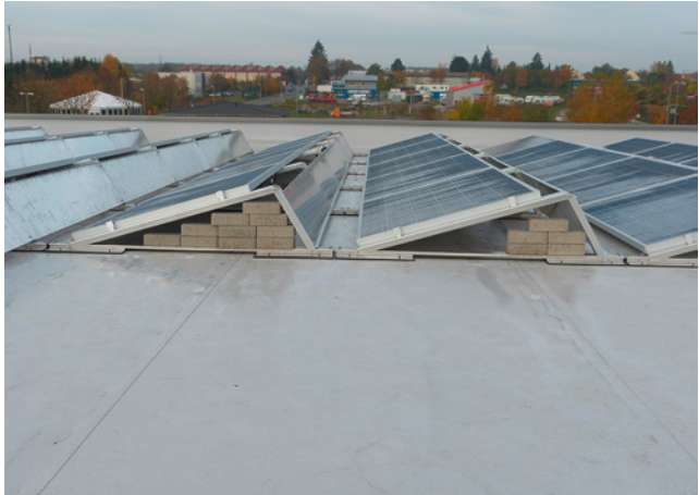
Bild 45: nicht standsicher aufgeschichtete Pflastersteine in unterschiedlicher Anzahl
