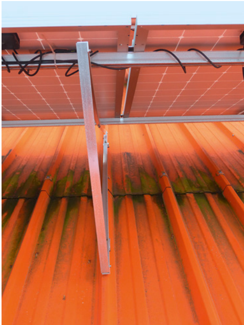
Bild 29: verbogene Ständerkonstruktion, zu schwache Querschnitte
