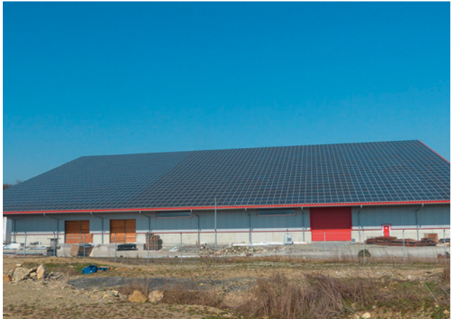
Bild 17: volle Dachflächenausnutzung – Wartungsgänge?
