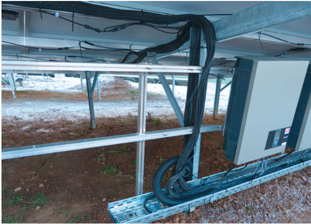
Bild 64: Nicht ausreichend befestigte Kabelbündelungen und ungeschützt über Metallkanten geführte Leitungen verkürzen deren Dauerhaftigkeit.
