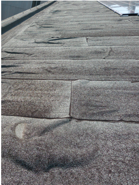
Bild 145: kritischer Zustand einer Flachdachabdichtung – zumindest in diesem Zustand nicht für den Bau einer Photovoltaikanlage geeignet
