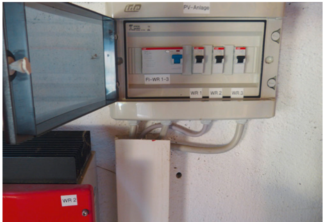
Bild 139: einfache aber übersichtliche Anlagenkennzeichnung
