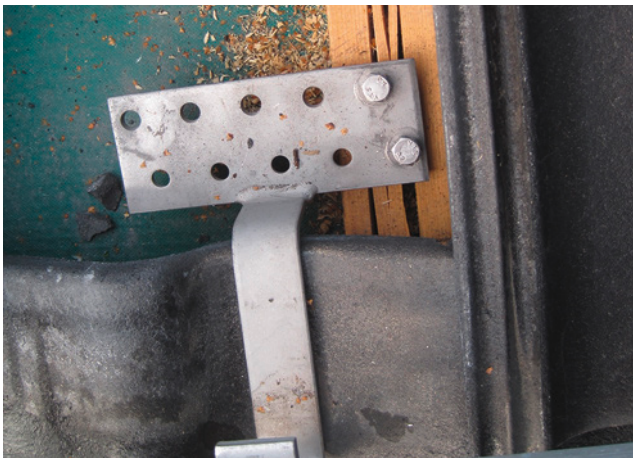
Bild 36: fachtechnisch nicht diskussionswürdige Dachhakenbefestigung
