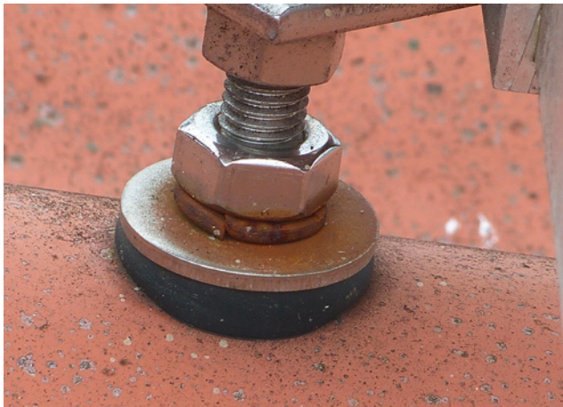
Bild 25: Fehlerhafte Materialauswahl (auch ungewollt) – hier korrodierte blanker Sprengling – beeinflusst die Dauerhaftigkeit des gesamten Bauteiles der Befestigung (Stockschraube).
