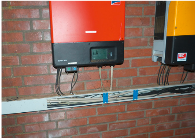
Bild 121: vermischte Leitungsverlegung (DC-AC-Datenleitung)
