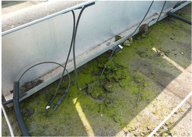
Bild 62: Leitungen und Stecker in einem bereits vermoosten Stauwasserbereich auf einem Flachdach
