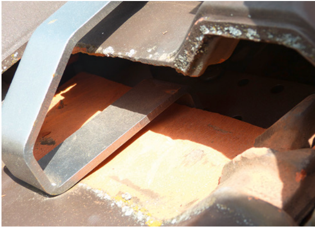
Bild 35: Komplett ausgeschliffene Kopfverfaltung am Ziegel begünstigt den Eintrieb von Niederschlag.
