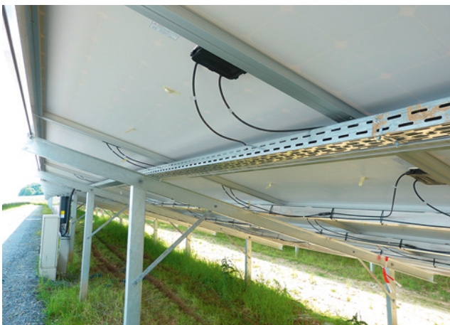
Bild 66: gutes Beispiel einer fachgerechten Leitungsverlegung bei Leitungs-bündelungen und deren Schutz
