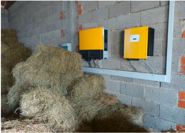
Bild 130: oftmals anzutreffen: problematische Wechselrichter-montagen in landwirtschaftlichen Gebäuden
