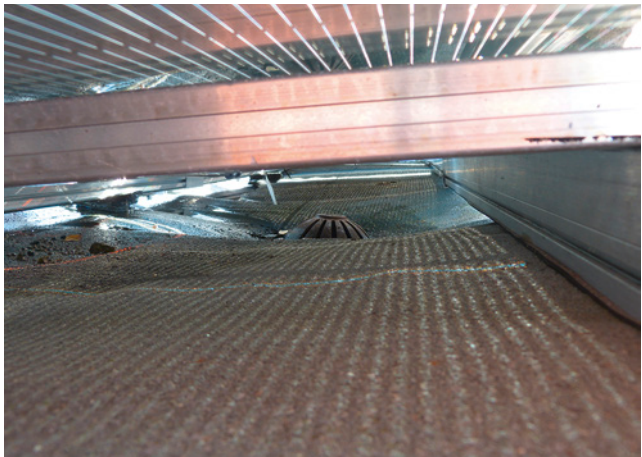
Bild 147: überbaute Dachabläufe – keine Chance auf Wartung
