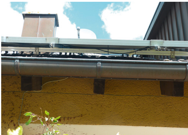
Bild 32: Situation vor Ort mit lastfreiem Dachsparren, ohne über alle Sparren verteilt angeordnete Befestigungspunkte
