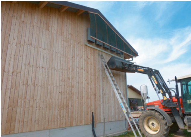
Bild 116: Zugang zu den Wechselrichtern erheblich eingeschränkt
