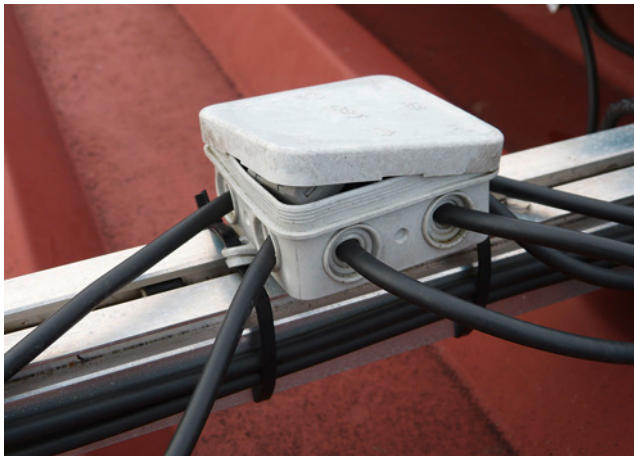
Bild 85: nicht geeignete Ausführung eines Generatoranschlusskastens mit nicht fest schließendem Deckel
