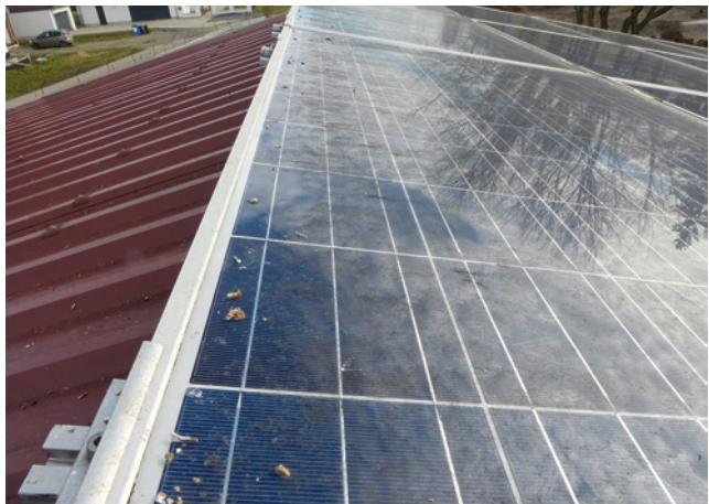
Bild 172: Über den First ragende Module laden Vögel zum Verweilen ein – mit Folgen.
