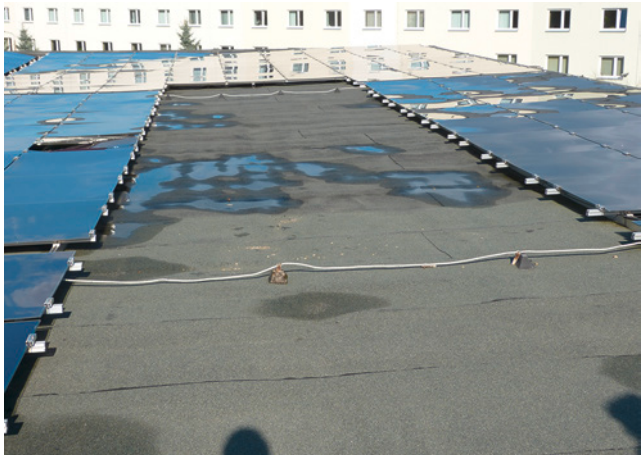
Bild 126: oftmals anzutreffen: überbauter äußerer Blitzschutz
