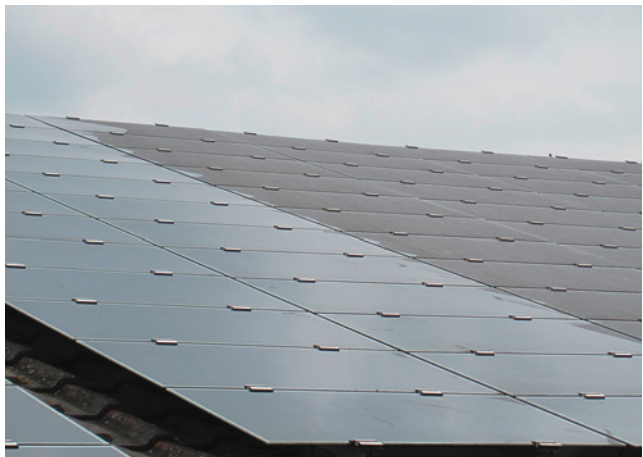
Bild 174: rd. 10 % Ertragsverbesserung nach erfolgter Reinigung bei dieser Beispielanlage
