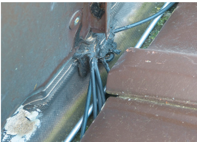
Bild 78: mangelhafte Kabeleinführung an einer Kaminverkleidung im Kehlbereich – Leitungsbeschädigungen und Wassereindrang sind vorprogrammiert
