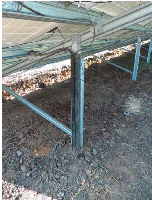
Bild 67: nur mit Kunststoffrohren geschützte Kabelabgänge bei Freifeldanlagen – insbesondere eine Gefahr bei Mäharbeiten
