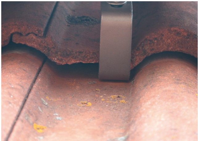
Bild 38: Falsche Dachhakenhöhe beeinträchtigt Regensicherheit.
