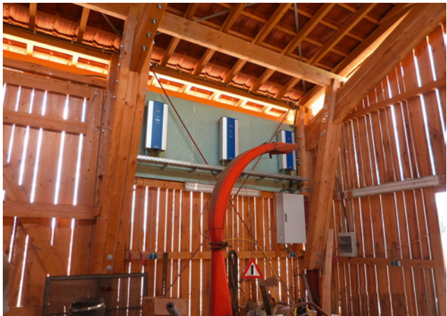
Bild 118: immer wieder problematisch: Wechselrichter in landwirtschaftlichen Gebäuden
