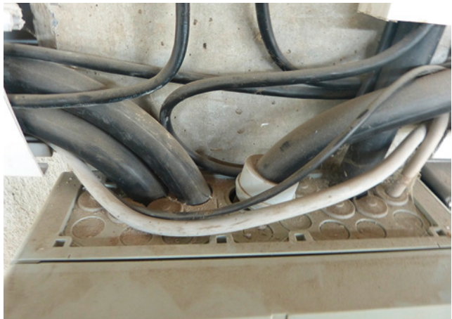
Bild 122: unsachgemäße Kabeleinführungen heben die Schutzklasse des Verteilergehäuses auf
