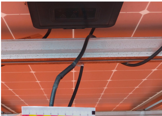
Bild 74: »geflickte« Leitung nach entferntem Modulstecker
