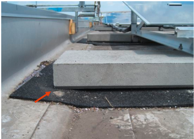
Bild 146: Punktueller Auflager im Abdichtungsrandbereich führt früher oder später zu Schäden.
