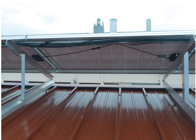
Bild 70: quer verstringte Module mit von der Anschlussdose gegenläufiger und auf Zug befestigter Kabelführung
