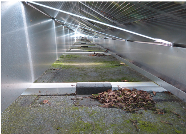
Bild 48: nicht zulässige Klebeverbindungen auf Bitumenbahn
