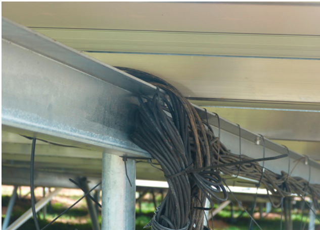
Bild 65: keine dauerhafte Leitungsbefestigung – ein Abreißen ist vorprogrammiert
