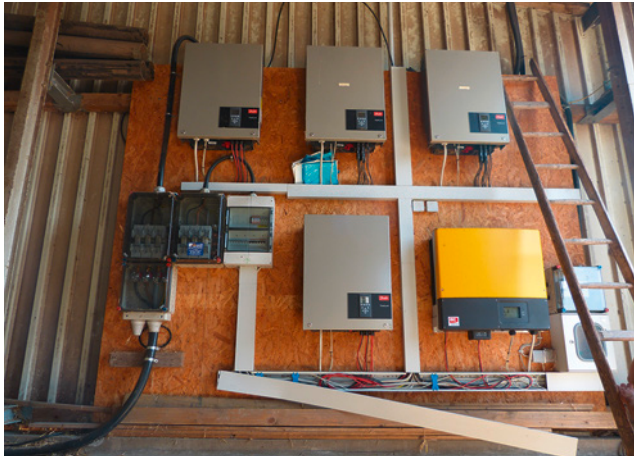
Bild 119: in Scheune mit Strohlagerung montierte Wechselrichter, dazu auf Holzplatte
