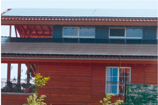
Bild 21: Teilverschattung in Verbindung mit falscher Stringverschaltung – bei diesem Beispiel senkrechte Verschattung – führen zu einem Schattendasein
