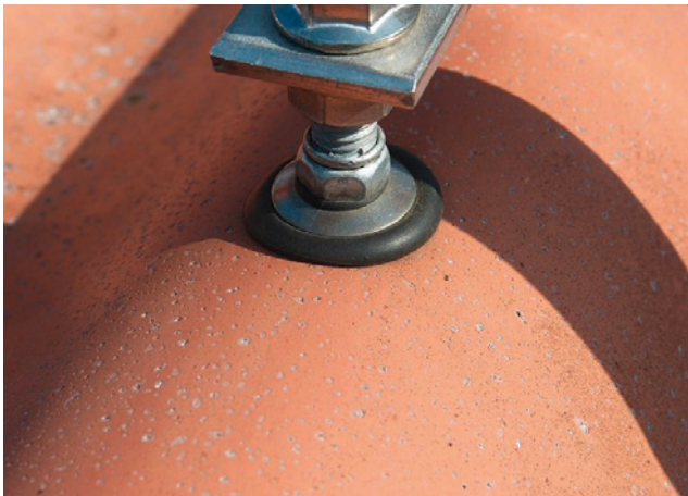
Bild 44: ... und zu fest angezogene Stockschraube mit Überbeanspruchung der Dichtung und Oberwelle der Dacheindeckung
