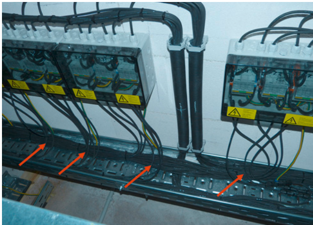
Bild 129: Vermischte Verlegung von Leitungen vor dem Überspannungsschutz (»schmutzige Leitungen«) und nach dem Überspannungsschutz (»saubere Leitungen«) können die Schutzwirkung durch Spannungseinkopplung wieder aufheben.
