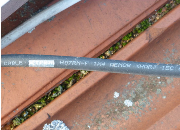
Bild 81: problematisch: Gummischlauchleitungen auf Dachflächen
