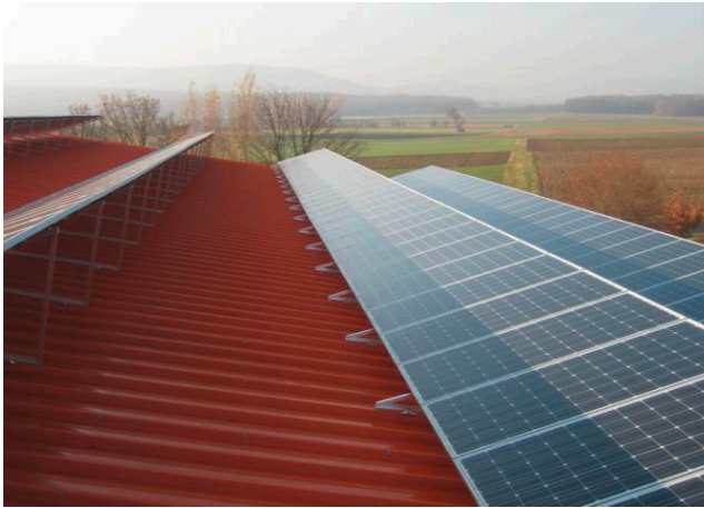
Bild 23: Zu geringer Reihenabstand und Hochkantmontage der Module bewirken Vollverschattung der Module.
