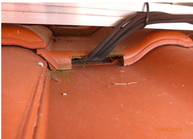
Bild 75: typische nicht fachgerechte Kabeleinführung bei Dachziegeln; Leitungen liegen an scharfen Ziegelkanten
