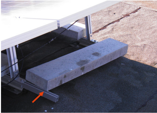
Bild 47: Balance-Akt – Lagesicherheit der Beschwerung unzureichend
