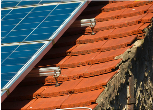
Bild 39: Stockschraubenbefestigung bei Dachziegel geht selten gut
