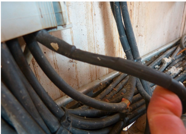
Bild 73: nicht statthafte Leitungsverlängerungen und Isolierung mittels Schrumpfschlauch
