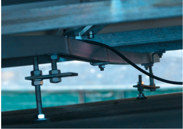
Bild 27: deformierte Tragschiene infolge zu weiter Befestigungsabstände
