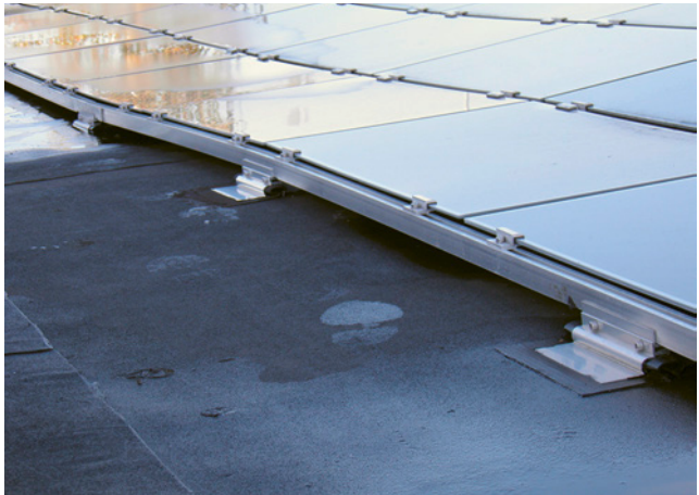
Bild 148: immer kritisch: punktuelle Auflager auf Bitumenbahnen
