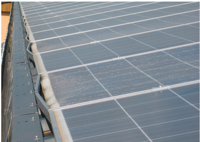
Bild 92: Schneedruckschaden
