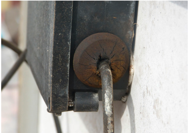
Bild 112: rissige, verwitterte Dichtungen bei den Kabeinführungen
