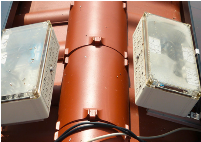
Bild 83: Kondenswasserbildung in Generatoranschlusskasten bei gleichzeitigen ungeschützten, exponierten Montageort
