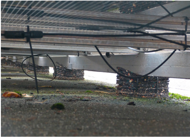
Bild 150: »Self-made«-Auflagerung führt zu nicht zulässiger punktueller Belastung der Abdichtung.
