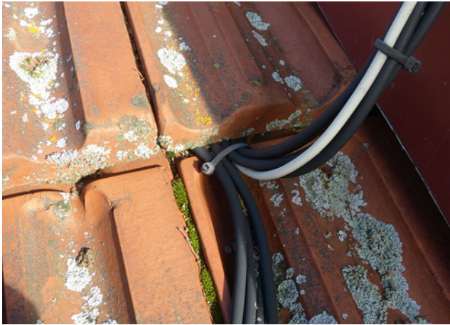
Bild 76: durch Ziegel gequetschte Leitungen
