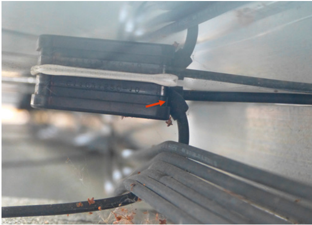
Bild 72: Falsche Leitungsführungen verursachen Kabelzug an Modulanschlussdose.
