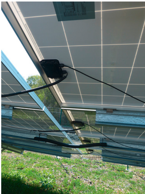
Bild 152: ein nicht seltener Anblick bei Freifeldanlagen: hängende Leitungen mit Überbeanspruchung im Bereich der Modulanschlussdose
