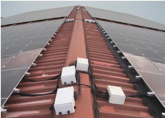
Bild 61: ungeschützte, auf Dachhaut aufliegende Leitungen entsprechen nicht einer kurzschluss-sicheren Verlegung
