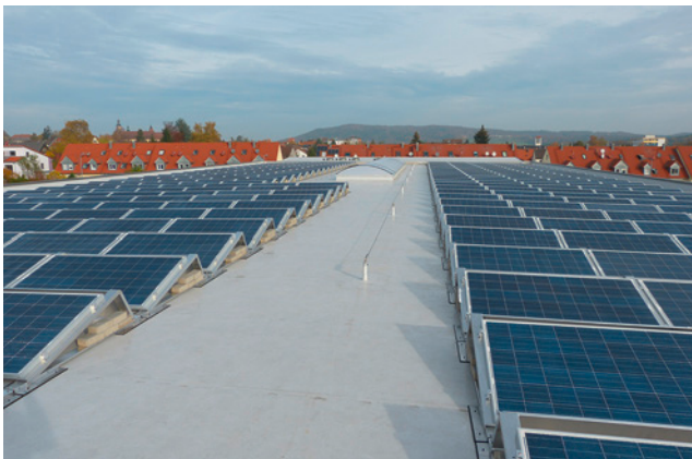
Bild 16: Seltener Anblick: Flachdach mit Sicherungseinrichtung
