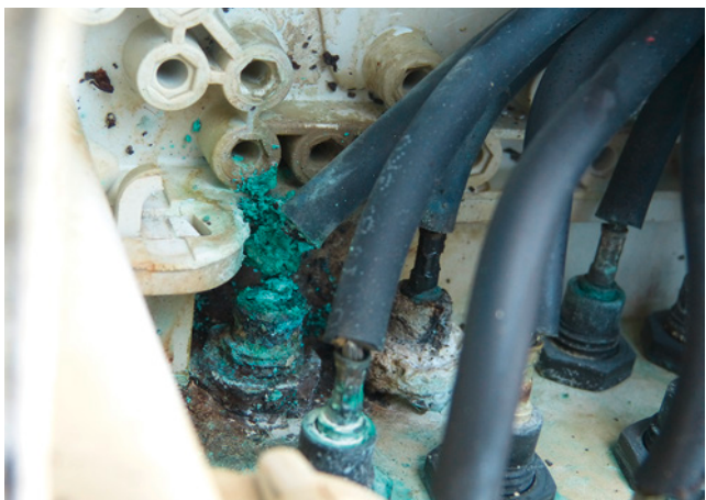
Bild 84: korrodierte Leitungsanschlüsse (Grünspanbildung) in einem Generatorverteilergehäuse mit Abschmoren einer Leitung als Folge von angesammeltem Kondenswasser
