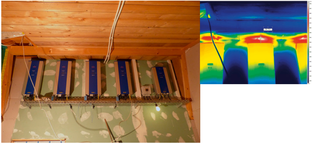
Bild 117: zu geringer Abstand zur oberen Begrenzung, dadurch erheblicher Wärmestau – in Verbindung mit Holzdecke in brandschutztechnischer Hinsicht problematisch
