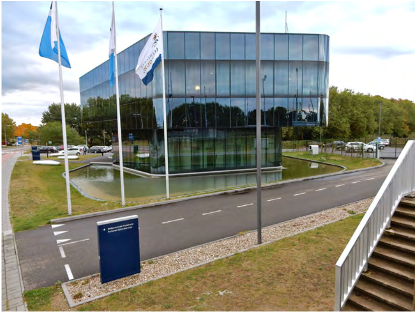
Abb. 1: Außenansicht Leitstelle Maasbracht (Foto 2016)
