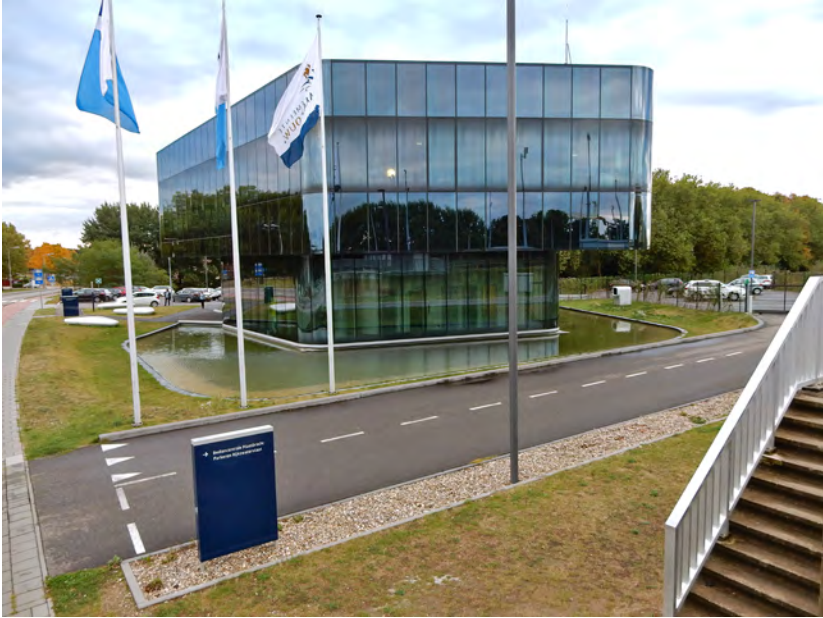
Abb. 1: Außenansicht Leitstelle Maasbracht (Foto 2016)
