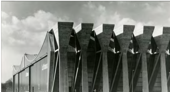
Abb. 4: Lufthansa-Wartungshalle V in Frankfurt am Main, 1972
