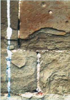
Rückwitterung durch Schalenverlust
