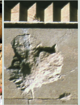
Ausbruch durch mechanische Einwirkung
