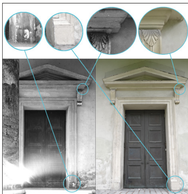
Bild 57: Portal an Nordfassade der Glyptothek, links bauzeitlich (Aufnahme: Poss um 1940. Quelle: Hausarchiv Glyptothek), rechts in heutigem Zustand (Aufnahme: Pfanner 2017), wie es nach dem Krieg neu erstellt wurde. Änderungen sind eingekreist.
