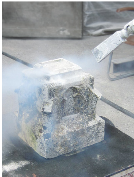
Bild 97: Reinigung mit Trockeneis (Aufnahme: Pfanner)
