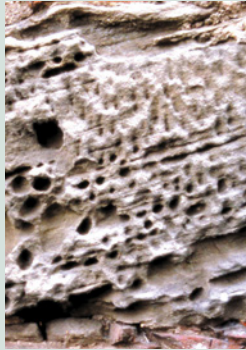
Relief durch Absanden (Alveolar- verwitterung)
