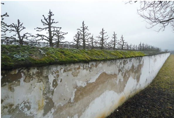
Bild 65: Umfassungsmauer Schloss Seehof mit Steinabdeckung, sogenannte Bischofsmütze. Die durch Ablaufwasser und Grundfeuchte verursachten Schäden überlappen sich in der Mitte der Mauer.
