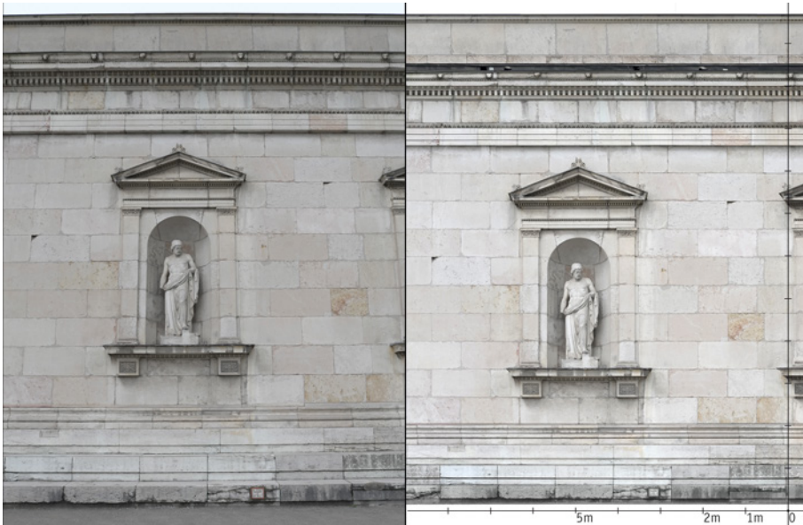
Bild 79: Glyptothek München, S-Fassade. Links: Aufnahme mit normaler Kamera. Rechts: Gleicher Bereich als maßstäblicher Ansichtsplan aus mehreren entzerrten Fotos zusammengesetzt (Aufnahmen und Entzerrung: F. Winkler 2017).
