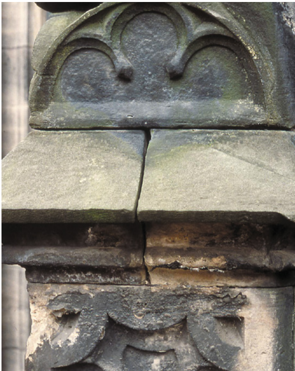
Bild 118: Feucht- und Trockenkruste auf Sandstein an der Kirche Sankt Moriz in Coburg
