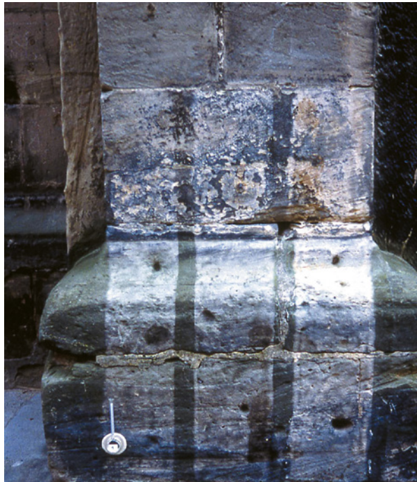
Bild 119: Musterflächen mit Mikropartikelstrahlreinigung an der Kirche Sankt Moriz in Coburg
