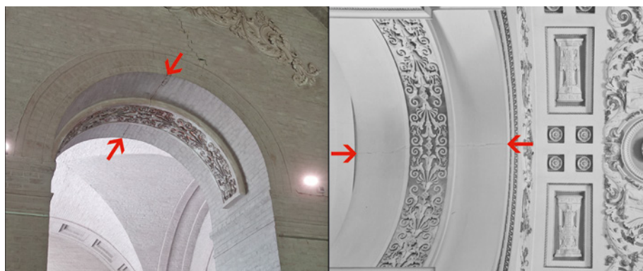
Bild 58: Innenraum der Glyptothek mit Ziegelgewölbe, links mit Riss im Scheitel auf einer aktuellen Aufnahme (Aufnahme: Pfanner 2017). Rechts derselbe Rissverlauf im Vorkriegszustand (Aufnahme: Poss um 1940. Quelle: Hausarchiv Glyptothek).
