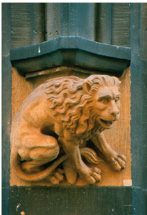
Bild 120: Musterfläche einer Laserreinigung am Neuen Rathaus in München. Die Oberfläche ist noch von den Resten der schwarzen Kruste überzogen und erscheint deshalb in gelbliche Farbe.
