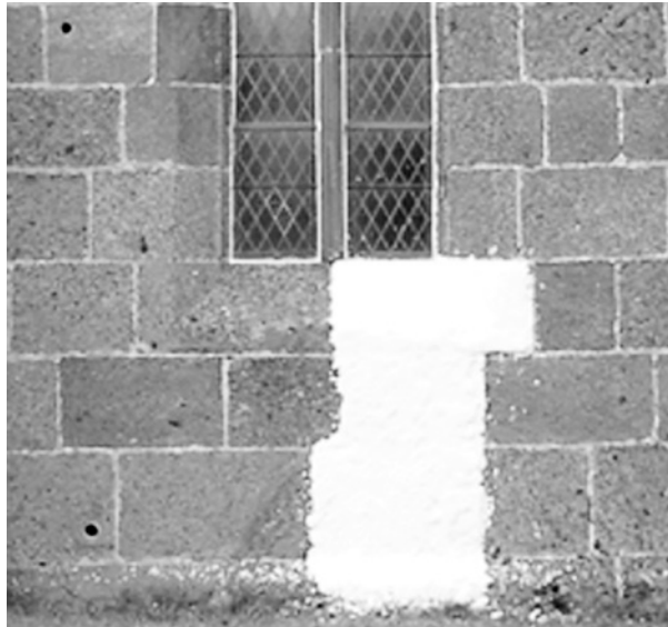
Bild 123: Flächenhafter Kompressenauftrag auf Mauerwerk (Aufnahme: Belk)
