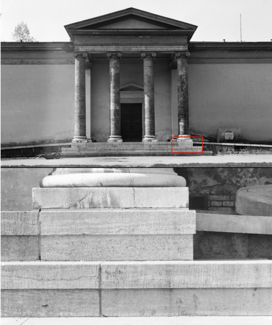
Bild 59: Sitzstufen (Krepis) an Nord-/Rückseite der Glyptothek. Zustand um 1940 mit auffallend hellen Stufen (Aufnahmen: Poss um 1940. Quelle: Hausarchiv Glyptothek).
