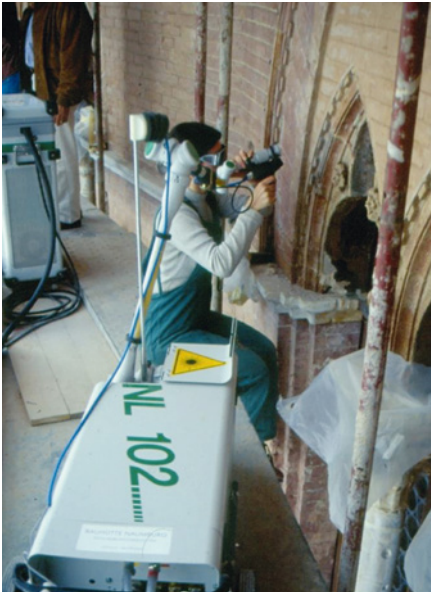
Bild 41: Equipment aus Generator und Kühlaggregat (im Hintergrund) für einen NdYAG Laser
