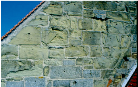
Kloster Birkenfeld – Kirche Westgiebel Steinergänzung mit KSE-Mörtel Perfekt angepasst und nicht sichtbar
