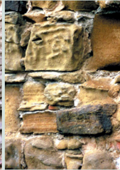
Relief durch Absanden
