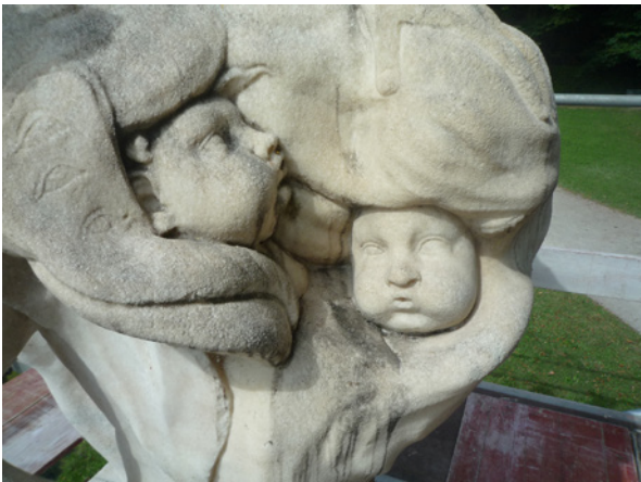
Bild 9: Stark aufgeraute Oberflächen an der Parkfigur Äolus im Schlosspark Nymphenburg München
