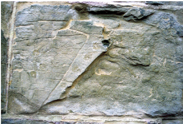
Bild 131: Antragung von Kiesel-sol-gebundener Steinersatzmasse am Westgiebel von Kloster Birkenfeld
