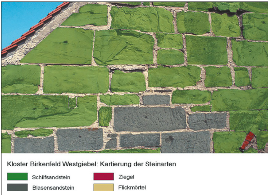
Bild 67: Kartierung der Naturwerksteine am Westgiebel (Ausschnitt) der Klosterkirche Birkenfeld [SNETHLAGE et al. (1996); HERTLEIN (1991)]
