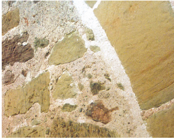
Bild 125: Anpassung von Original- und Fugenmörtel an der Südfassade von Kloster Birkenfeld
