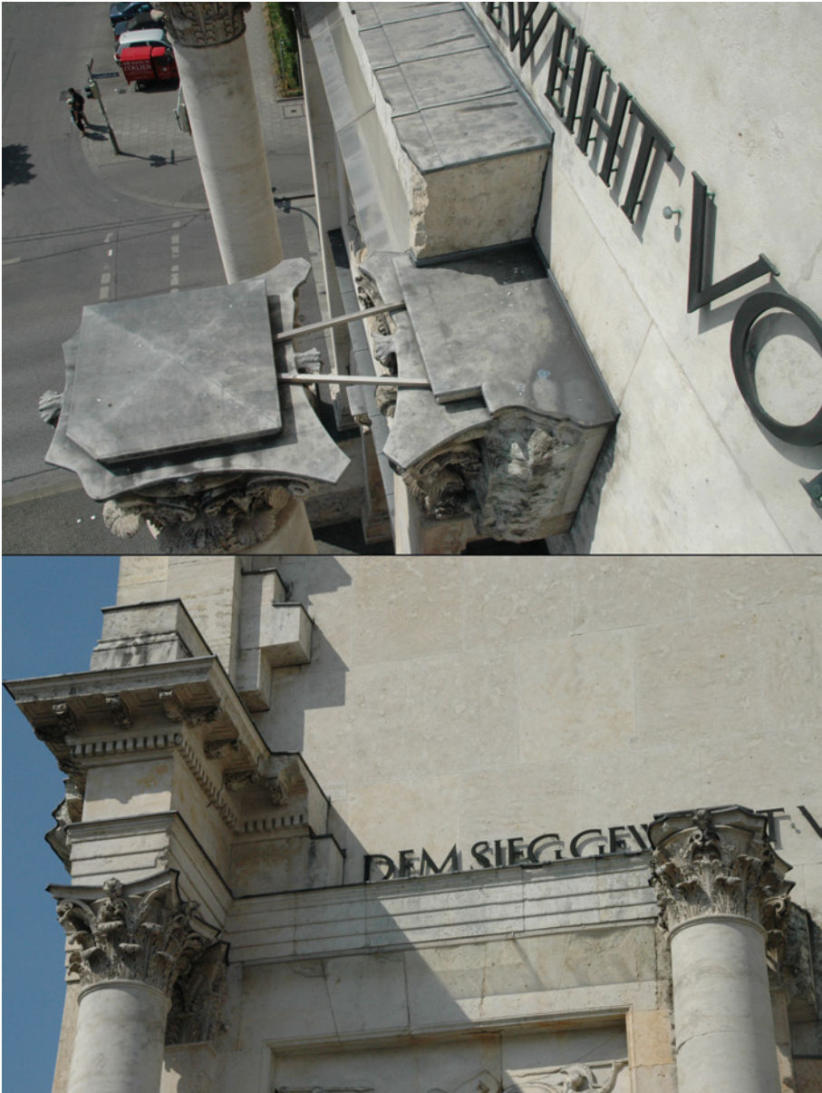
Bild 133: Bleiverblechung am Münchener Siegestor von oben und vom Boden aus betrachtet (Aufnahmen: Pfanner).
