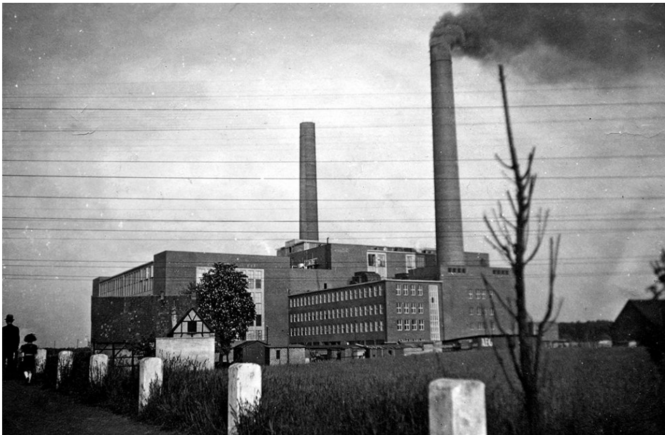
Abb. 27: Das Steag-Kraftwerk Lünen, 1940 234
