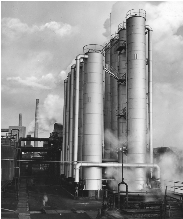
Abb. 14: Benzolwaschtürme der Kokerei Nordstern, 1955 179
