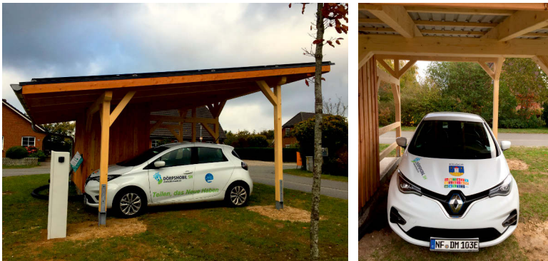
Abbildung 1-2: Mobilitätsstation im zweitwagenfreien Baugebiet mit Dach-PV und 2*22 KW-Ladesäule und: »DörpsMobil« als SDG-Botschafter
