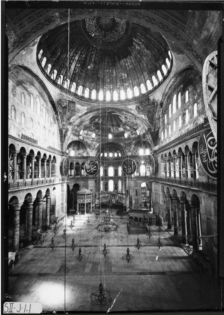
Abb. 2: Hagia Sophia, 532–537 und 562, Innenansicht (The Byzantine Institute and Dumbarton Oaks Fieldwork Records and Papers, ca. 1920–2000, MS.BZ.004. Fotografie mit freundlicher Genehmigung von Image Collections and Fieldwork Archives, Dumbarton Oaks, Trustees for Harvard University, Washington, D.C.)
