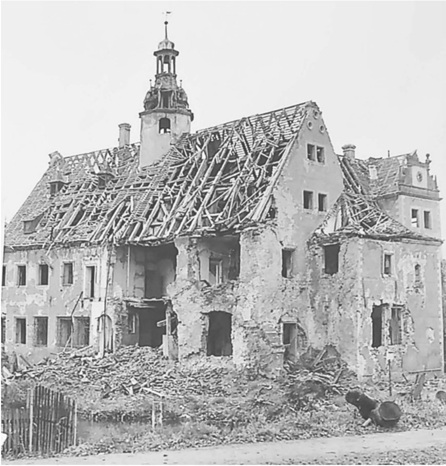
Abb. 1: Schloss Dölitz nach der Beschädigung, Foto: 1944.
