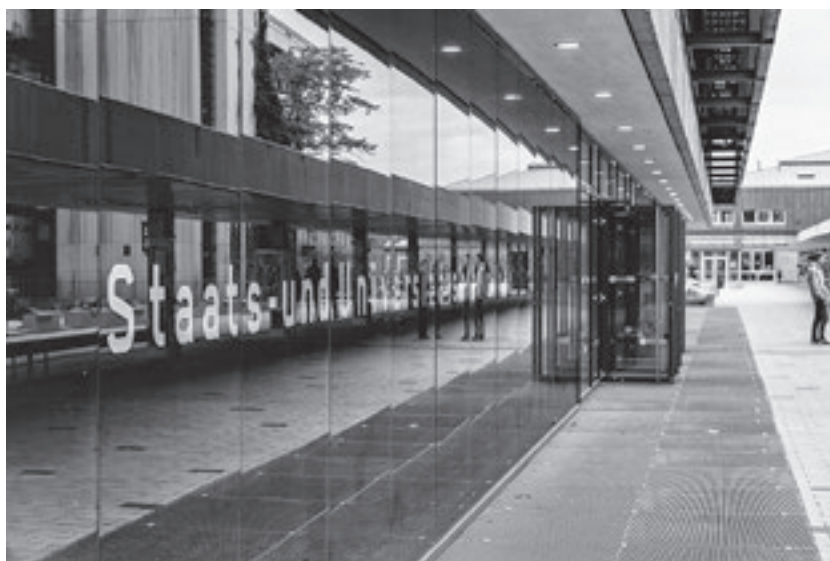
Abb. 1: Staats- und Universitätsbibliothek Bremen, Standort Zentrale auf dem Universitätscampus
