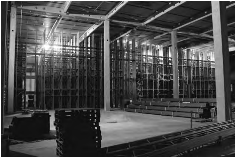
Bild 4: Baufortschritt in Dorsten/Marl - Regalaufbau
