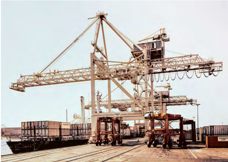
Abb. 4: Burchardkai, Hamburg-Waltershof, Containerbrücke mit Van Carriern, Foto 1970.
