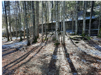
Abbildung 11: Das Berghofgelände mit Blick auf die Hangstützmauer.
