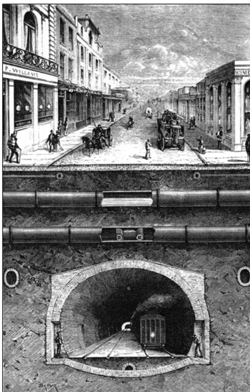
Abb. 5: Querschnitt durch die Infrastruktur einer Londoner Straße, um 1875
