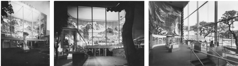
Abb. 4–6: Eingangsbereich Österreich Pavillon mit Skulptur und Seilbahnstütze sowie seitliche Ansicht mit Wiener Kaffeehaus, © Fotos: Julius Scherb/Wien Museum.
