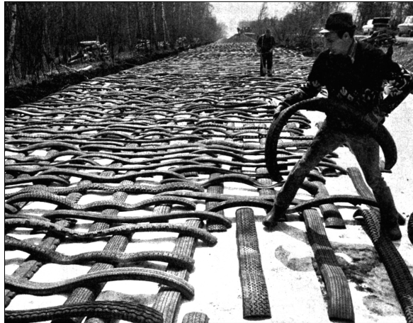
Abb. 3: Eine Form der Altreifenweiterverwendung: Als Unterlage für den Bau einer Landstraße in Oberbayern 1977. Quelle: ADAC-Motorwelt 1977, H. 9, S 10.
