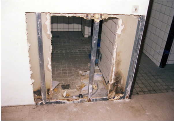
Bild 53 ■ Bauteil- öffnung der Wand zwischen Duschaum und Umkleiraum
