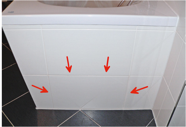
Bild 6 ■ Revisionsöffnung mit Dichtstofffuge bei einer Wanne
