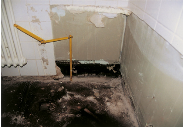
Bild 95 ■ Bereich der ausgebauten Badewanne mit Bodenabdichtung
