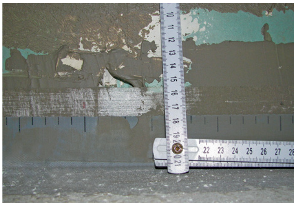
Bild 18 ■ Mangelhaft eingebautes Dichtband – bei Fortführung der Arbeiten kann eine ausreichende Einbettung partiell nicht mehr erzielt werden.
