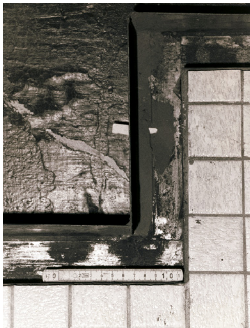
Bild 102 ■ Die Rinnenaufkantung ist lediglich punktgeschweißt, sodass ein Papierstreifen hindurch geschoben werden konnte.
