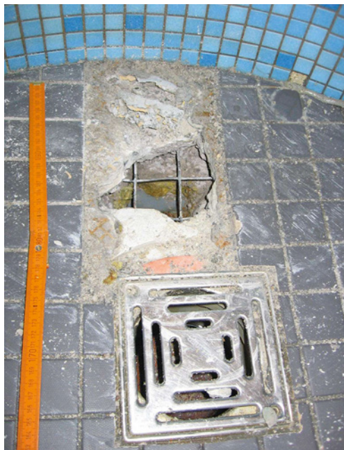
Bild 89 ■ Bodenkonstruktion im Bereich des Ablaufs
