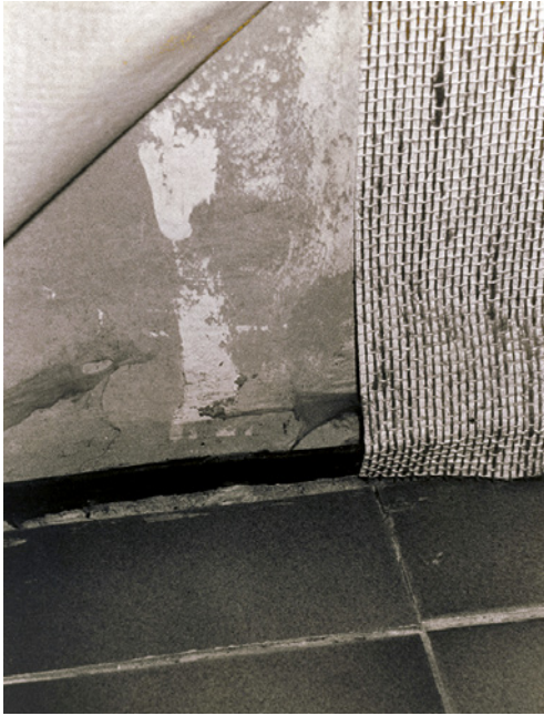
Bild 64 ■ Unzureichende Abdichtungsaufkantung im Wandbereich
