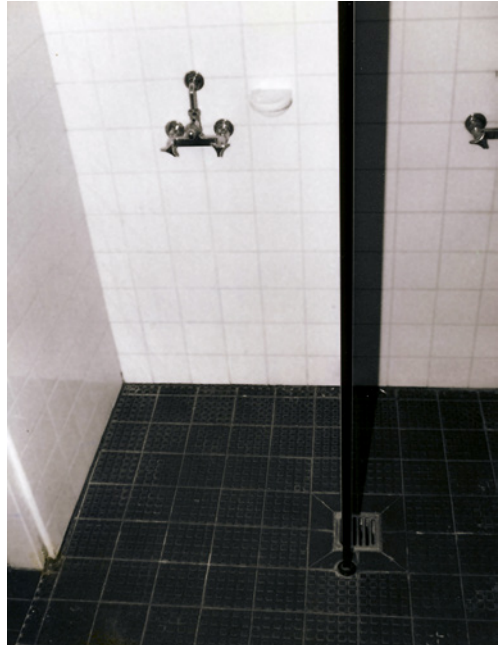
Bild 72 ■ Die Duschen, die direkt an die Trennwand zum Vorraum grenzen und nahe der Tür liegen, weisen keine Maßnahmen zur räumlichen Begrenzung der Wassereinwirkung auf.
