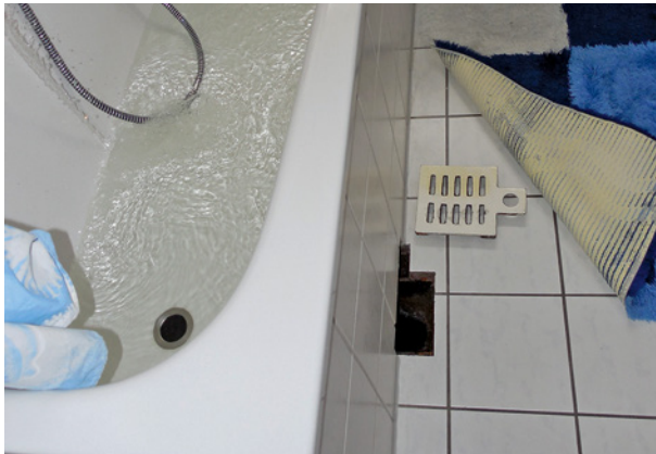
Bild 83 ■ Badewanne mit davor befindlichem Bodenablauf, in den die Wanne entwässerte
