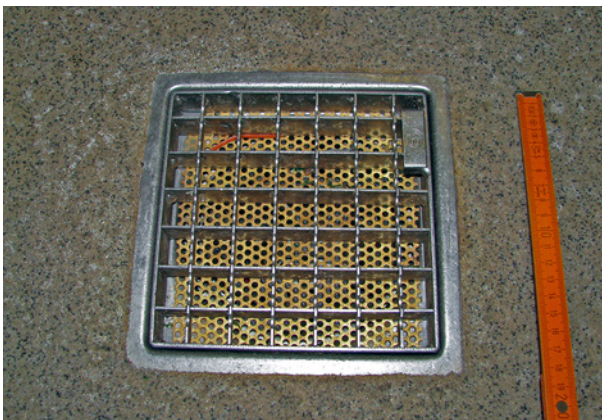
Bild 98 ■ Anschluss der Beschichtung an einen Bodenablauf
