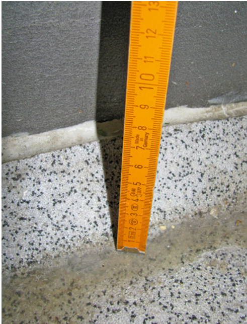
Bild 97 ■ Abschluss der Beschichtung bei einer Wand mit Hohlkehle und Dichtstofffuge
