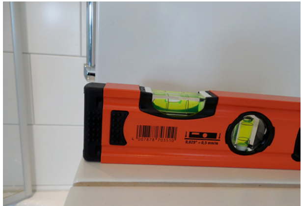
Bild 9 ■ Gegengefälle bei einer Ablage im Bereich einer Badewanne mit Duschabtrennung
