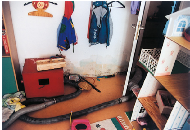
Bild 94 ■ Wasserschaden an der Wand zwischen Kinderzimmer und Bad
