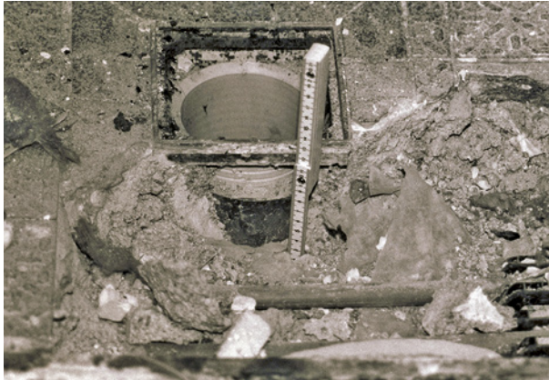
Bild 65 ■ Der Ablauf ist im Bereich der Entwässerungsebene der Abdichtungsbahnen durch Mörtelreste vollständig verstopft.
