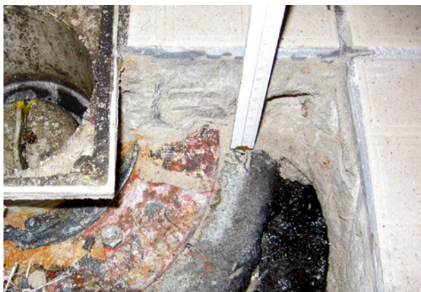
Bild 68 ■ Die Bitumenbahn ist mit einer Aufkantung auf den Ablaufkörper geführt und dort beschädigt.
