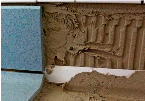
Bild 16 ■ Ausführung eines Aluminiumprofils zum Schutz des Dichtbandes (Quelle: Henrik-Horst Wetzel)
