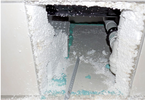
Bild 8 ■ Eine Revision mittels Dichtstofffugen wäre hier leicht möglich gewesen.
