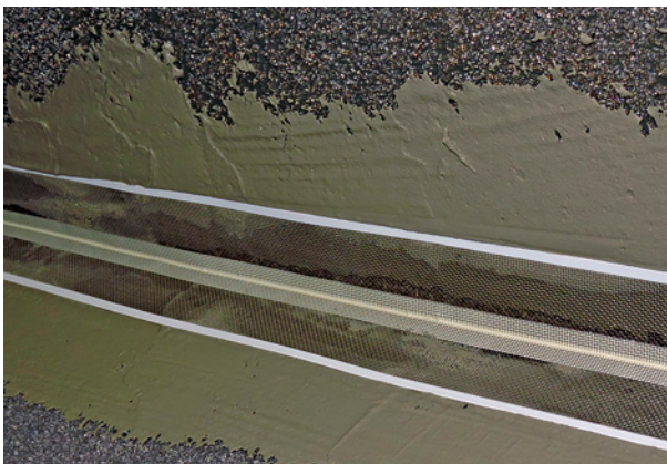
Bild 17 ■ Ausführung eines Schutzstreifens aus Edelstahlgewebe zum Schutz des Dichtbandes (Quelle: Henrik-Horst Wetzel)
