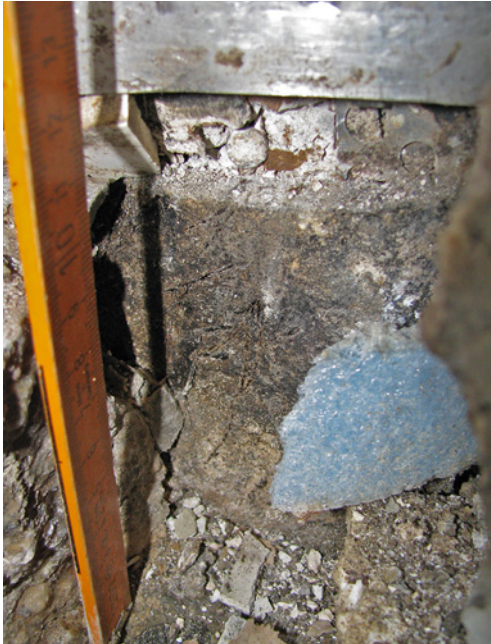
Bild 100 ■ Abschluss der Abdichtung aus Bitumenbahnen bei einer Wand
