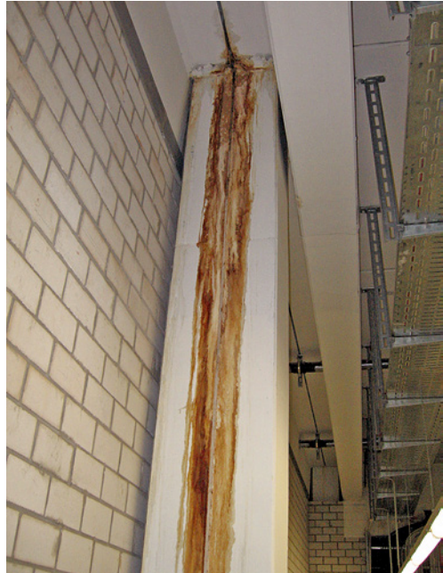
Bild 58 ■ Feuchteschaden im Untergeschoss unterhalb des Produktionsbereichs
