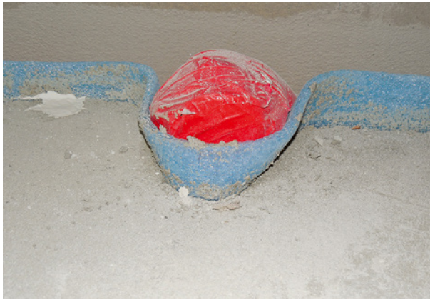
Bild 11 ■ Mangelhafte Höhe der Anschlussleitung ohne Hilfsmittel ersichtlich
