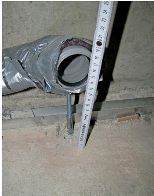
Bild 10 ■ Mangelhafte Höhe der Anschlussleitung in der Ebene der geplanten Fußbodenkonstruktion
