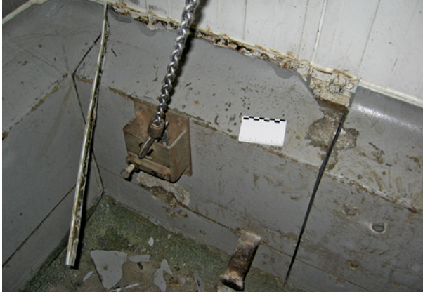
Bild 59 ■ Ramm- schutz vor der leichten Trennwand
