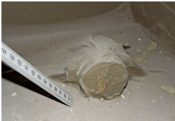
Bild 12 ■ Mangelhafter Abdichtungsanschluss an die Anschlussleitung
