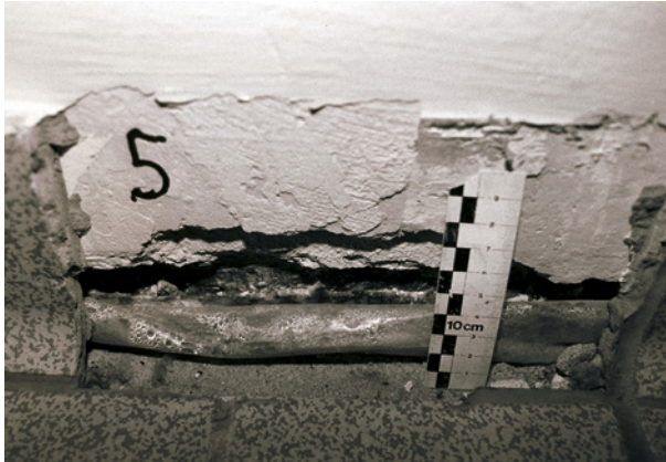
Bild 56 ■ Die Aufkantung der Fußbodenabdichtung an der Wand endet ca. 10 mm oberhalb der Belagsoberkante.
