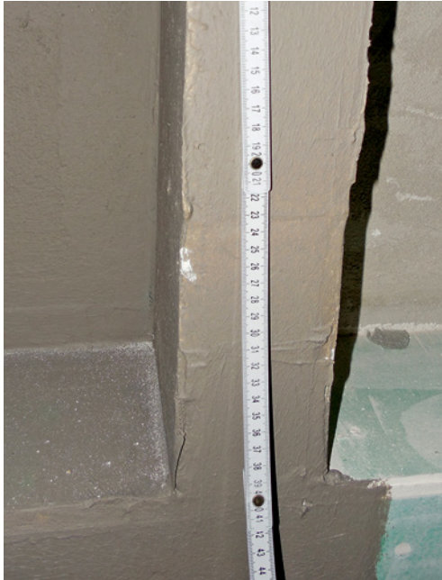
Bild 13 ■ Verbundabdichtung (AIV-F) auf einem mangelhaften Untergrund
