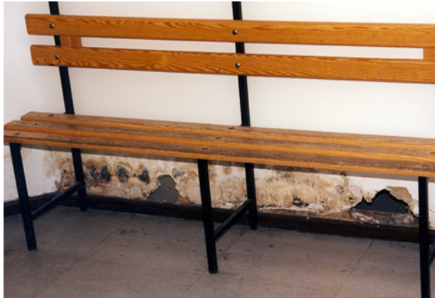
Bild 52 ■ Durchfeuchtungen und Schimmelpilzbildungen im Sockelbereich der an den Duschaum grenzenden Wand
