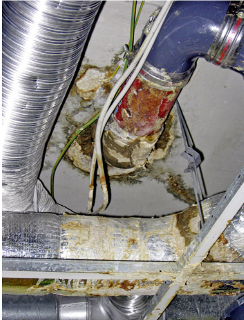
Bild 66 ■ Schadensbild unterhalb eines Ablaufs
