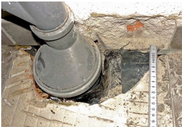
Bild 35 ■ Fehlender Anschluss einer bahnenförmigen Abdichtung an eine Durchdringung (sowie fehlende Wandaufkantung)
