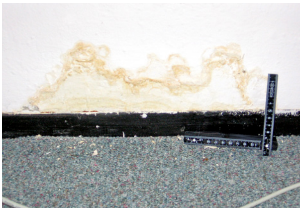
Bild 77 ■ Wasserschaden im Sockelbereich der Wand
