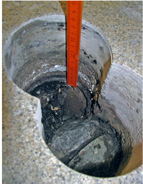
Bild 99 ■ Bodenkonstruktion mit (von oben) Beschichtung, Estrich, Dämmung und Abdichtung aus Bitumenbahnen
