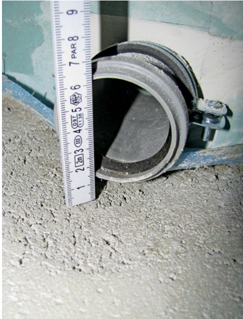
Bild 34 ■ Unzureichender Platz zur Montage einer Manschette bei geplanter Verbundabdichtung AIV-F
