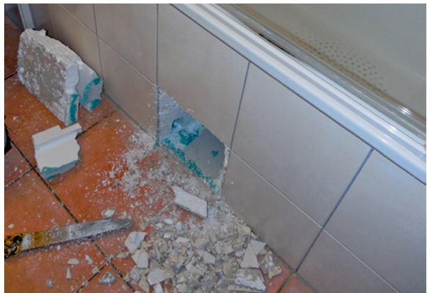
Bild 7 ■ Zerstörende Herstellung eines Zugangs zum Bereich unterhalb der Wanne bei fehlender Revision
