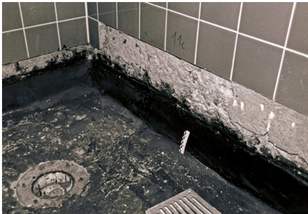
Bild 57 ■ Die Fußbodenabdichtung aus Bitumenbahnen ist ohne Ausrundung an den Wänden hochgeführt worden.
