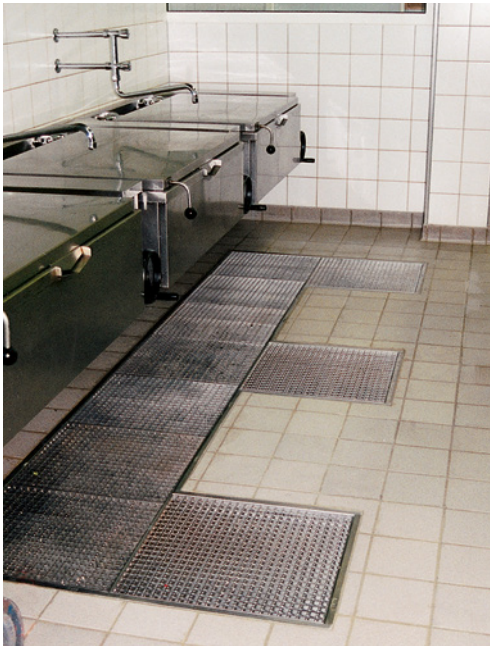
Bild 84 ■ Gesamtansicht einer Ablaufrinne
