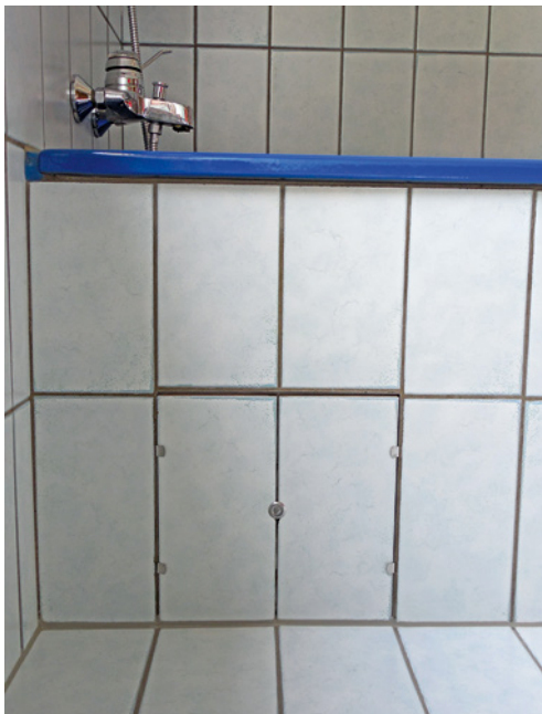
Bild 5 ■ Revisionsöffnung mit Einbaurahmen bei einer Wanne
