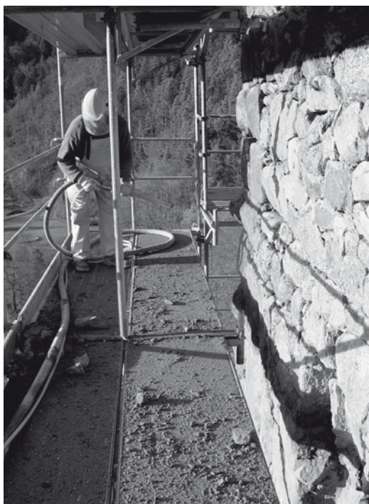
Abb. 9 Maschinelle Neuverfugung
