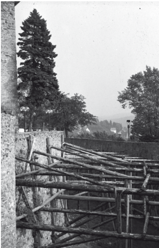
Abb. 2 Temporäre Sicherung (auf lange Zeit)
