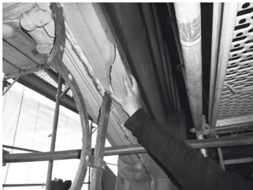
Abb. 25 und 26 Absprengung am Sandstein durch Rost
