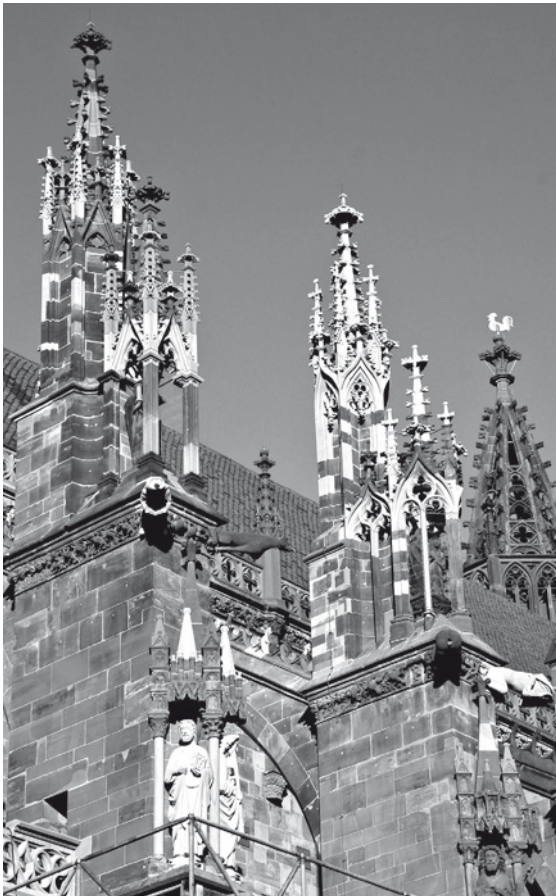
Abb. 4 Sanierter Strebepfeileraufsätze auf der Südseite
