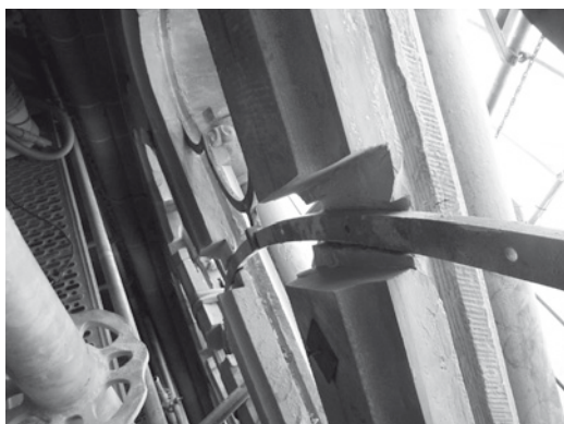
Abb. 27 Zum Ausbau freigelegter Eisenring
