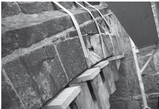
Abb. 15 und 16 Schädigung von Steinen der Strebebögen durch Rosttreiben
