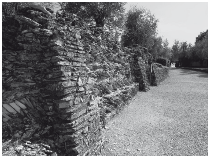
Abb. 3 Lokales Versagen des Mauergefüges
