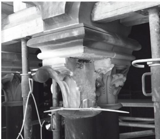
Abb. 3 Korrodierte Eisenklammer im Kapitell
