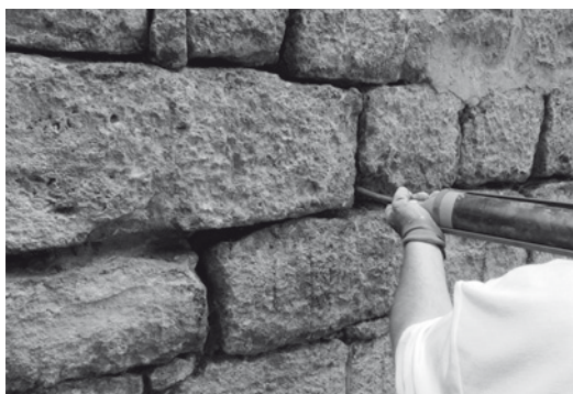
Abb. 5 Verfugung mit Kartusche mit spritzfähigem Fugenmörtel
