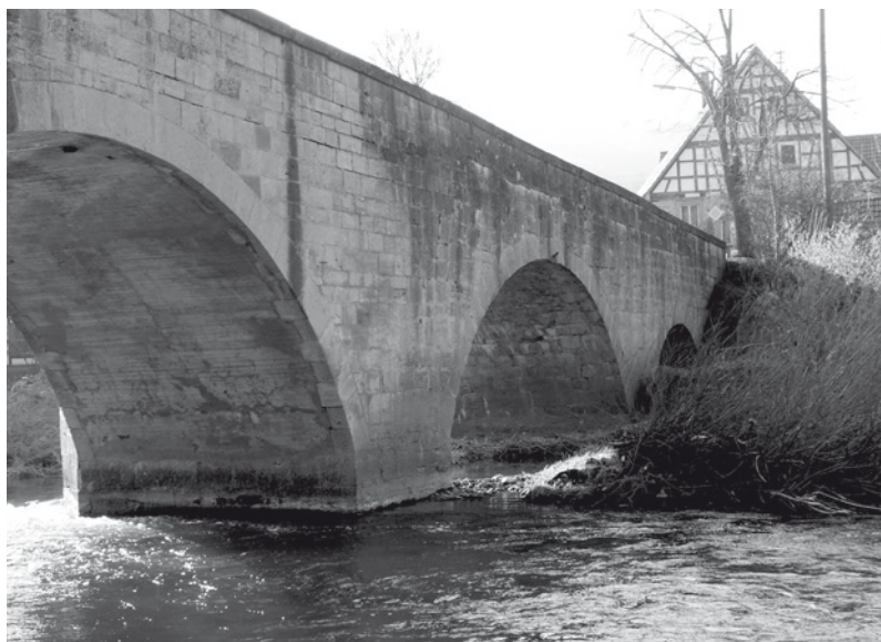
Abb. 4 Straßenbrücke über die Jagst in Mulfingen: Hier wurden alle Bogen- untersichten als Bildplan abgewickelt dargestellt.
