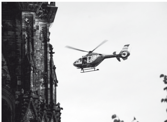
Abb. 10 Für den oberen Teil der 147 Meter hohen Turmspitze wurde ein Helikopter eingesetzt.
