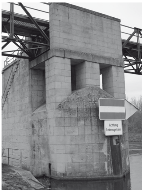
Abb. 7 Beispiel eines mit Naturstein verkleideten Wehrpfeilers
