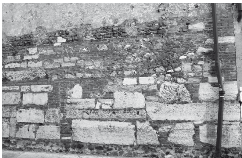
Abb. 1 Mischmauerwerk mit unterschiedlichen Steinformaten und Mörtelanteilen
