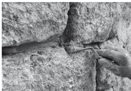
Abb. 6 Handverfugung mit steif plastischem Mörtel
