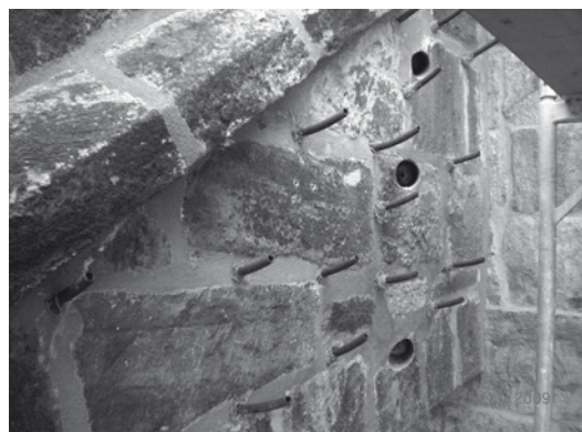
Abb. 18 Eingebaute Anker und eingesetzte Verfüllschläuche
