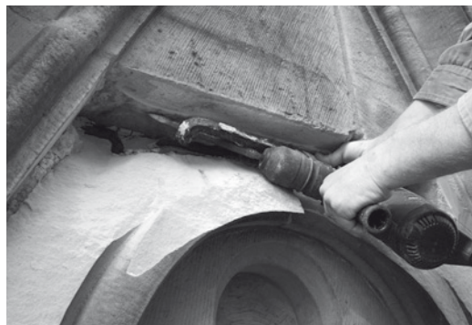
Abb. 8 und 9 Erkennbare Abplatzung im Giebelstein und dahinter liegende korrodierte Klammer
