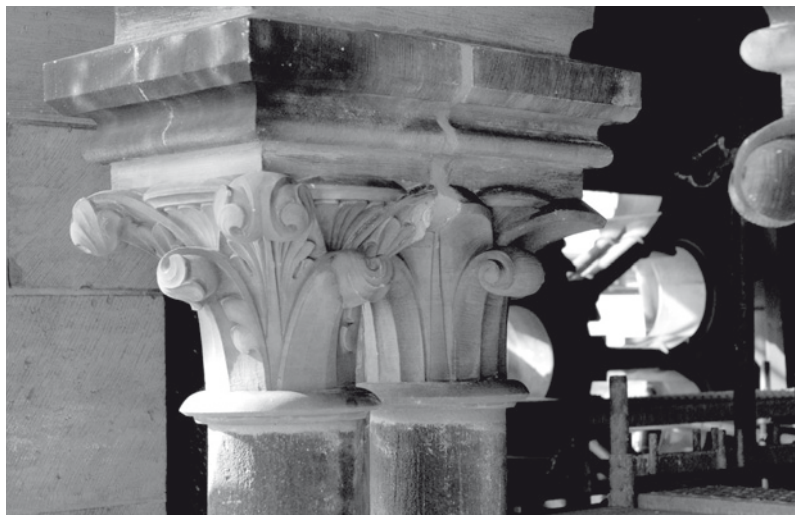
Abb. 10 Bremen Dom – reparierte Architekturteile
