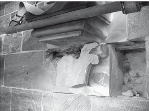
Abb. 10 Beim Bau des Domes wurde fast jeder Stein mit einer Klammer verankert.
