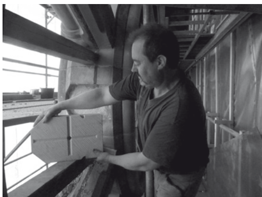
Abb. 30 Vorbereitete Vierung mit Bleivergusskanal
