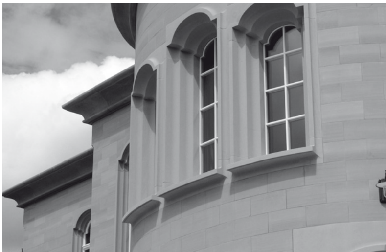
Abb. 2 Quadermauerwerk mit schmalen Fugen
