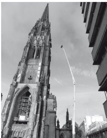
Abb. 9 Einsatz einer 88-m-Arbeitsbühne am Nikolaikirchturm in Hamburg
