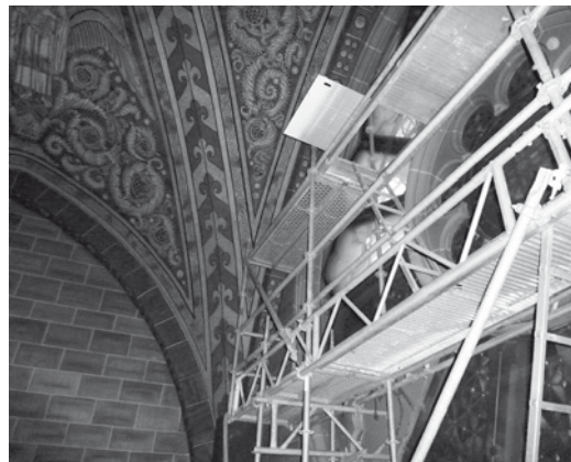
Abb. 21 und 22 Gerüstbau mittels Abhängung des Gerüsts durch ausgebaute Fenster
