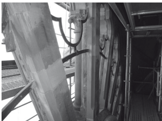
Abb. 31 Eingebaute Stahlbauteile mit fertigen Vierungen
