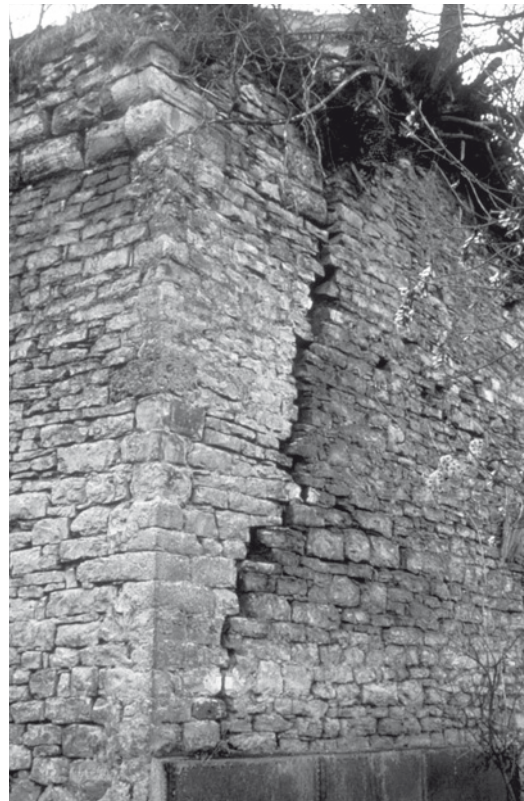
Abb. 5 Erhöhte Verschiebungen durch Wurzeldruck
