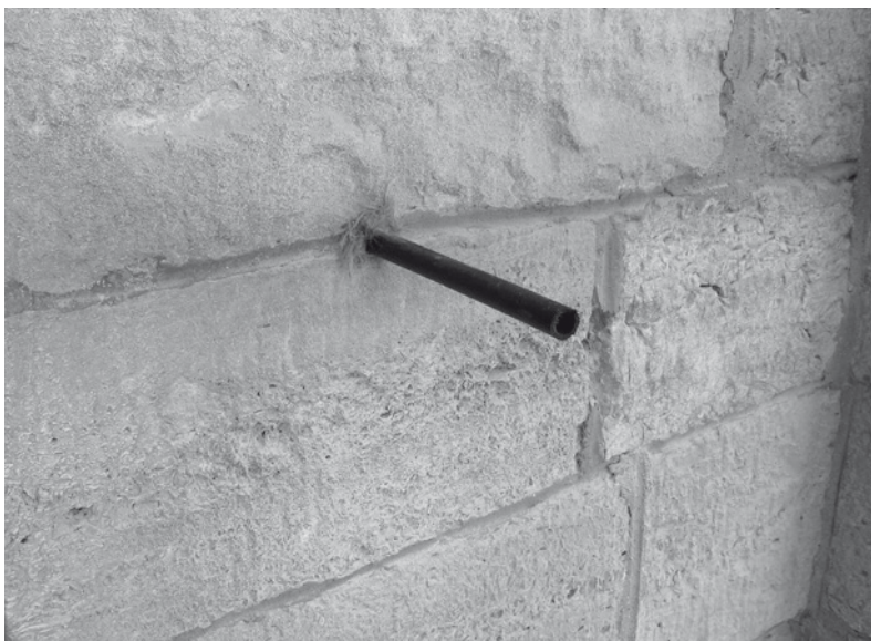
Abb. 10 Packer in einer Lagerfuge
