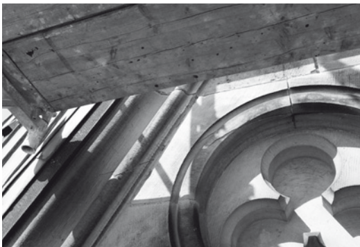
Abb. 8 und 9 Erkennbare Abplatzung im Giebelstein und dahinter liegende korrodierte Klammer
