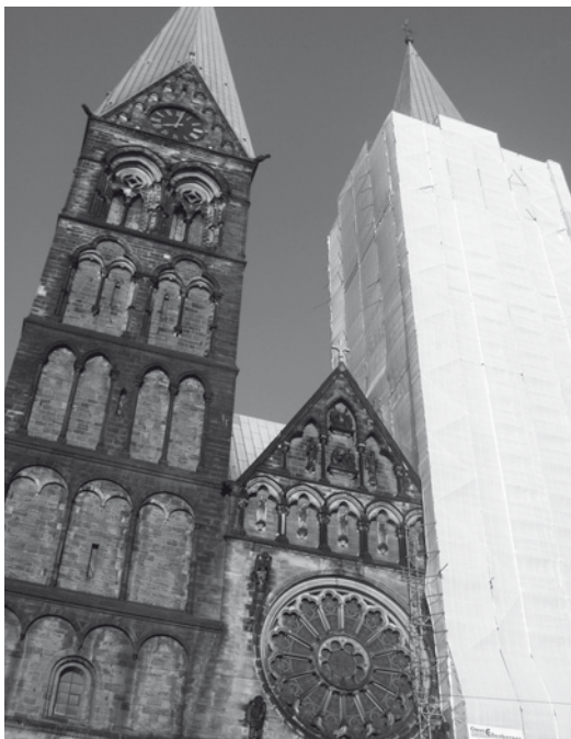
Abb. 19 Westansicht mit eingerüstetem Südturm. Am Nordturm ist die Gliederung der Fassade durch Oberkirchner- und Portasandstein erkennbar.
