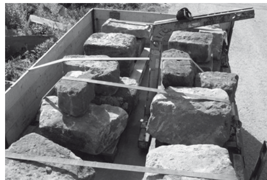
Abb. 12 und 13 Steinmaterial aus Zweitverwendung: Lagerung, Transport und Verwendung auf der Baustelle
