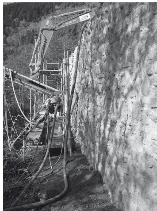
Abb. 8 Bohrarbeiten für Bodenvernagelung
