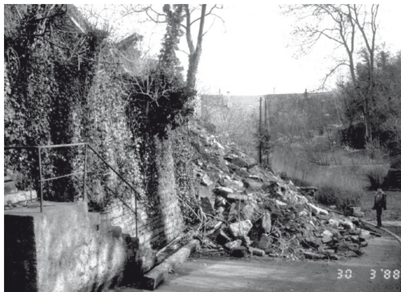
Abb. 1 Unvorhergesehenes Teilversagen einer Mauer
