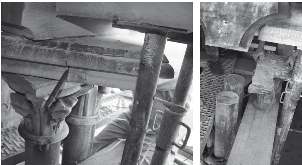
Abb. 5 und 6 Lösen der Abakusplatten und Ausbau der Kapitelle
