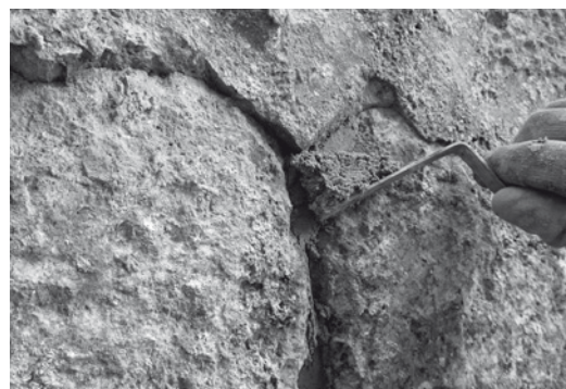
Abb. 8 Anbösch des neuen Fugenmörtels an den Bestandsfugenmörtel
