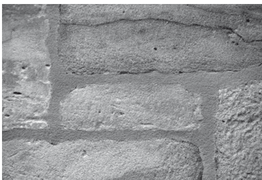
Abb. 7 Fugenmörtel bündig mit den Steinoberflächen
