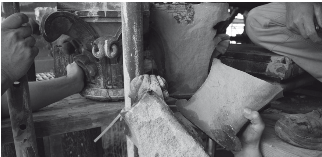
Abb. 7 Die Kapitelle fielen nach dem Ausbau teilweise gleich auseinander.
