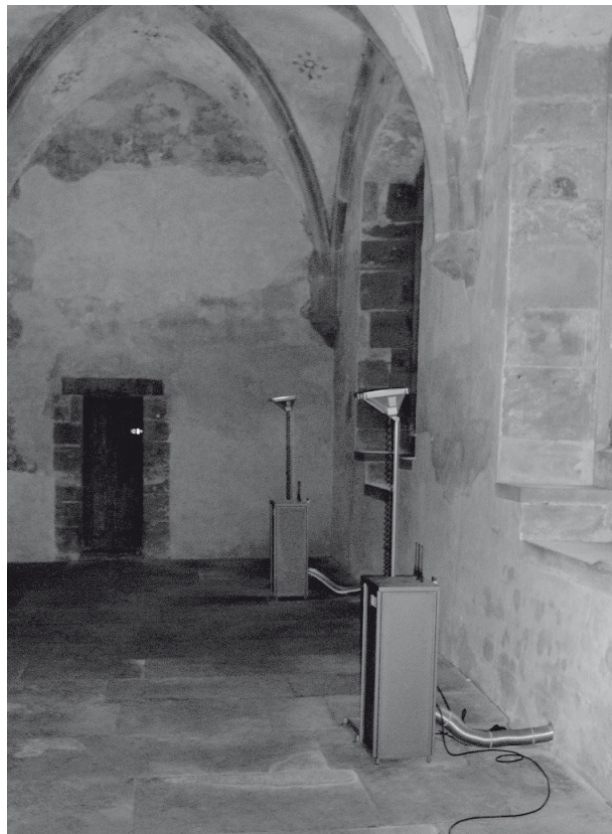
Abb. 1 Lüftereinrichtung für den Einsatz im Dormentbau des Maulbronner Klosters
