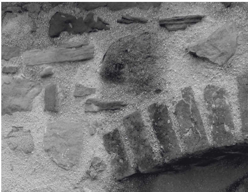
Abb. 9 Bruchstein-Mischmauerwerk nach der Verfugung im Trockenspritzverfahren
