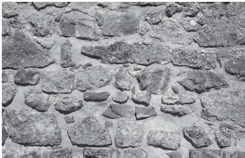
Abb. 3 Bruchsteinmauerwerk mit hohem Mörtelanteil
